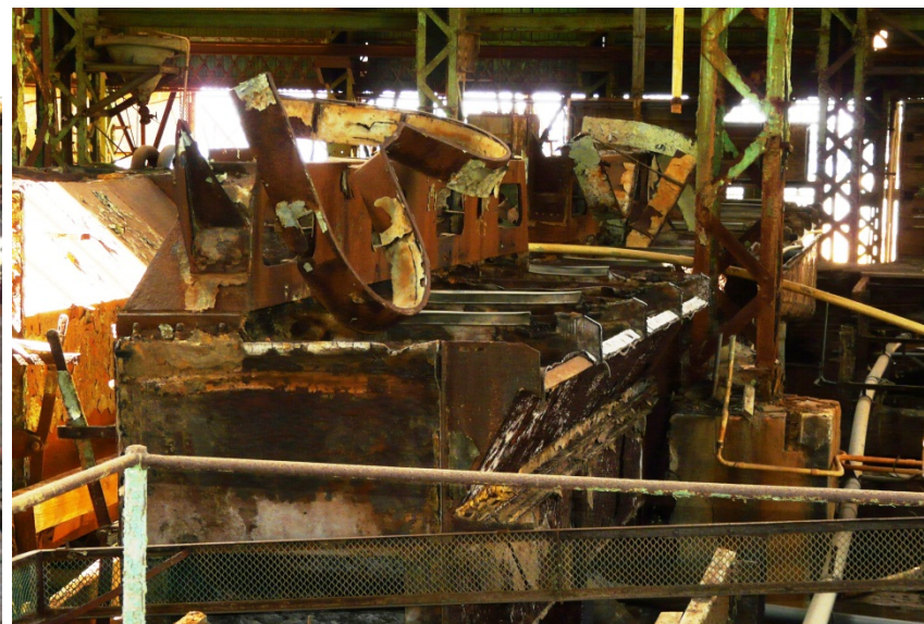
36, 37 y 38. Estado actual de la zona de flotación con restos de baterías de celdas de flotación.
