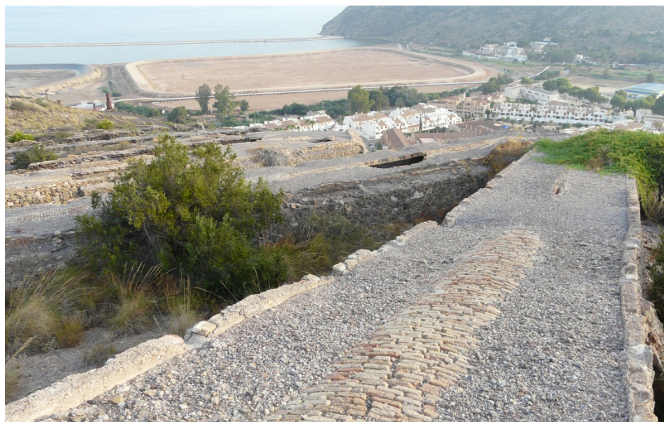
11. Detalle de la parte superior de la galería de humos-serpentin.
