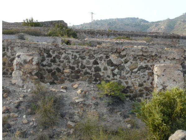
13. Detalle de los contrafuertes exteriores de la galería de humos-serpentin de la chimenea de la fundición Orcelitana.
