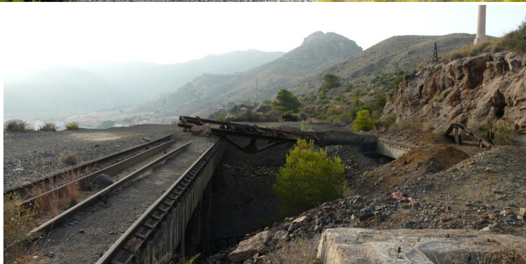
7, 8 y 9. Estado actual de la parte final del trazado de la vía férrea donde se encontraba la tolva de descarga del mineral con restos de elementos metálicos de la antigua maquinaria.
