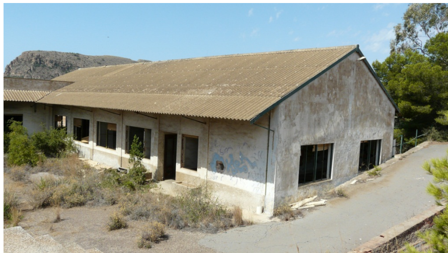
48. Estado actual del edificio de laboratorios (C.E.A.M: Centro de Estudios y Análisis Mineralúrgicos).
