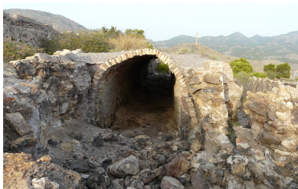
12. Tramo del serpentín de la chimenea de la fundición Orcelitana en el que se aprecia su sistema constructivo.
