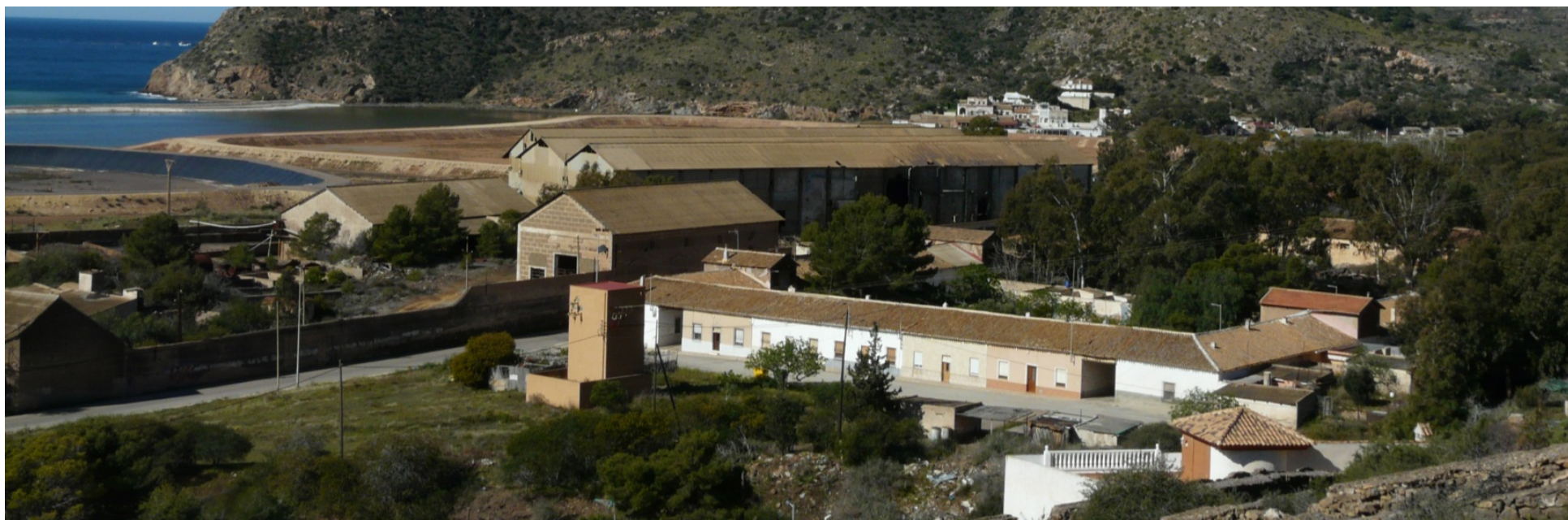
1 y 2. Vistas generales del estado actual del lavadero de flotación diferencial Roberto situado junto a la bahía de Portmán.
