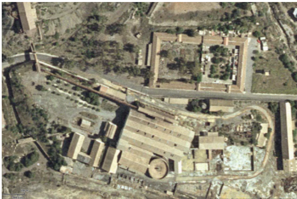
59. Ortofoto SITMURCIA 2002 con la cinta transportadora y la tolva parabólica.
