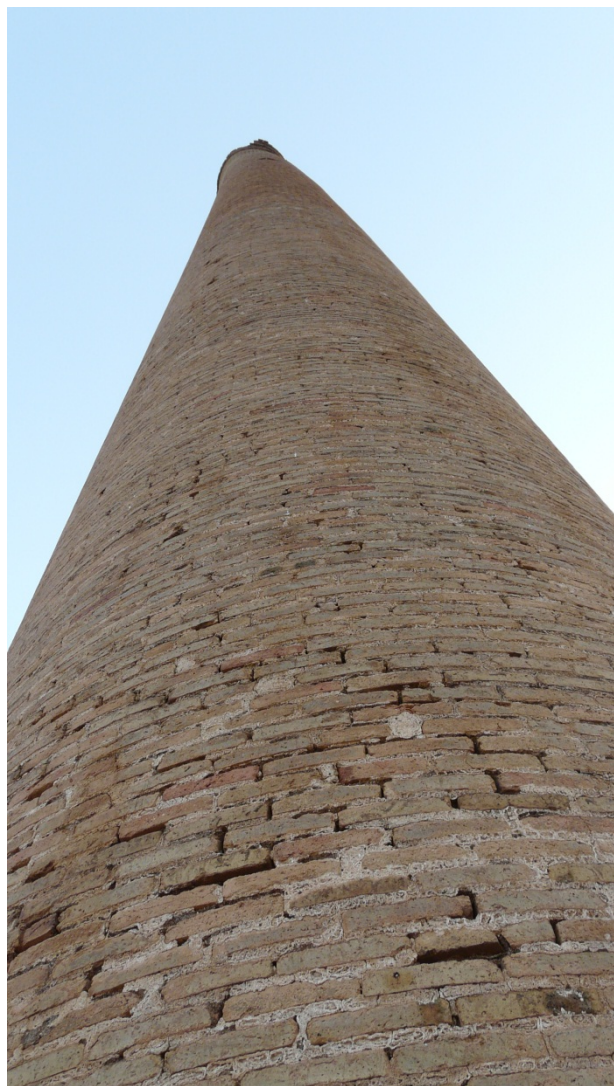
31 y 32. Detalle de los ladrillos macizos que conforman el cuerpo cilíndrico de la chimenea de la fundición Orcelitana.
