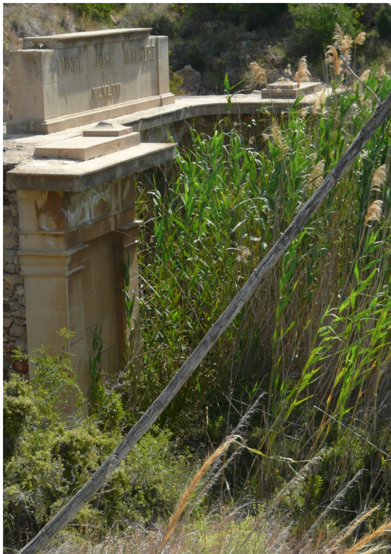
2. Vista de la entrada del túnel José Maestre en 2017.
