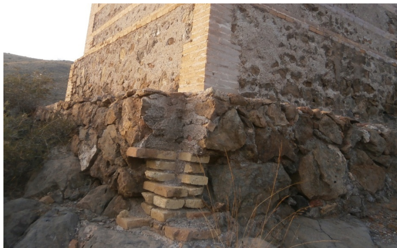
25. Detalle de la cimentación fabricada en mampostería y ladrillo macizo sobre la que se asienta el basamento de la chimenea de la fundición Orcelitana.
