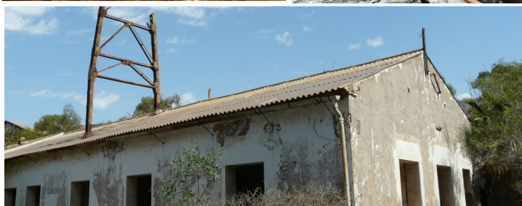
46 y 47. Restos de las estructuras metálicas del transporte por cinta desde la nave de Trituración Secundaria y el lavadero Roberto desmantelado en el año 2003.
