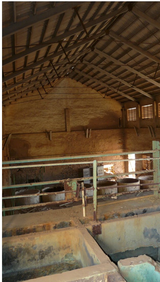
20 y 21. Estado actual del interior y de las cerchas de madera con tirantes metálicos de la cubierta de la nave de reactivos del lavadero Roberto.
