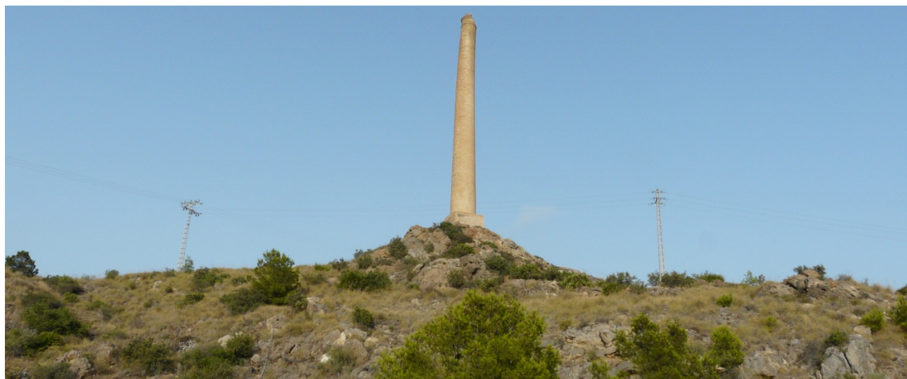
1, 2 y 3. Vistas generales del estado actual de la chimenea de la fundición Orcelitana.
