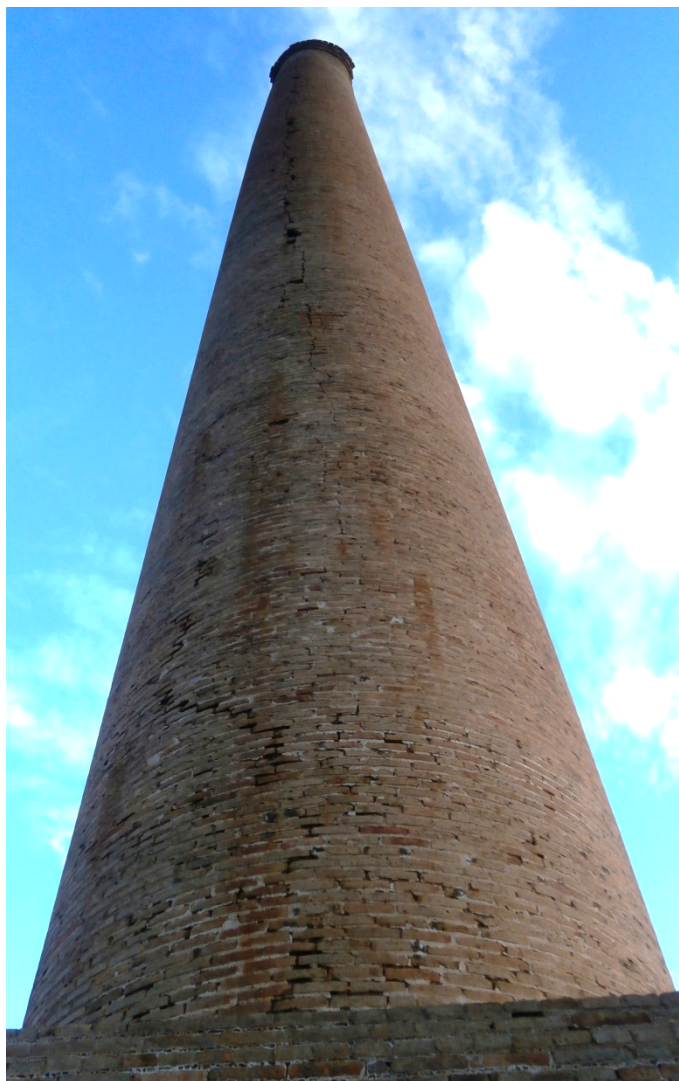
31 y 32. Detalle de los ladrillos macizos que conforman el cuerpo cilíndrico de la chimenea de la fundición Orcelitana.
