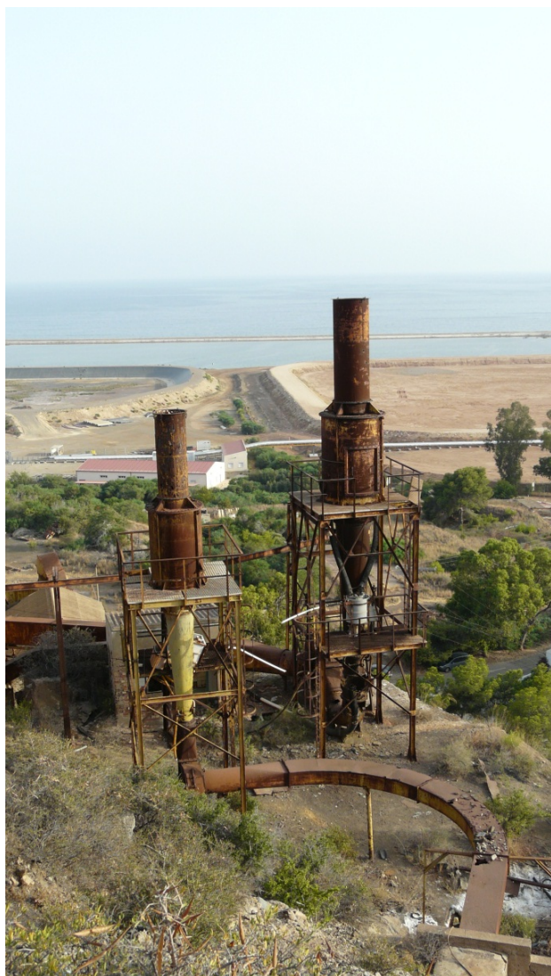
18, 19 y 20. Estado actual de las chimeneas de evacuación del polvo en la planta de molienda primaria del lavadero Roberto.
