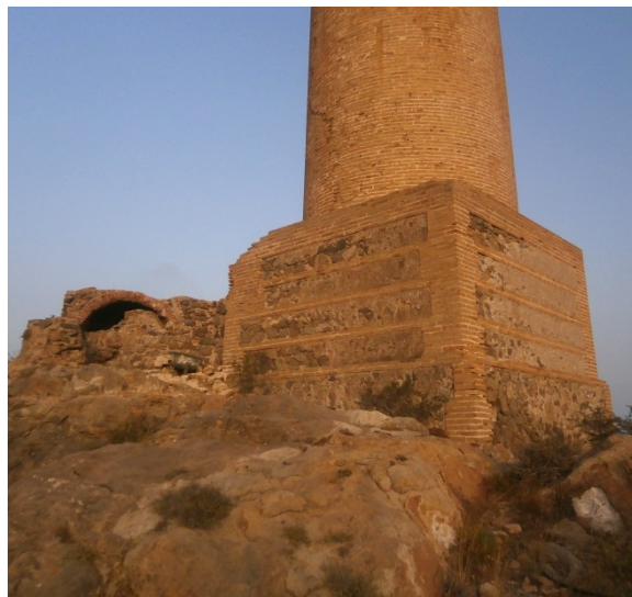
22, 23 y 24. Estado actual de la parte inferior o basamento de planta cuadrada de la chimenea de la fundición Orcelitana.
