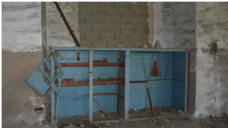
10. Detalle de armarios y estanterías en el interior de la nave de talleres del lavadero Roberto.
