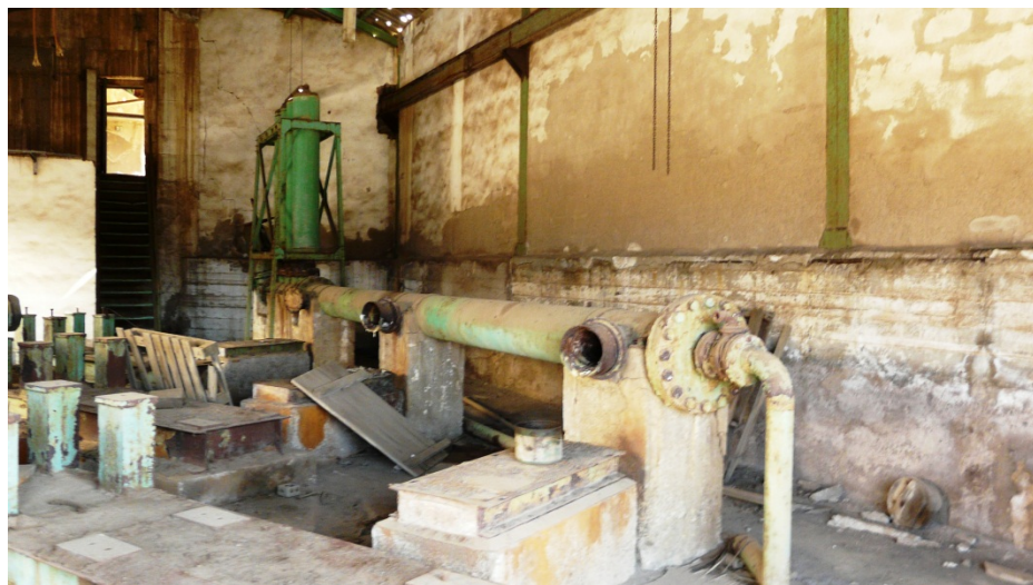
52. Estado actual del interior de la estación de bombeo de estériles del lavadero Roberto.
