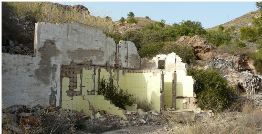
16. Estado actual de la edificación auxiliar cercana a la entrada del túnel José Maestre dedicada a vestuario y sala de duchas.
