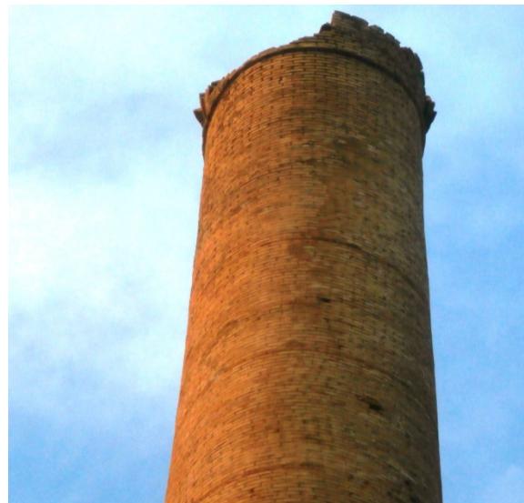
26 y 27. Estado actual de la parte superior o coronación de la chimenea de la fundición Orcelitana.
