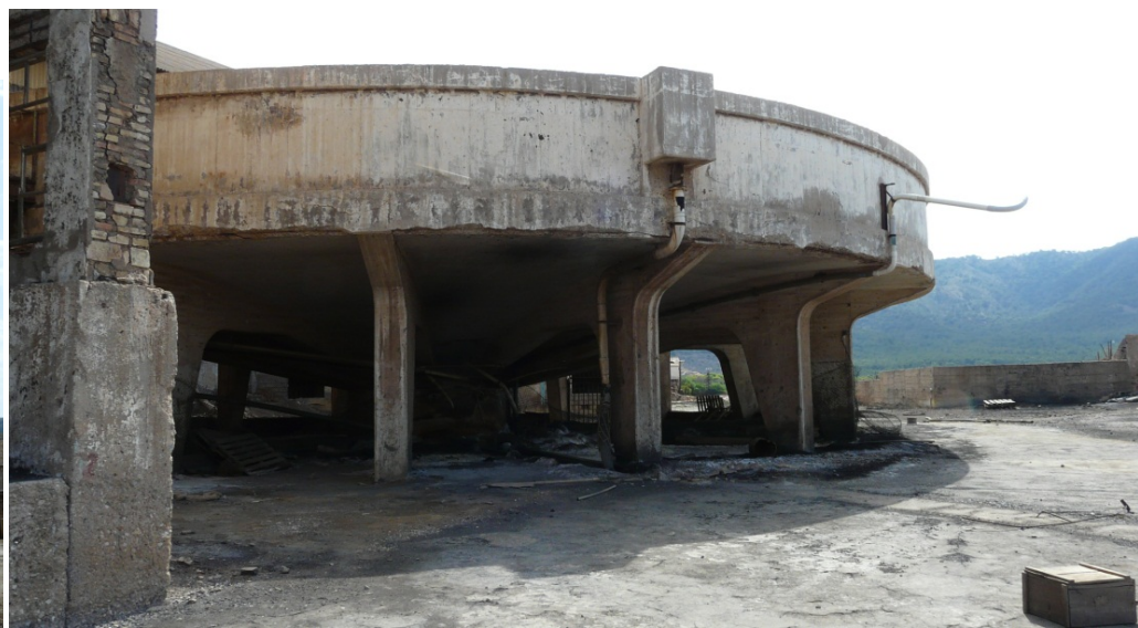
50 y 51. Estado actual del tanque espesador cuya misión era restar humedad a los concentrados de mineral.
