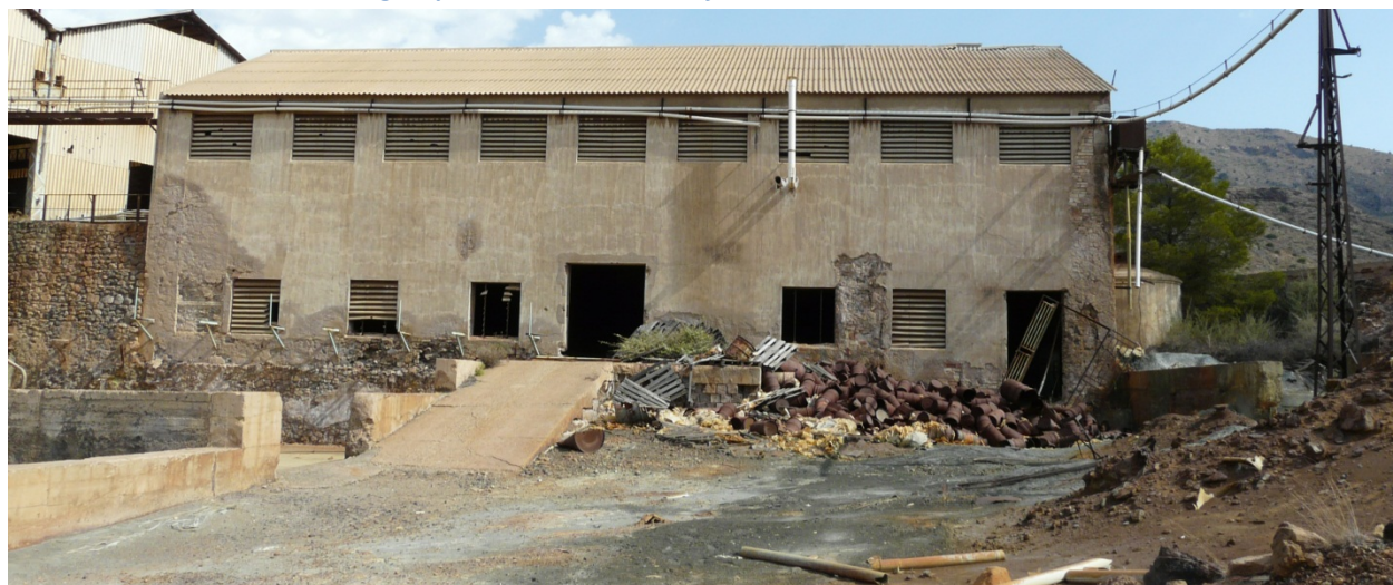
18. Estado actual del exterior de la nave de reactivos del lavadero Roberto.
