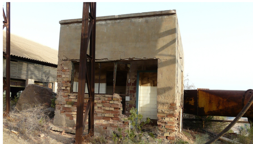
27 y 28. Edificación auxiliar a la nave de molienda del lavadero Roberto usada como aseo y sala de duchas.
