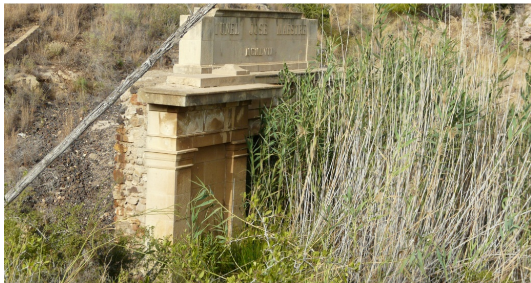
5. Estado actual de la entrada del túnel José Maestre entre una espesa vegetación de carrizo.
