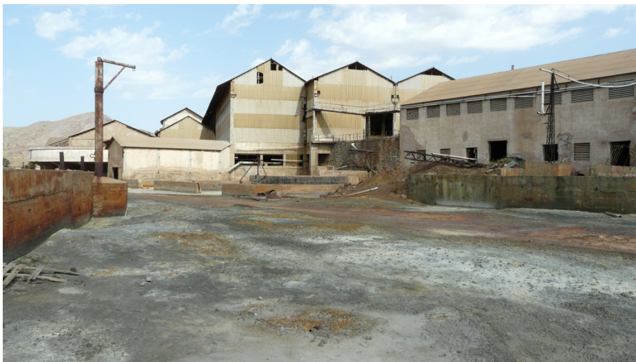
56. Estado actual de las grandes balsas de secado de mineral del lavadero Roberto.
