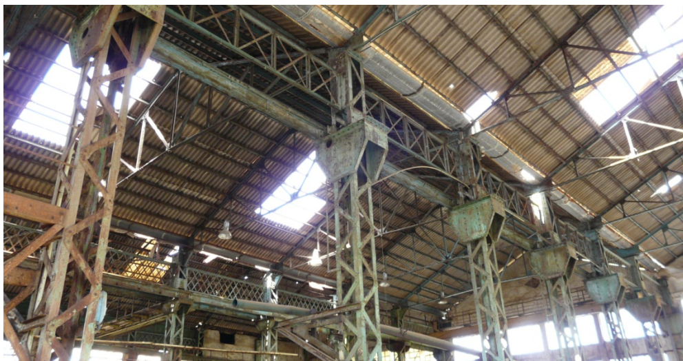
39. Estado actual de las estructuras metálicas de la cubierta de la nave de molienda y flotación.
