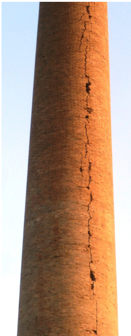
28 y 29. Estado actual de la gran grieta que recorre el lado norte del fuste de la chimenea de fundición Orcelitana.
