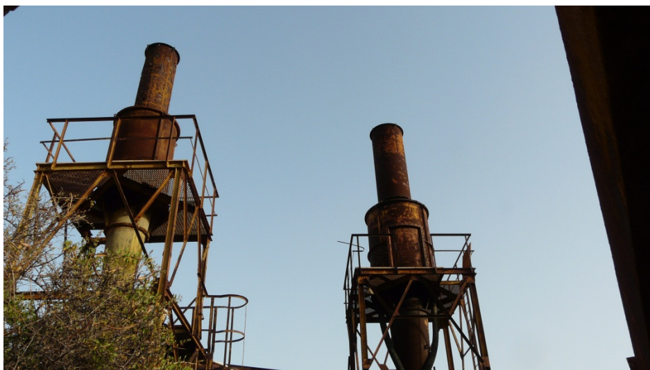
21 y 22. Estado actual de las chimeneas de evacuación del polvo en la planta de molienda primaria del lavadero Roberto.
