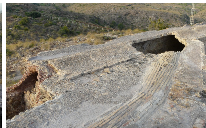
14 y 15. Bifurcación de la galería de humos-serpentin en las cercanías de la chimenea de la fundición Orcelitana.
