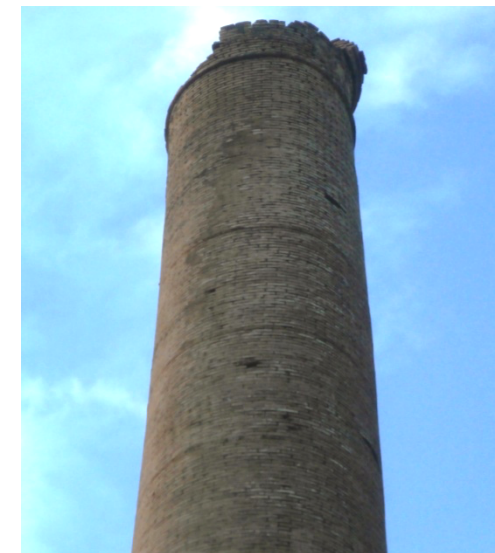
26 y 27. Estado actual de la parte superior o coronación de la chimenea de la fundición Orcelitana.
