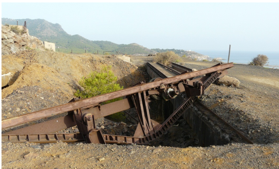
6. Estado actual de la tolva de descarga de los vagones de mineral que abastecía la molienda del lavadero Roberto.
