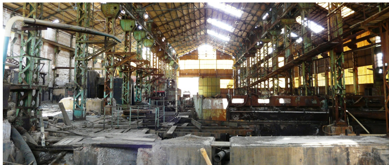
27. Estado actual del interior de la gran nave de molienda y flotación del lavadero Roberto.
