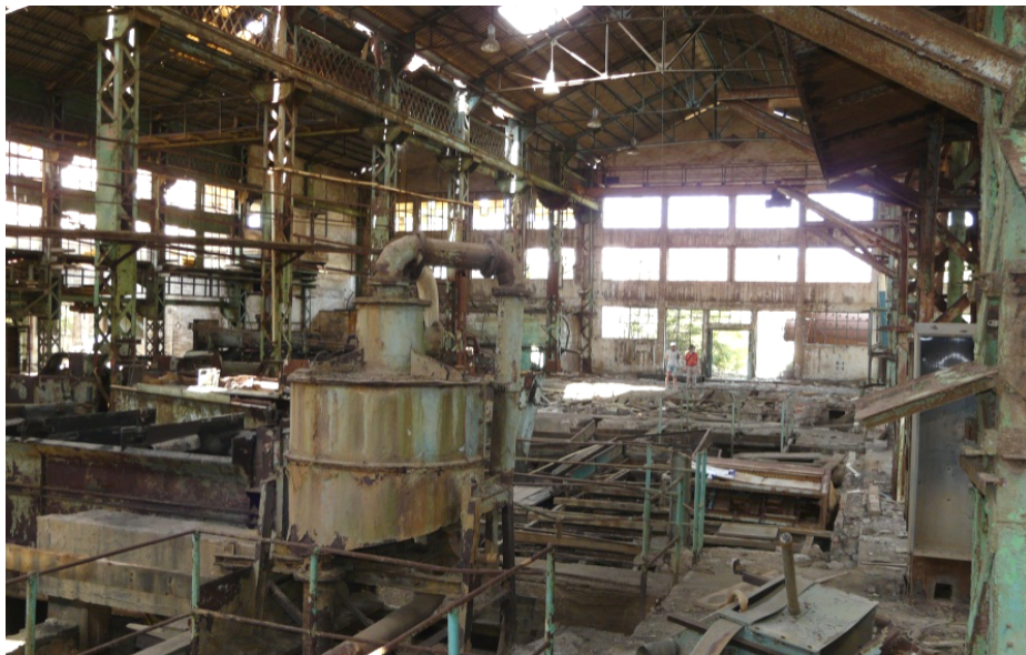
35. Estado actual del interior de la gran nave de molienda y flotación del lavadero Roberto.
