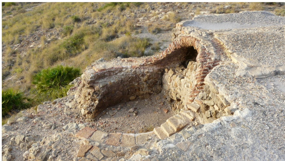
16. Estado actual del basamento o cimentación de otra chimenea desaparecida anexa a la actual chimenea de la fundición Orcelitana.
