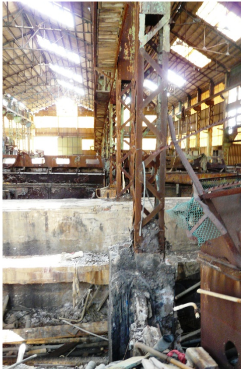
43, 44 y 45. Estado actual de algunos pilares y estructuras metálicas de la nave de molienda y flotación del lavadero Roberto en los que se aprecia un alto grado de corrosión.
