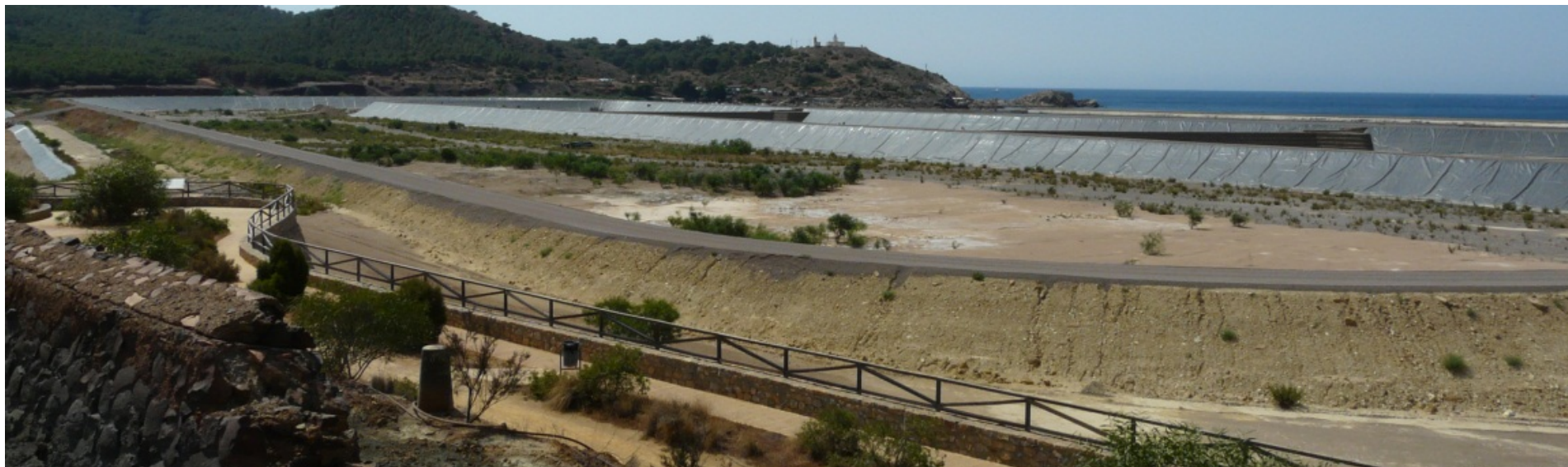
58. Panorámica de la bahía de Portmán desde la planta de concentración de mineral del Lavadero Roberto. Se aprecian las infraestructuras construidas para las obras de regeneración.
