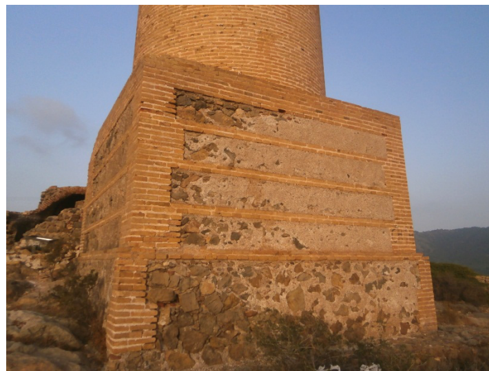
22, 23 y 24. Estado actual de la parte inferior o basamento de planta cuadrada de la chimenea de la fundición Orcelitana.
