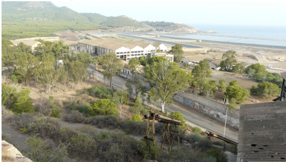
26. Instalaciones del lavadero Roberto desde la planta de trituración secundaria.
