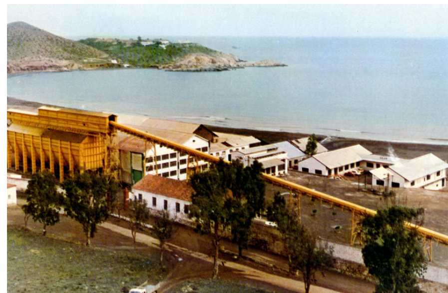
60. Imagen histórica del Lavadero Roberto en 1970 con la cinta transportadora y la tolva parabólica (Foto MTI Blog).
