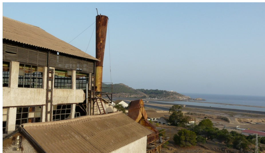
21 y 22. Estado actual de las chimeneas de evacuación del polvo en la planta de molienda primaria del lavadero Roberto.
