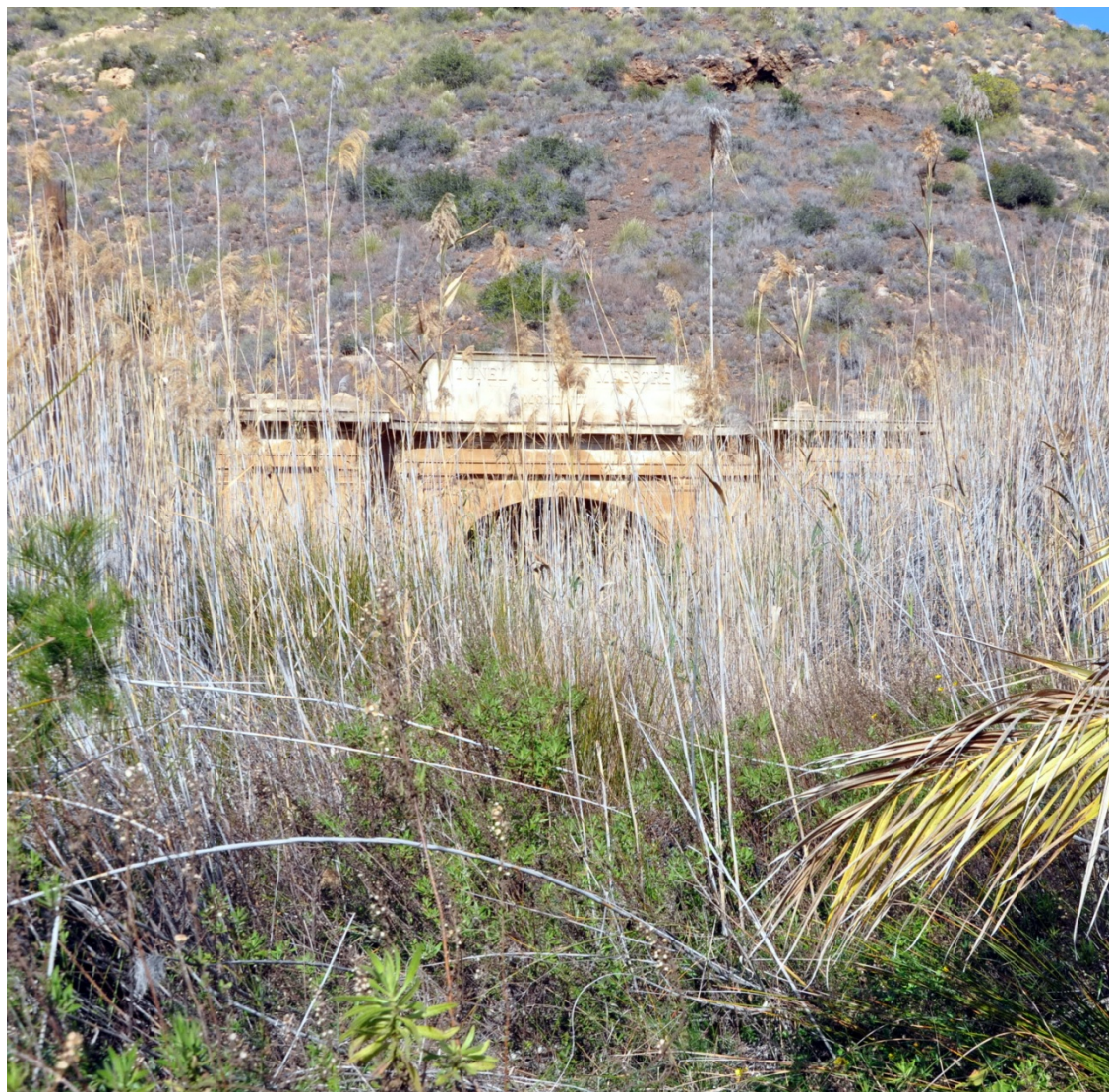
3. Vista de la entrada del túnel José Maestre en 2013.
