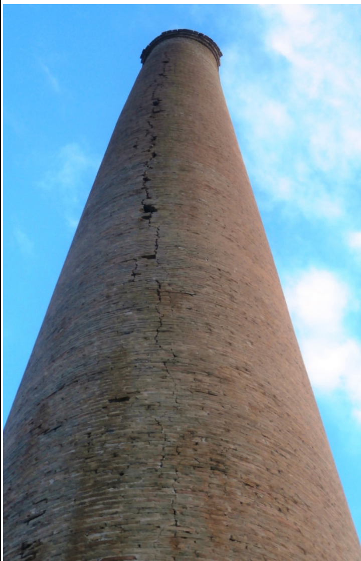
28 y 29. Estado actual de la gran grieta que recorre el lado norte del fuste de la chimenea de fundición Orcelitana.
