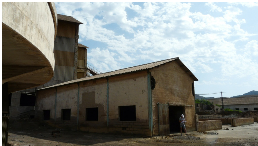
49. Estado actual del exterior de la estación de bombeo de estériles.
