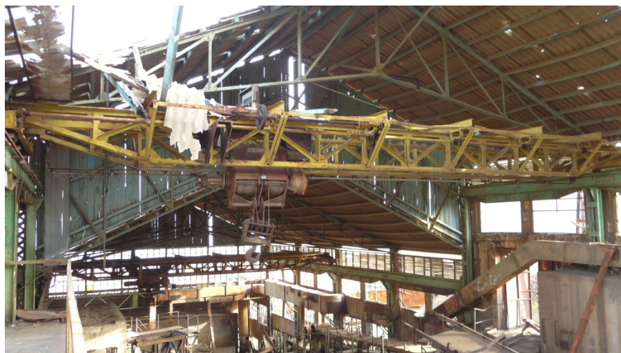
12 y 13. Estado actual de la gran viga metálica con grúa puente en el interior de la nave de molienda del lavadero Roberto.
