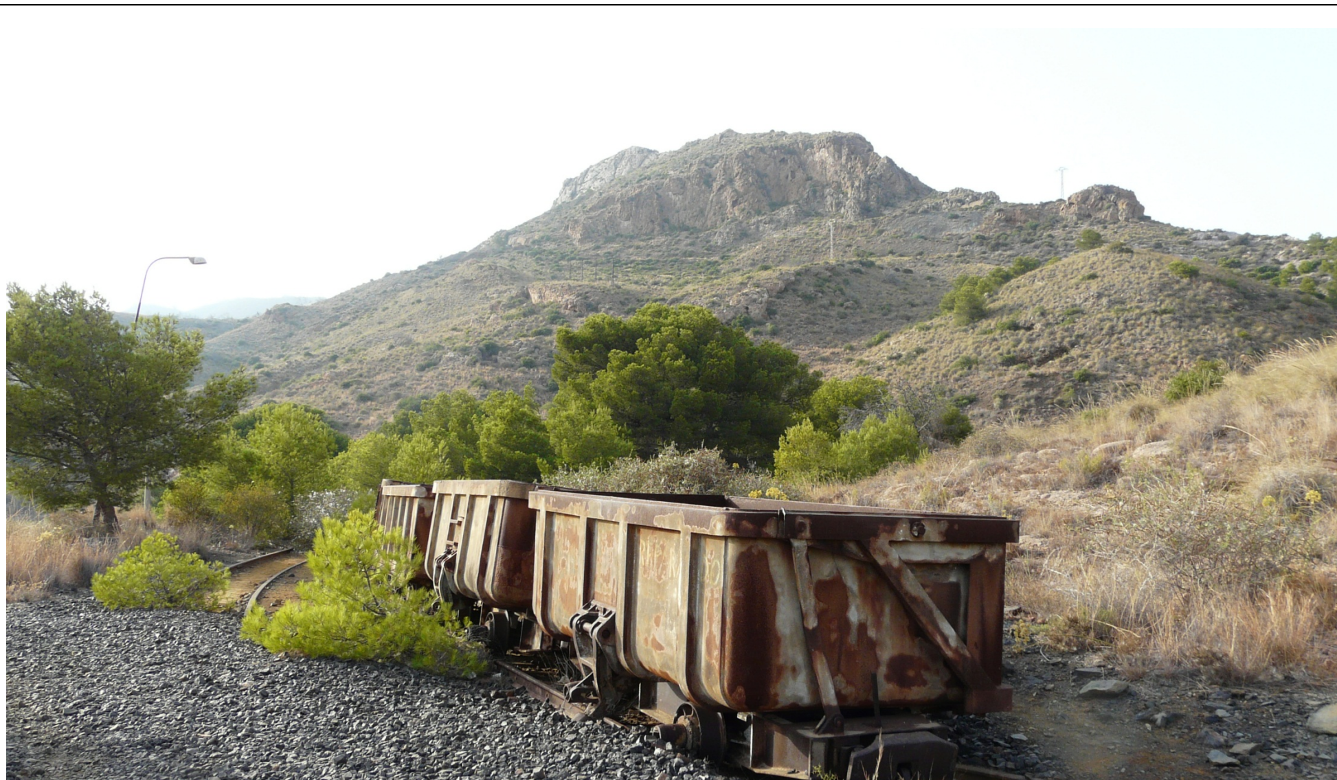
1. Vista general del estado actual del trazado de la vía férrea en las proximidades del túnel José Maestre donde todavía se pueden ver vagonetes y locomotoras del antiguo tren minero.
