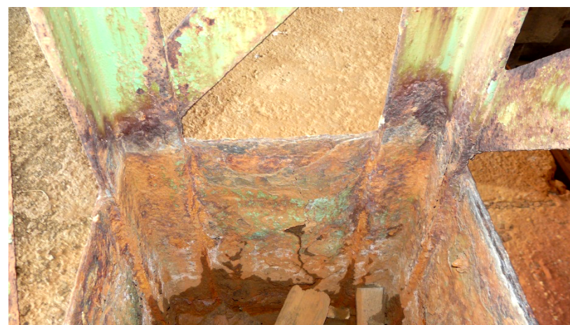
43, 44 y 45. Estado actual de algunos pilares y estructuras metálicas de la nave de molienda y flotación del lavadero Roberto en los que se aprecia un alto grado de corrosión.
