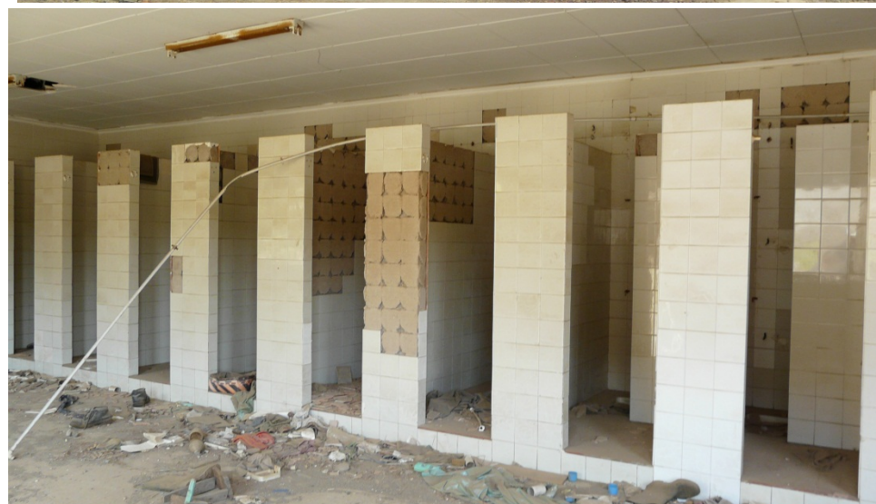
54 y 55. Estado actual del exterior e interior del edificio de vestuarios y sala de duchas del lavadero Roberto.
