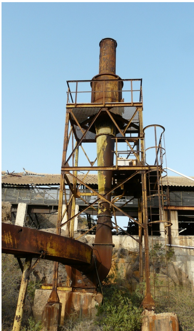
18, 19 y 20. Estado actual de las chimeneas de evacuación del polvo en la planta de molienda primaria del lavadero Roberto.
