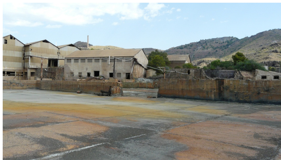
53. Estado actual de las grandes balsas de secado de mineral del lavadero Roberto.
