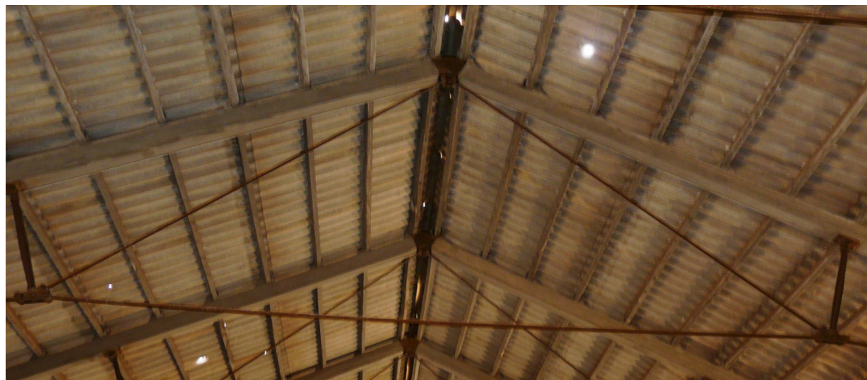
19. Estado actual de las cerchas de madera con tirantes metálicos de la cubierta de la nave de reactivos.
