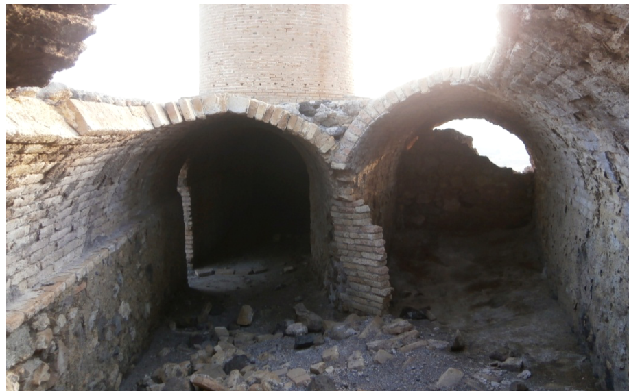
16. Estado actual del basamento o cimentación de otra chimenea desaparecida anexa a la actual chimenea de la fundición Orcelitana.
