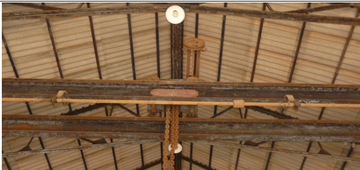
16. Estado actual de la grúa puente de la nave de forja del lavadero Roberto.
