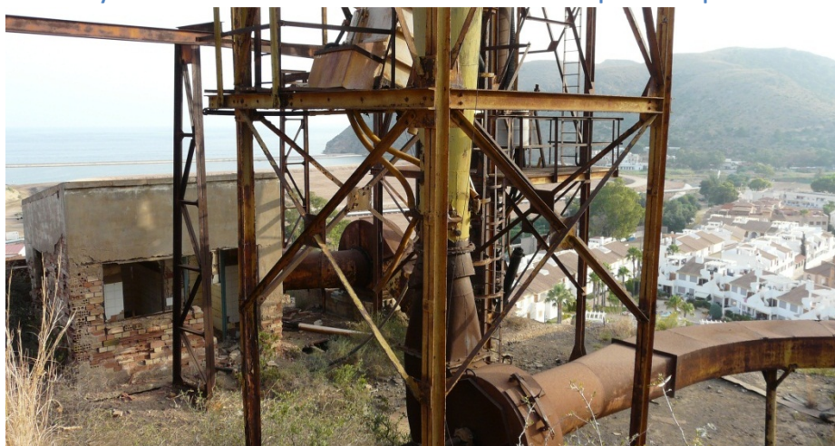
23 y 24. Conducciones y tuberías de aspiración y conducción del polvo hasta las torres de evacuación en forma de chimenea. En algunas de estas estructuras metálicas se aprecia un grado de corrosión muy intenso.
