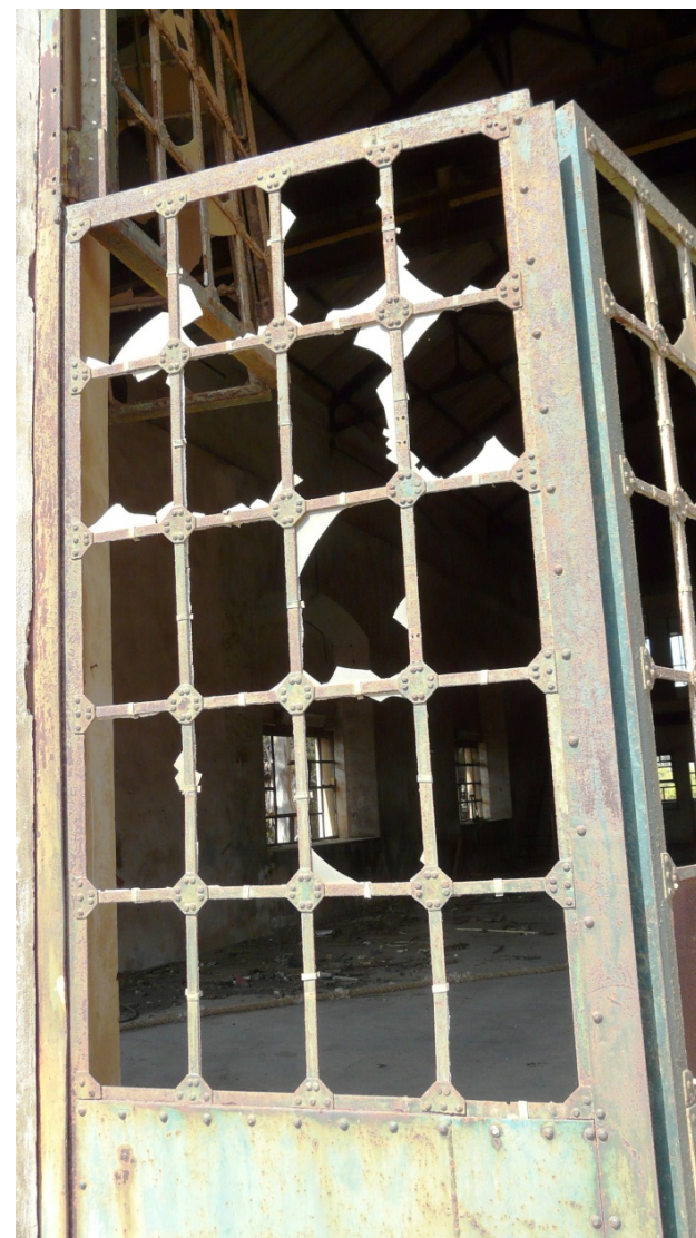
17. Detalle de la puerta principal de la nave de forja.
