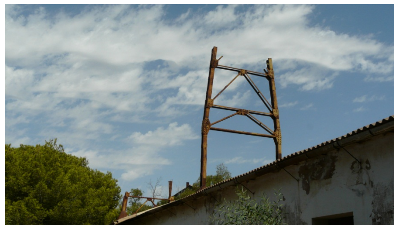
46 y 47. Restos de las estructuras metálicas del transporte por cinta desde la nave de Trituración Secundaria y el lavadero Roberto desmantelado en el año 2003.
