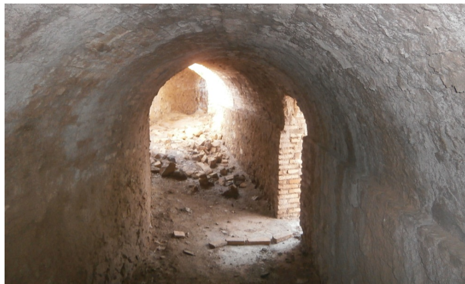
17, 18 y 19. Estado actual del interior de la galería de humos-serpentin de la chimenea de la fundición Orcelitana.
