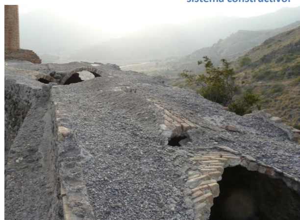
14 y 15. Bifurcación de la galería de humos-serpentin en las cercanías de la chimenea de la fundición Orcelitana.
