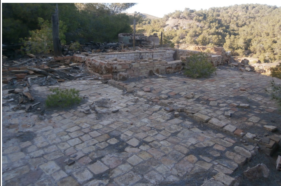
23 y 24. Zona de flotación y secado del mineral pavimentada con ladrillo macizo del lavadero de la mina Consuelo II.
