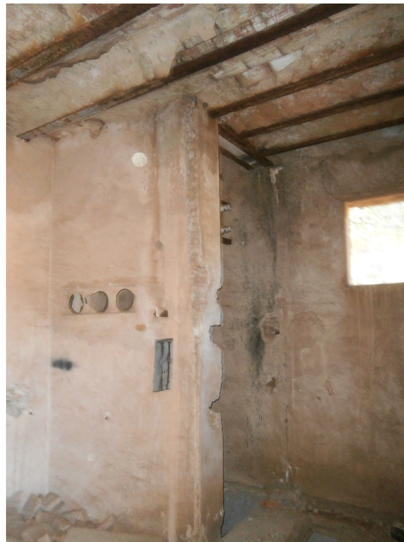
9. Estado actual del interior del centro de transformación de electricidad de la mina Santo Tomás.
