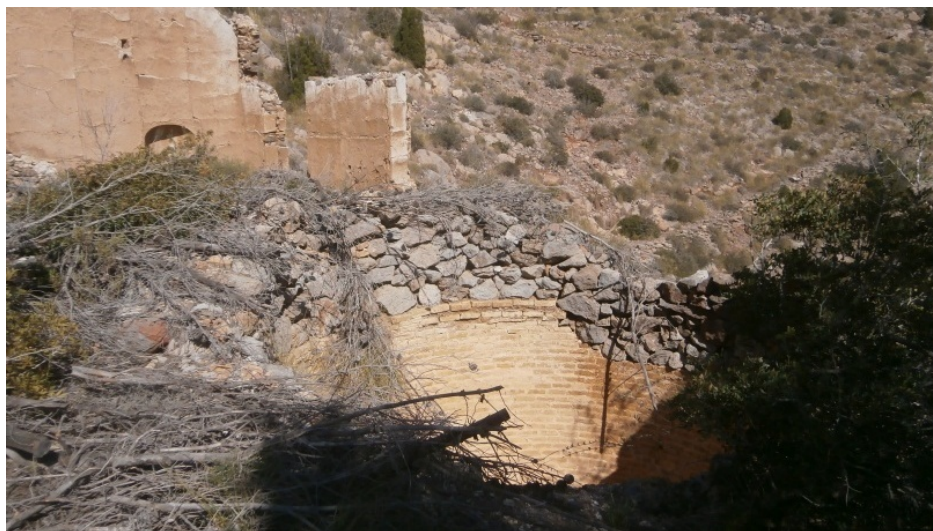
17 y 18. Estado actual del pozo sin brocal C-1400 localizado en la zona oriental de las instalaciones minero-metalúrgicas de la mina La Montaña.
