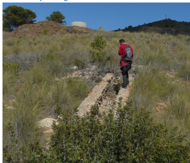
15 y 16. Conducción utilizada como galería de evacuación de humos desde la sala de calderas de la mina Siete Dolores II.
