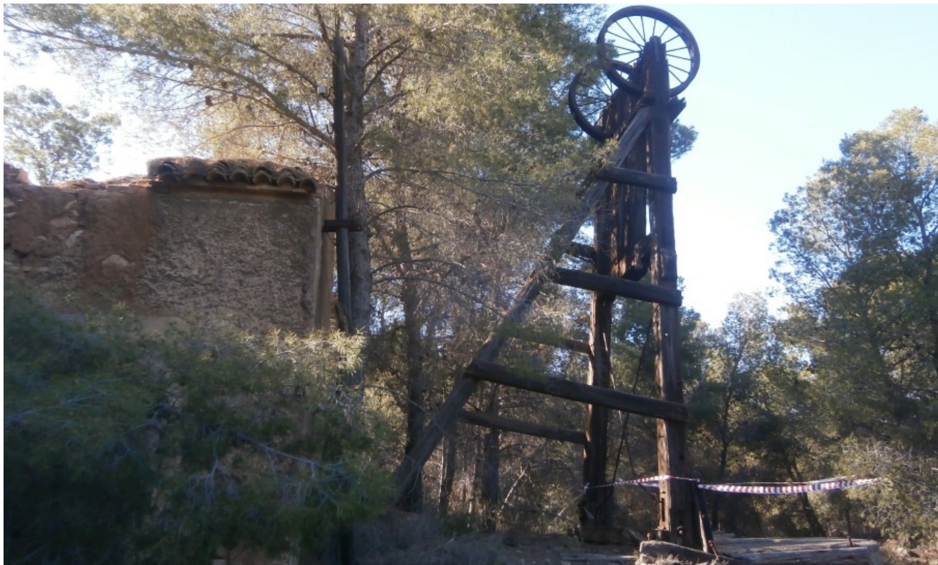
2. Estado actual del castillete y casa de máquinas de la mina Santo Tomás.
