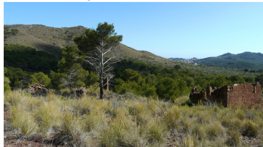
5. Vista general del estado actual de la construcción cercana al pozo maestro posiblemente utilizada como establo.
