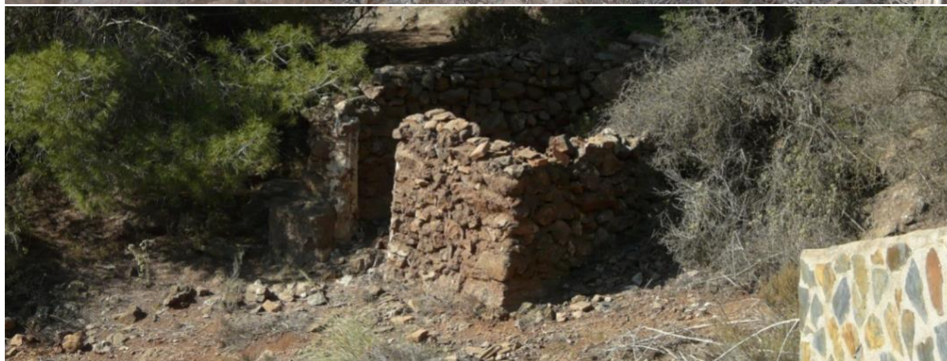
27. Construcciones auxiliares realizadas en mampostería de piedra en la mina Teresita.
