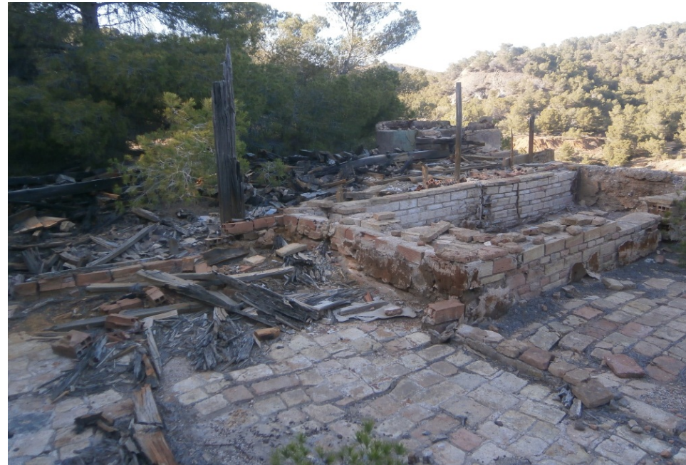
23 y 24. Zona de flotación y secado del mineral pavimentada con ladrillo macizo del lavadero de la mina Consuelo II.
