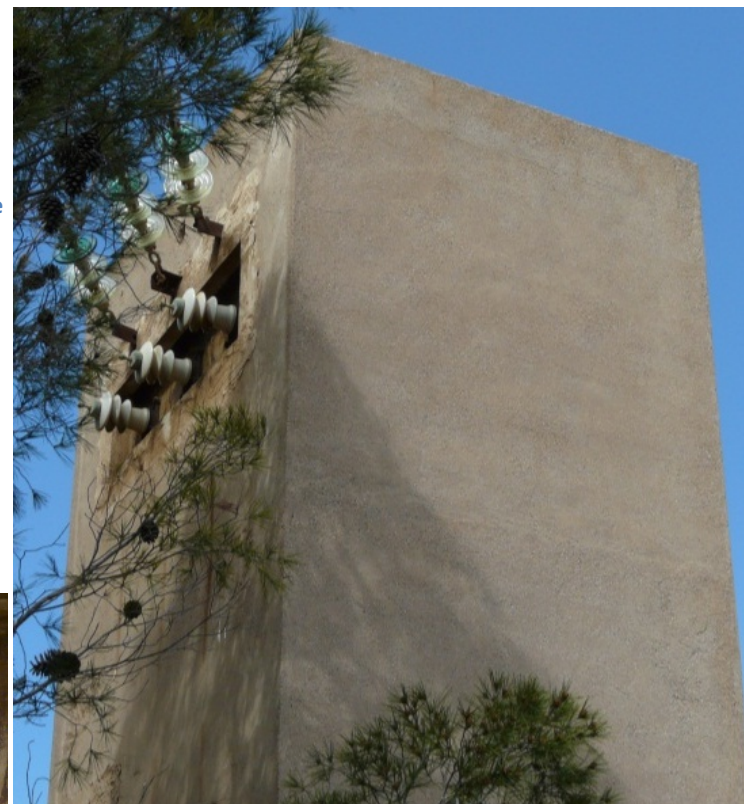
19. Torreta de planta cuadrada del centro de transformación de electricidad de la mina Secretaria.
