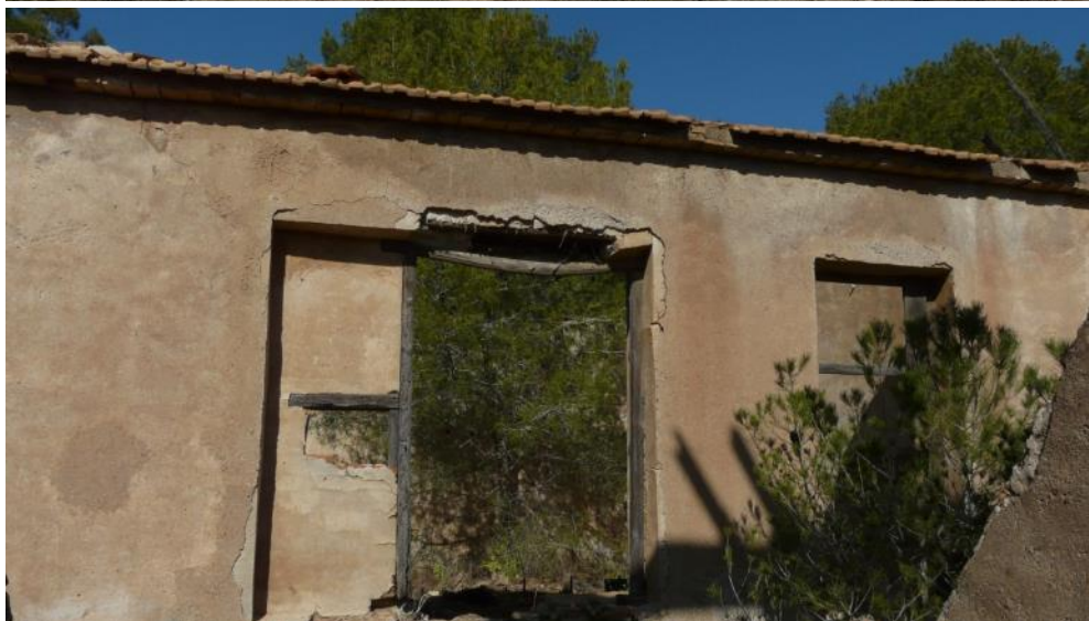
13 y 14. Estado actual del exterior de la casa de máquinas de la mina Teresita.
