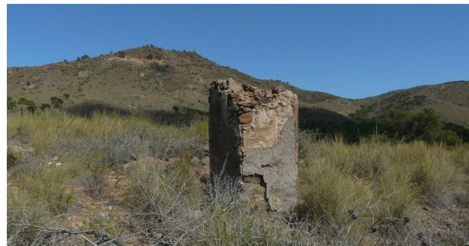
14 y 15. Estado actual de los pivotes de un antiguo malacate del pozo C-1394 en la concesión minera Siete Dolores I.
