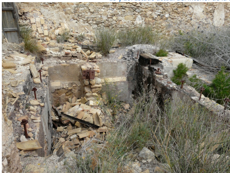
17. Restos del foso de la maquinaria de tracción.
