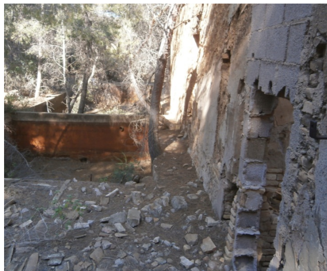
19. Detalle de uno de los muros de la casa de máquinas con una de las puertas de acceso tapiadas con bloques de hormigón que ha vuelto a ser abierta.
