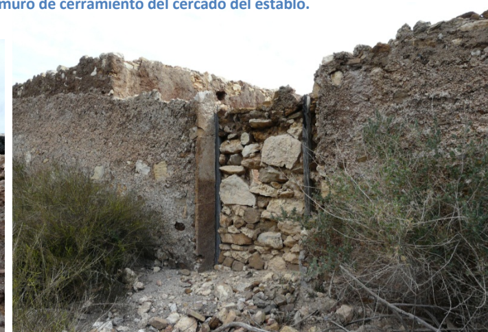
8, 9 y 10. Estado actual de las dependencias localizadas en el interior de los patios del establo. Se aprecian algunas vigas de madera calcinadas por el gran incendio que afectó a la zona el año 2011.
