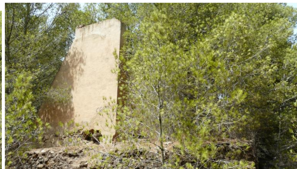
5. Estado actual del castillete de obra de la mina Candelaria.
