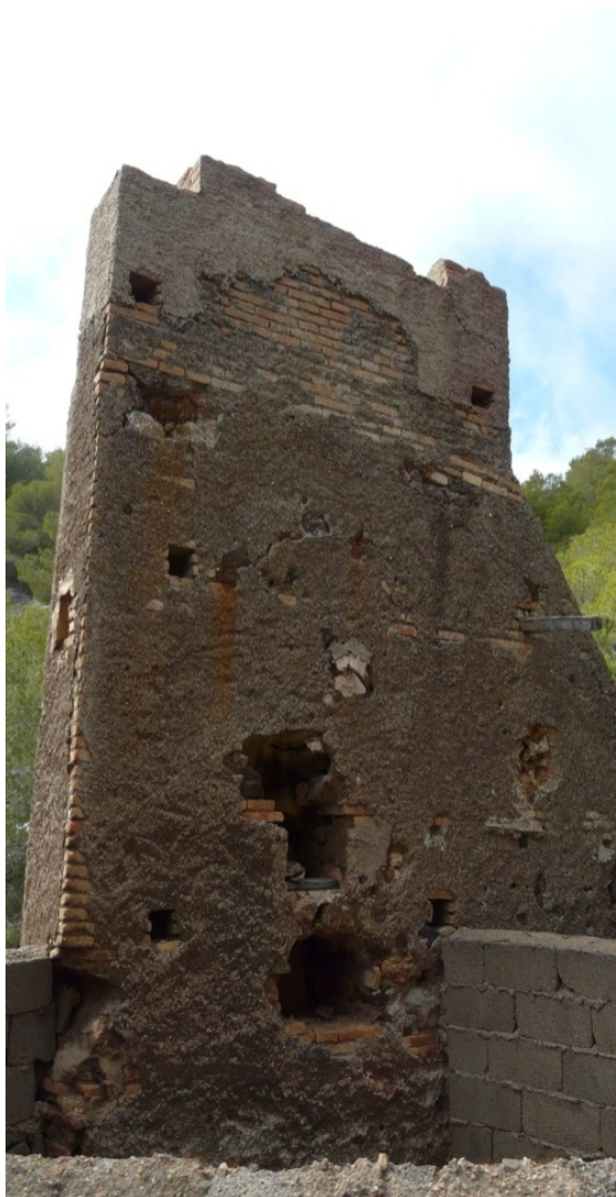
5 y 6. Detalle de los muros norte y sur del castillete de la mina San Dionisio.
