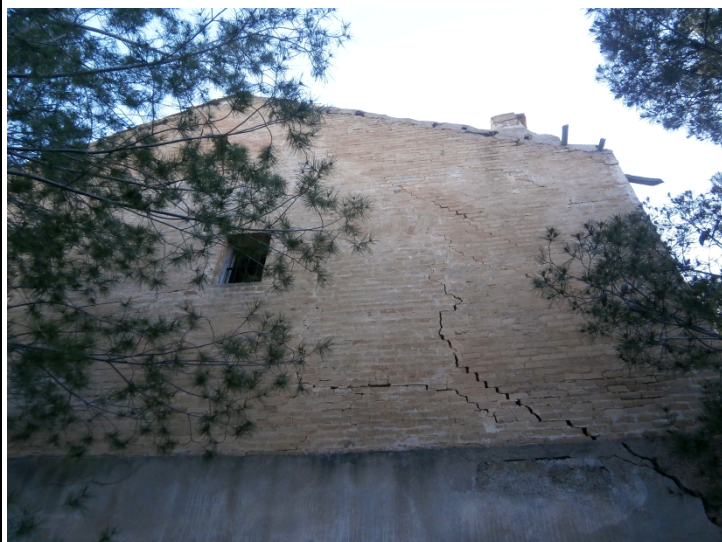
16. Estado actual del edificio de dos plantas usado como garaje y almacén-oficinas.
