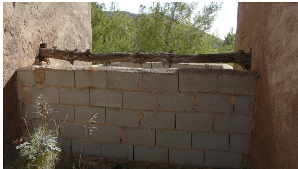
9. Brocal de cierre del pozo maestro realizado con bloques de hormigón.
