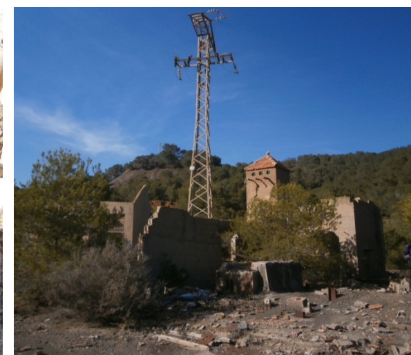
10. Estado actual del área de molienda del lavadero.
