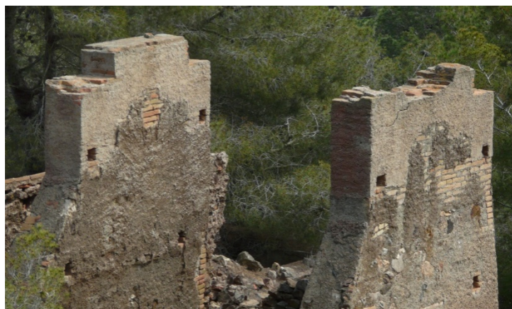
7. Parte superior del castillete donde se emplazaban las poleas.
