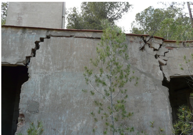
18. Detalle de uno de los muros del centro de transformación de electricidad con grandes grietas que ponen en peligro su estabilidad.
