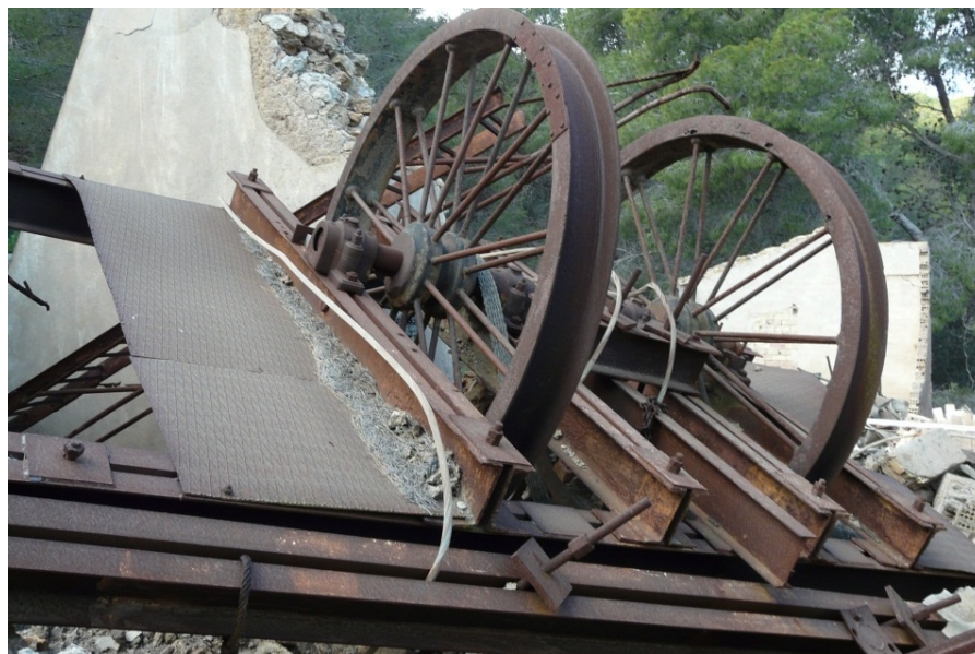
8, 9, 10 y 11. Detalle del estado actual de las poleas y elementos metálicos del castillete de la mina Secretaria.
