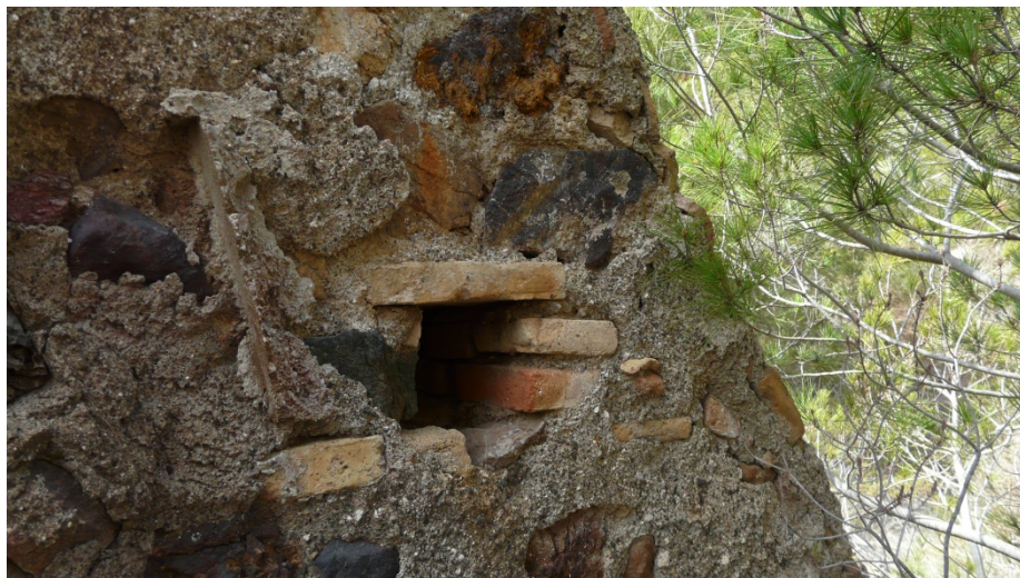
8. Detalle del muro del castillete.
