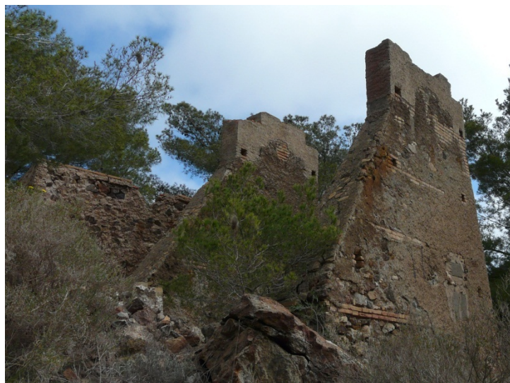
4. Estado actual del castillete de obra de la mina San Dionisio.
