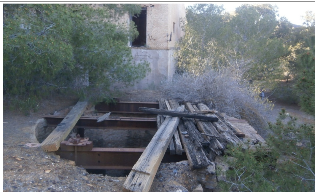
2. Pozo maestro de la mina Consuelo II parcialmente cubierto con vigas metálicas y tablonés de madera
