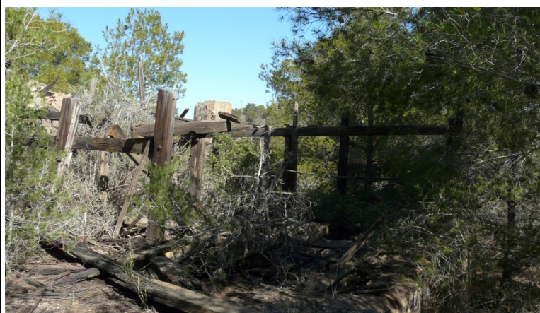
20, 21 y 22. Estructuras de madera pertenecientes al lavadero donde se haría la trititación y molienda del mineral en la mina Consuelo II.
