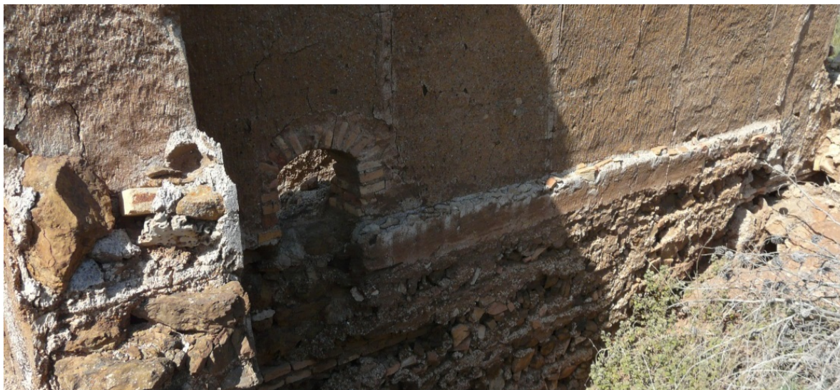
12 y 13. Apertura desde el muro oeste de la casa de máquinas hacia una posible galería de evacuación de humos en la mina Siete Dolores II.
