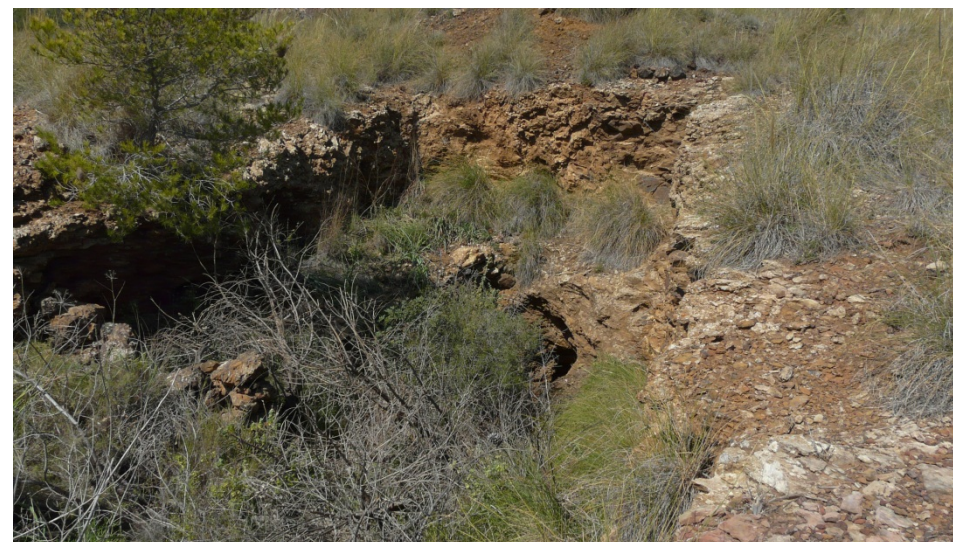
11. Estado actual de la entrada de la galería-rampa de acceso al minado de las instalaciones minero-metalúrgicas de la mina Siete Dolores I.
