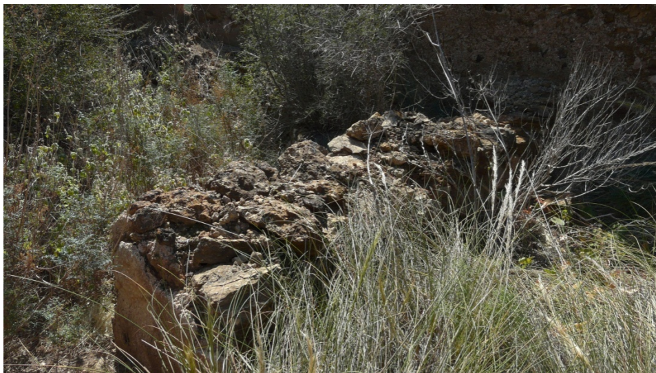
10. Detalle del muro bajo que divide el establo de la mina Siete Dolores I.
