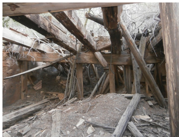
20, 21 y 22. Estructuras de madera pertenecientes al lavadero donde se haría la trititación y molienda del mineral en la mina Consuelo II.
