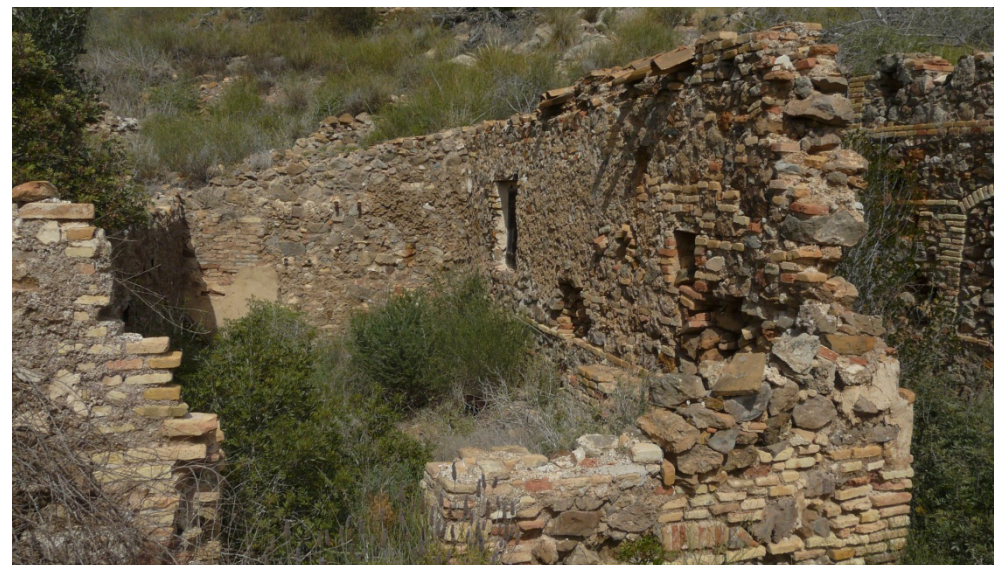
25. Otras edificaciones auxiliares en ruinas de la mina Más Alerta.
