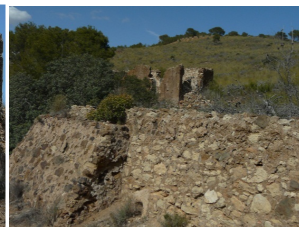
17, 18 y 19. Estado actual de los muros exteriores de la balsa anexa a la sala de máquinas y calderas de la mina Siete Dolores II.
