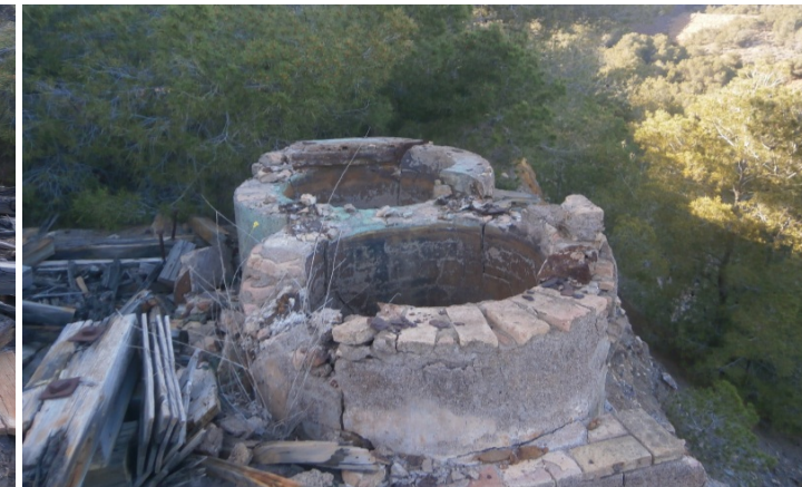
27. Balsas circulares para el abastecimiento de agua y reactivos químicos a la instalación.
