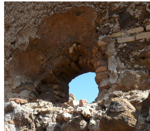
12 y 13. Apertura desde el muro oeste de la casa de máquinas hacia una posible galería de evacuación de humos en la mina Siete Dolores II.
