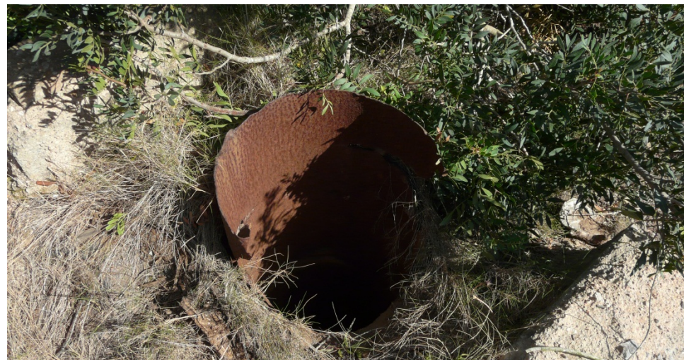
8. Estado actual del sondeo entubado de las instalaciones auxiliares de la mina La Cruz.
