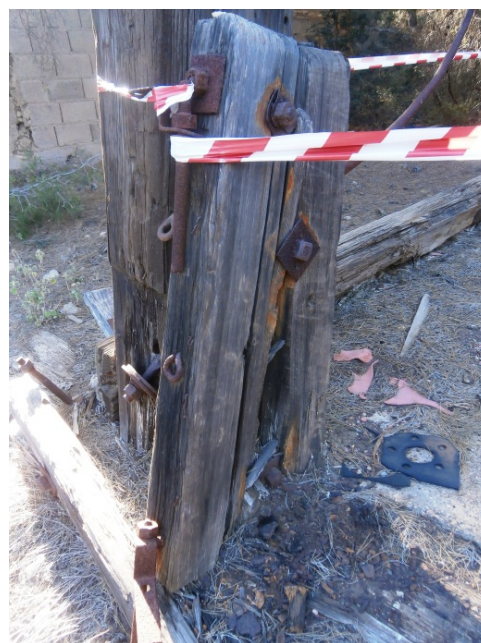
11, 12 y 13. Situación actual del estado de conservación de los pies del castillete con el deterioro de la madera que precisa una urgente restauración.
