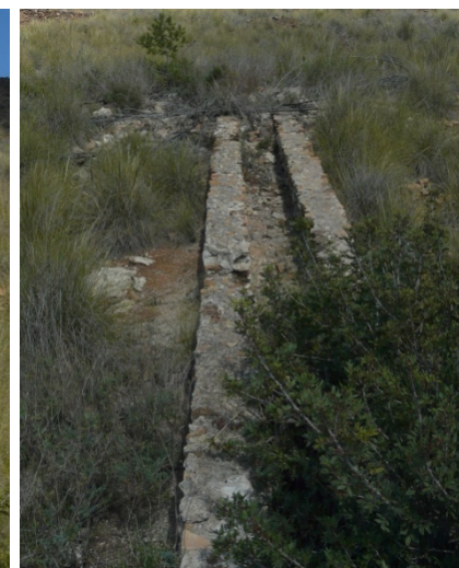
15 y 16. Conducción utilizada como galería de evacuación de humos desde la sala de calderas de la mina Siete Dolores II.
