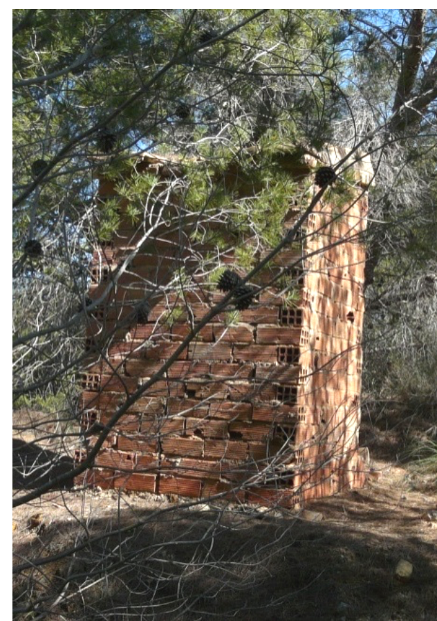
19. Pequeña caseta realizada en ladrillo hueco usada como retrete.
