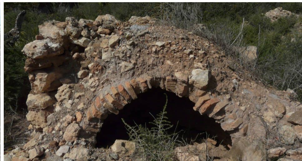
7. Restos de horno moruno de cúpula de media naranja existente en las instalaciones auxiliares de la mina La Cruz.
