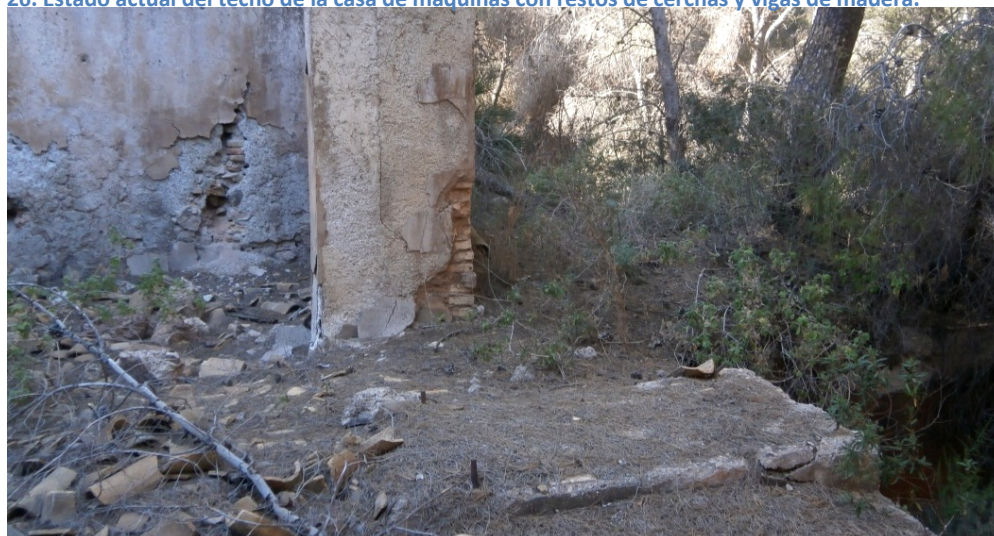
27. Estancia anexa a la casa de máquinas con cimentaciones y pernos metálicos de anclaje de maquinaria.
