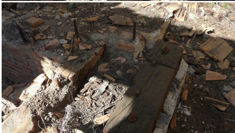
16 y 17. Foso donde se ubicaba la maquinaria de tracción.
