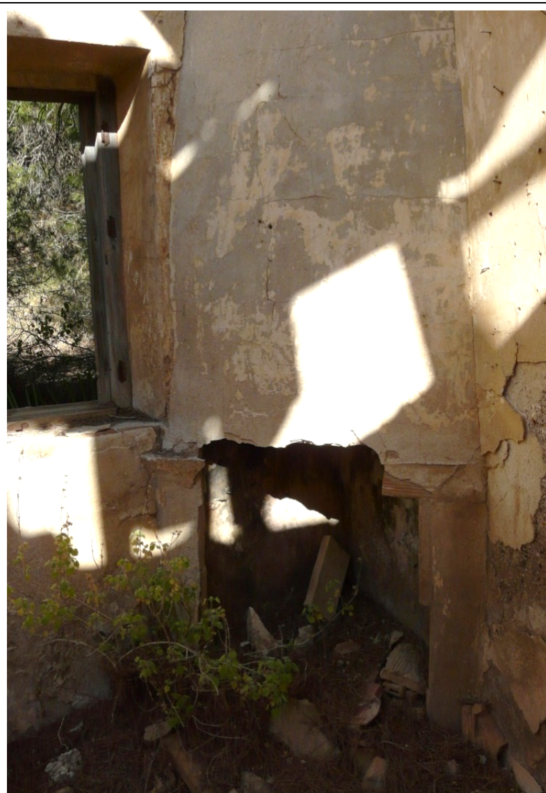
23. Restos de chimenea de la vivienda.
