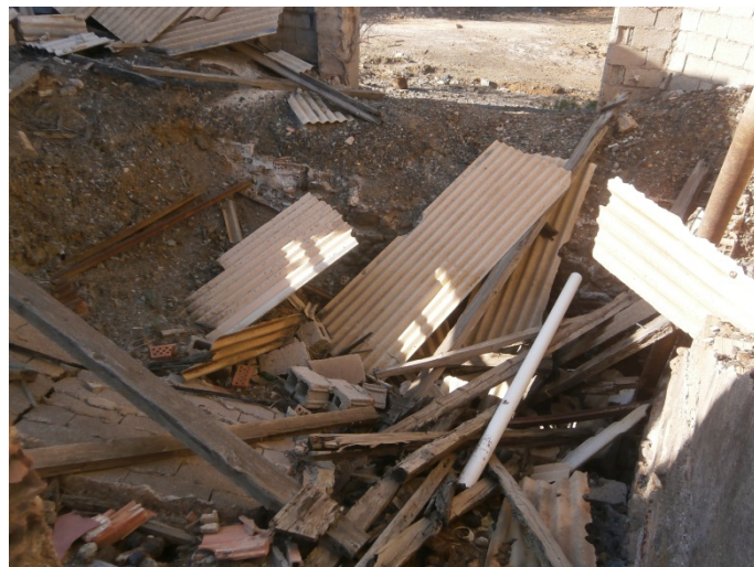
9. Estado actual del interior del edificio tolva del lavadero La Pinada.
