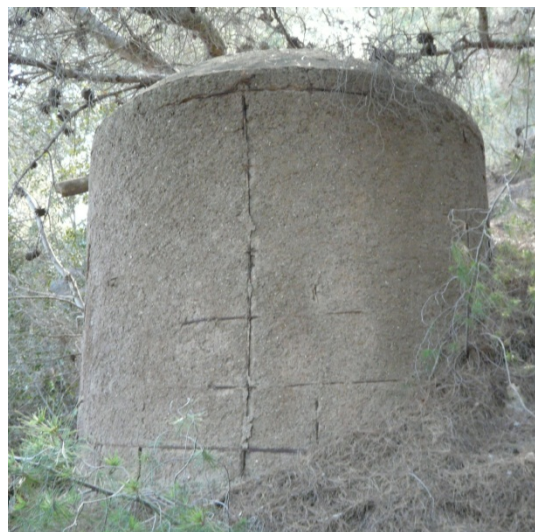
12 y 13. Depósito de agua construido en hormigón con refuerzos metálicos de la mina Secretaria.
