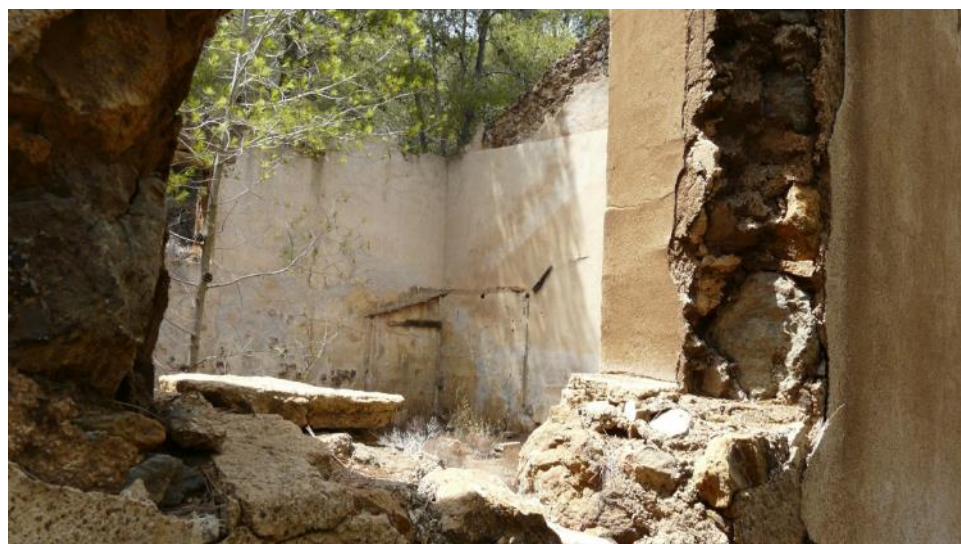
27, 28 y 29. Estado actual del interior de la edificación localizada al este del pozo maestro y que podría corresponder a un taller o garaje.
