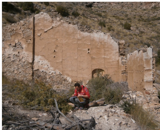
19. Estado actual de la casa de máquinas asociada al pozo sin brocal situado al este de las instalaciones minero-metalúrgicas de la mina La Montaña.
