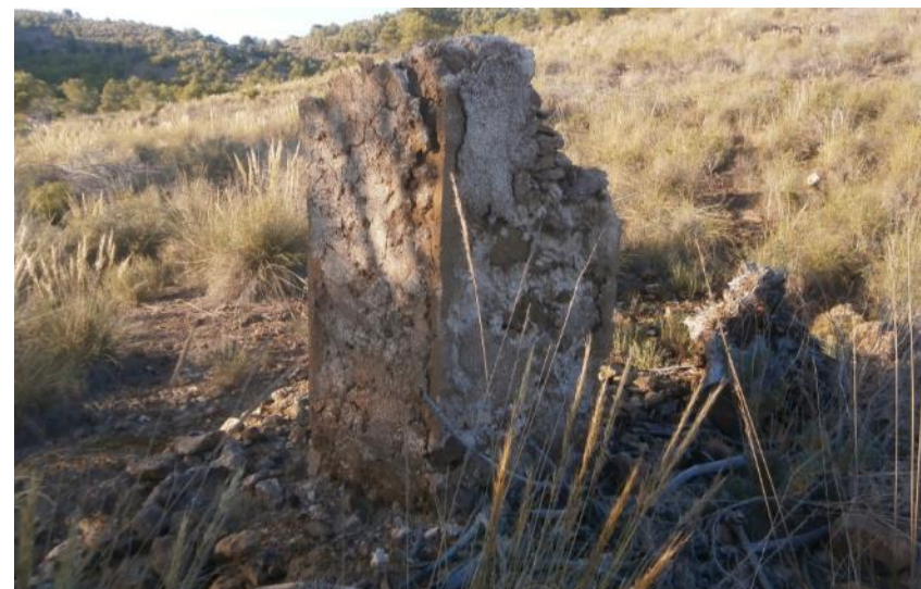
2 y 3. Estado actual de los pivotes de sustentación de un antiguo malacate existentes en las instalaciones minero-metalúrgicas de la mina Teresita.
