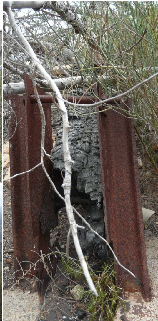
7, 8, 9 y 10. Restos del castillete de madera de la mina Más Alerta calcinados por el incendio de 2011.
