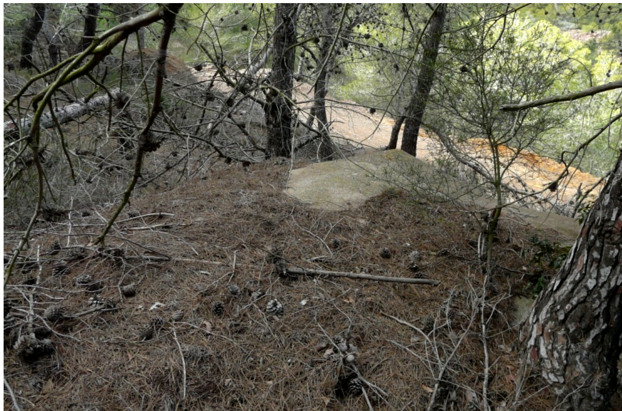
7. Techumbre a dos aguas del polvorín, casi completamente cubierta por ramas y hojas de pino.
