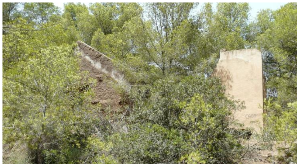
4. Estado actual del castillete y casa de máquinas de la mina Candelaria.
