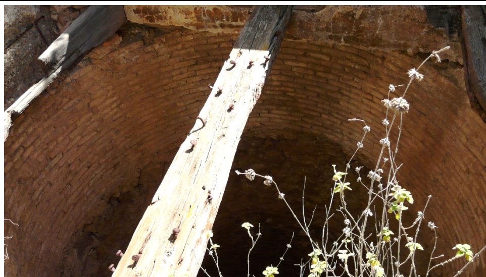
10. Pozo maestro de la mina Teresita.
