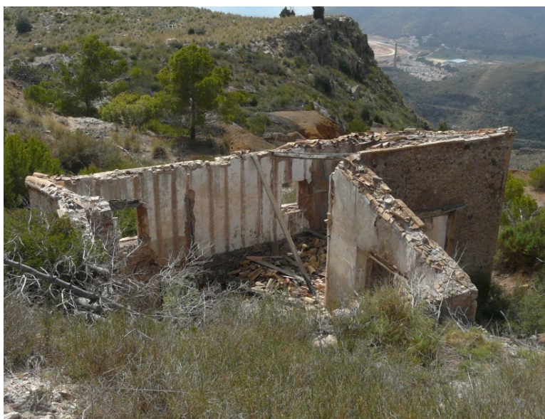
19, 20 y 21. Estado actual del exterior del edificio de dos plantas de la mina Más Alerta.
