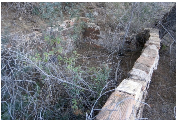
32 y 33. Balsas y canalizaciones de distribución del agua a las distintas zonas del lavadero.
