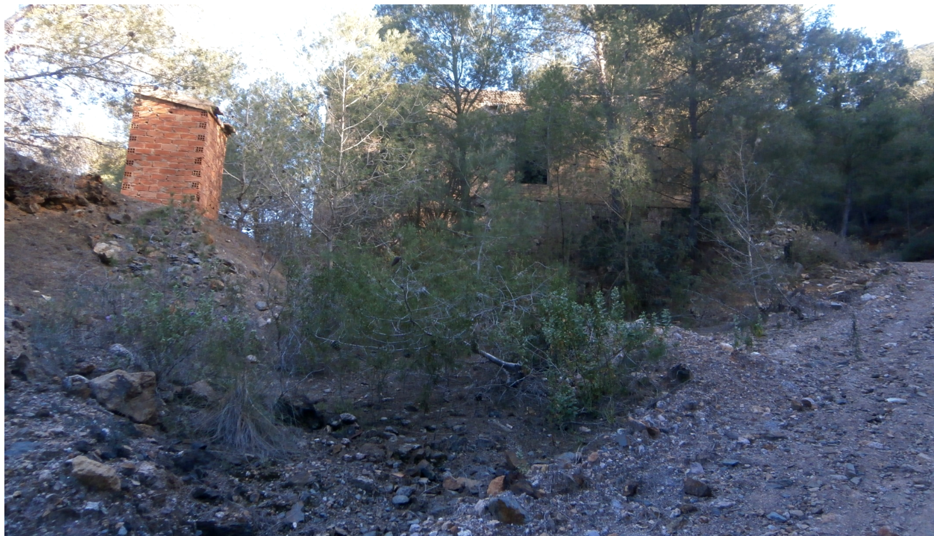
1. Estado actual de las instalaciones minero metalúrgicas y lavadero de la mina Consuelo II-Loba entre la densa vegetación de la Peña del Águila.
