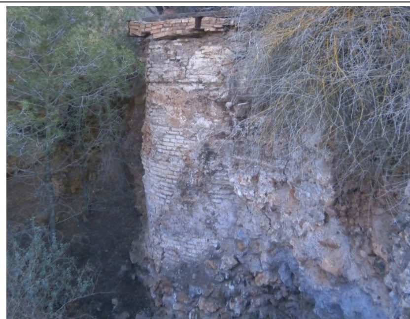
3. Forro realizado en ladrillo macizo del pozo maestro expuesto al exterior.
