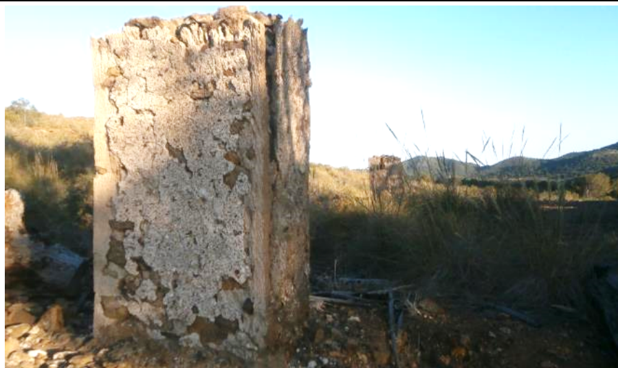
2 y 3. Estado actual de los pivotes de sustentación de un antiguo malacate existentes en las instalaciones minero-metalúrgicas de la mina Teresita.
