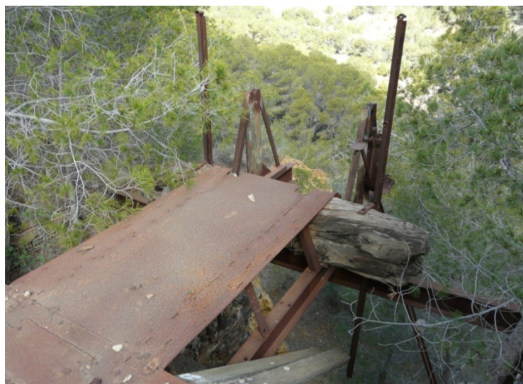
12. Muelle de amaine del mineral con resbaladero sobre la ladera de la montaña.
