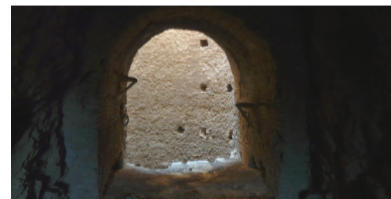
7 y 8. Estado actual del pozo maestro completamente forrado de ladrillo macizo de la mina Genara.
