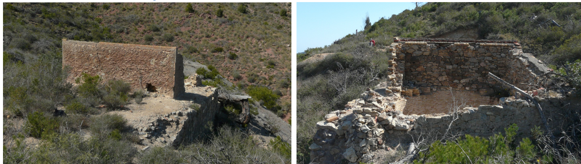
3, 4, 5 y 6. Estado actual de la edificación en cuyo interior se encuentra el pozo maestro de la mina Genara.
