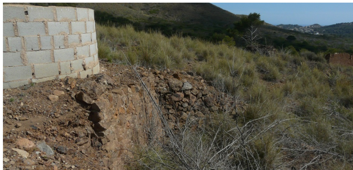
16. Plataforma de nivelación artificial con muros de mampostería en la que se ubica el pozo C-1394 en las instalaciones minero-metalúrgicas de la mina Siete Dolores I.
