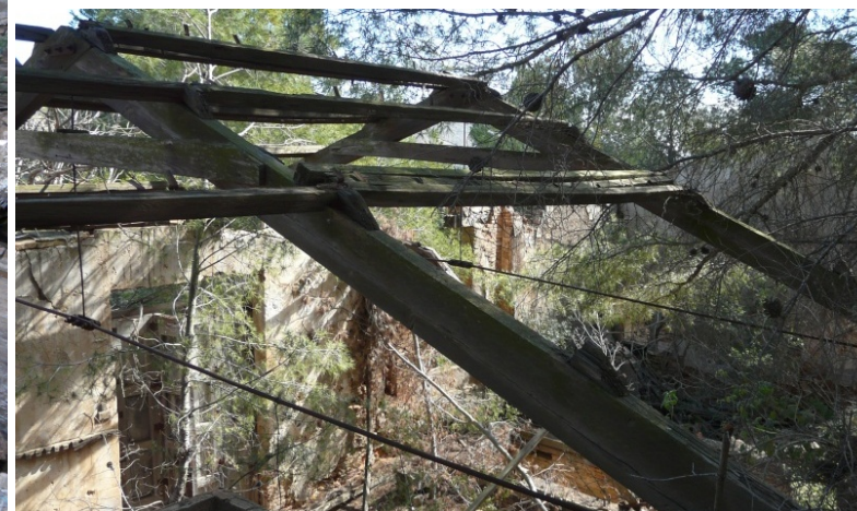
10. Detalle de las cerchas de madera de la techumbre de la casa de máquinas de la mina Consuelo II.
