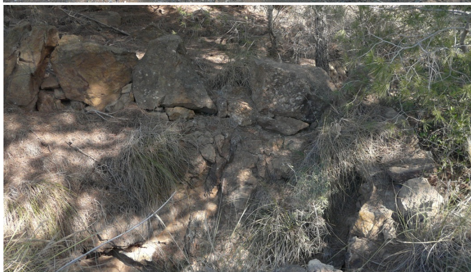
5. Estado actual del murete construido a piedra seca para proteger la boca de la galería en rampa de acceso a las labores subterráneas de la mina Teresita.
