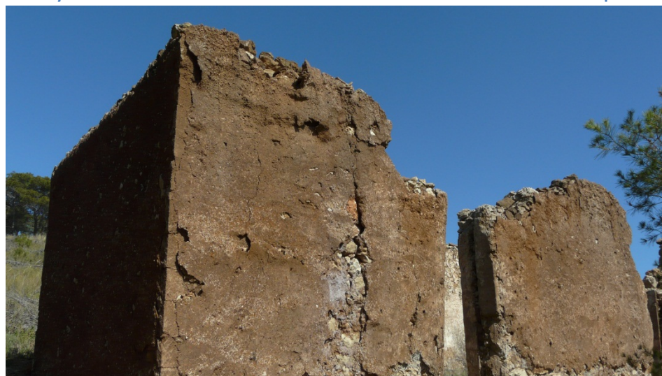
24. Detalle de uno de los muros de la posible vivienda con el dintel del vano expoliado.
