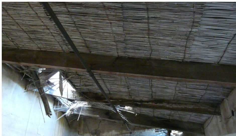
8. Detalle de la techumbre del vestuario y sala de duchas de la mina Secretaria.
