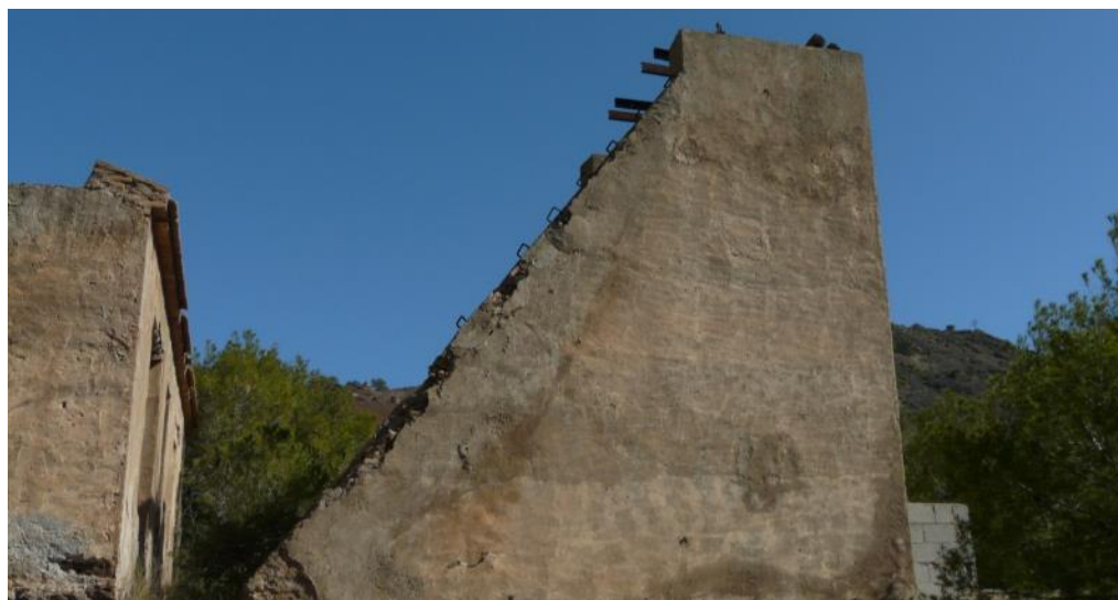
7. Muro sur del castillete con restos de escala metálica.
