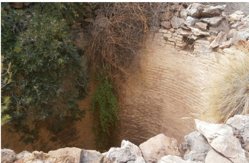
10. Pozo de planta ovalada, con el brocal dañado y grave peligro de caída, localizado al oeste de las instalaciones minero-metalúrgicas de la mina La Montaña.
