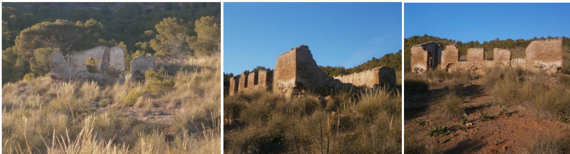
6, 7 y 8. Vista general del estado actual del edificio en ruinas que pudo haber sido una vivienda o almacén, en las instalaciones minero-metalúrgicas de la mina Teresita.
