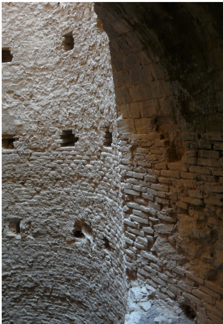
13 y 14. Zona de emboque de la galería con el pozo maestro en las instalaciones minero-metalúrgicas de la mina Genara.
