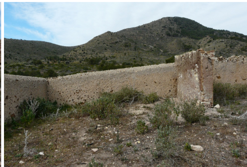
7. Detalle de muro de cerramiento del cercado del establo.
