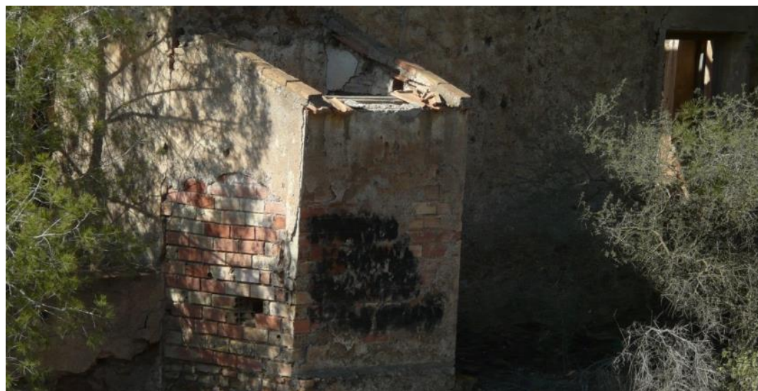
25. Retrete adosado a la fachada norte de la vivienda de la mina Teresita.
