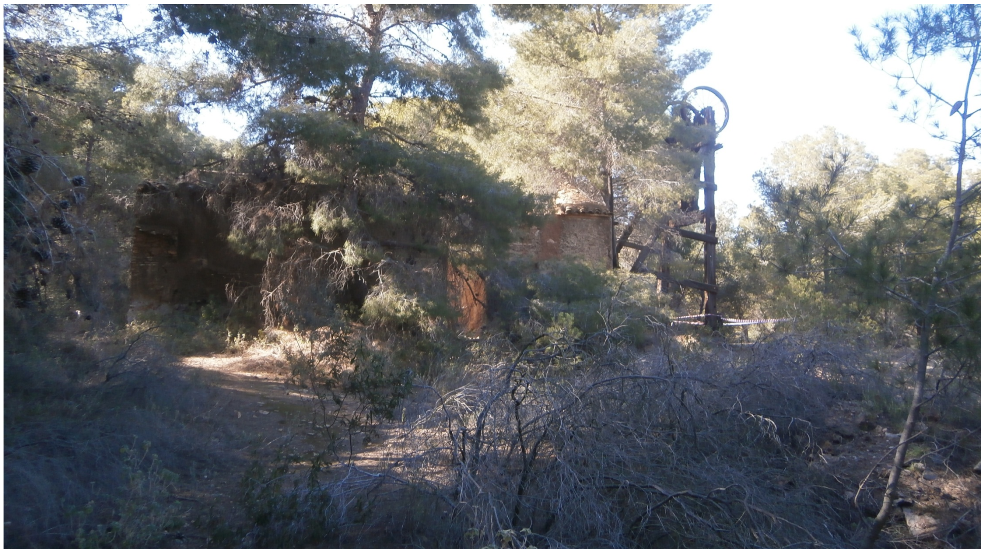
1. Vista general del estado actual del castillete y casa de máquinas de la mina Santo Tomás.
