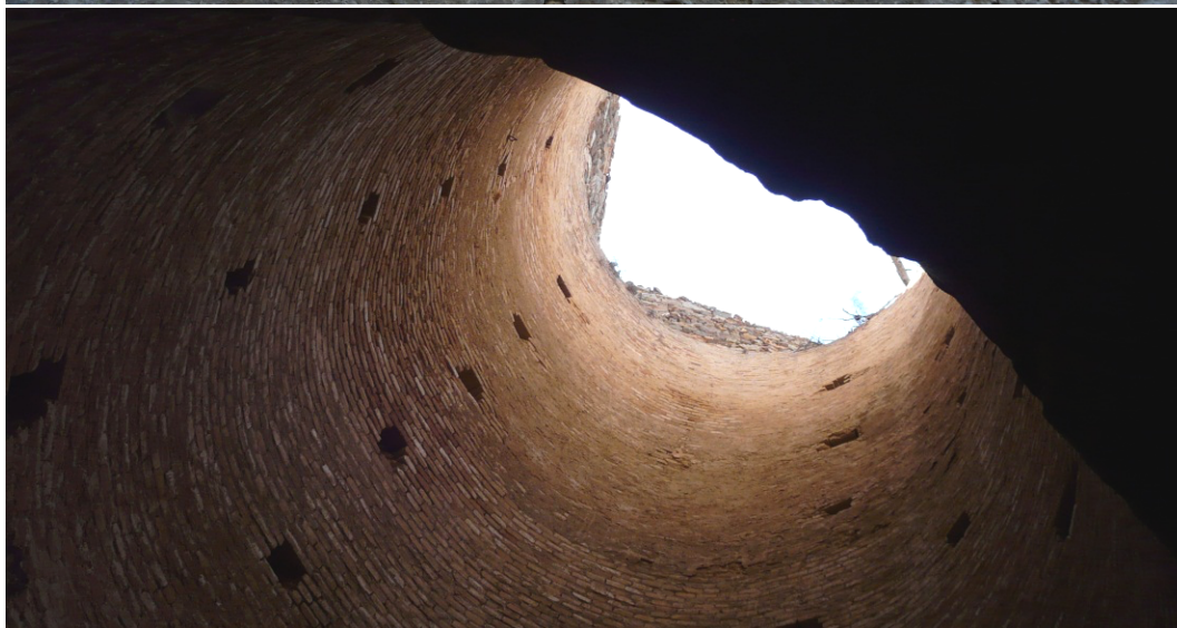
15. Pozo maestro de la mina Genara visto desde la galería horizontal de acceso.
