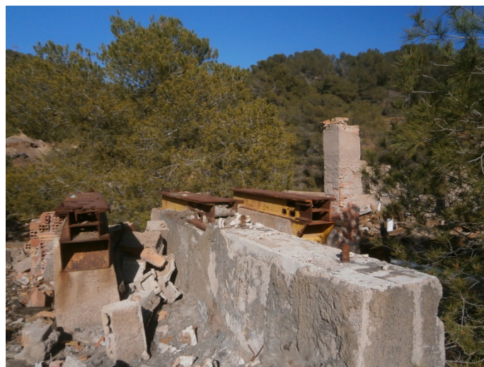
11, 12 y 13. Cimentaciones con elementos metálicos para el anclaje de maquinaria de machaque y molienda en el lavadero La Pinada.
