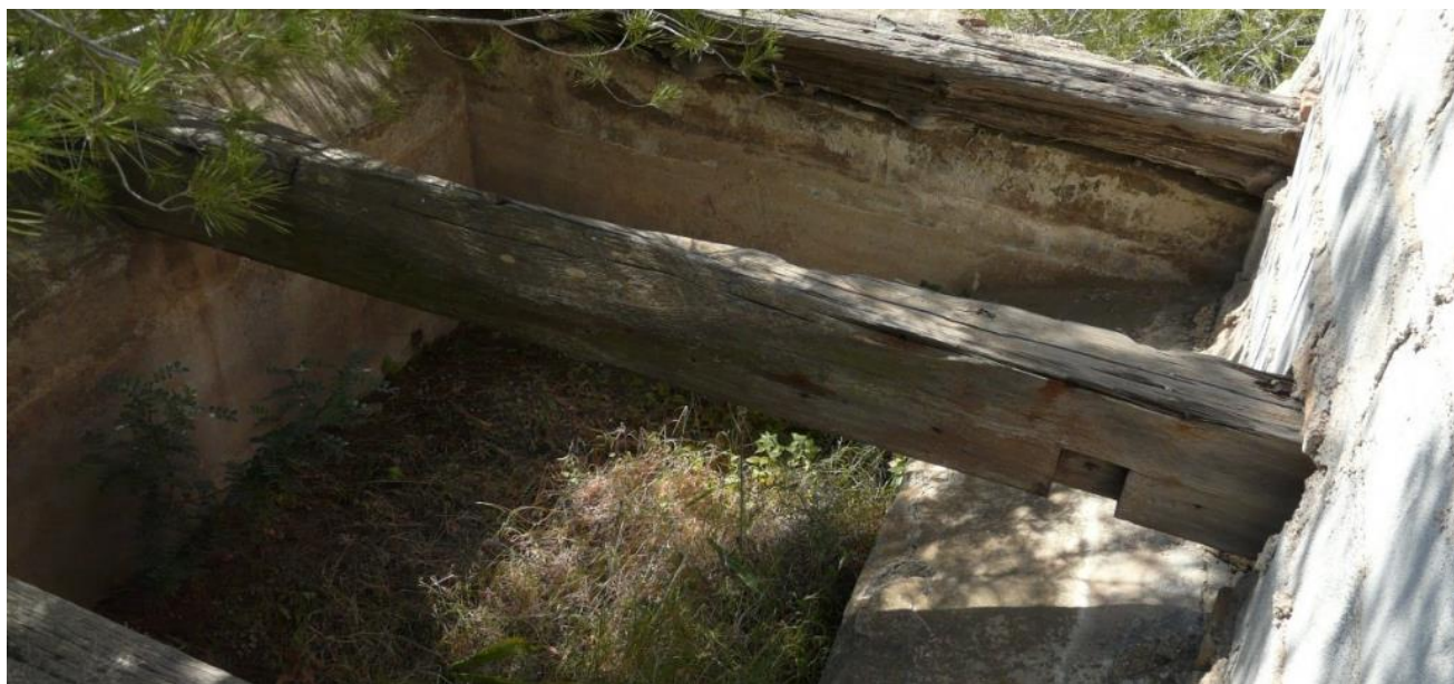
11 y 12. Plataforma artificial de nivelación sobre la que se ubica el castillete y pequeña balsa junto al pozo de la mina Teresita.
