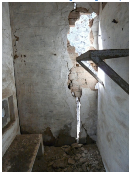
18. Detalle de uno de los muros del centro de transformación de electricidad con grandes grietas que ponen en peligro su estabilidad.
