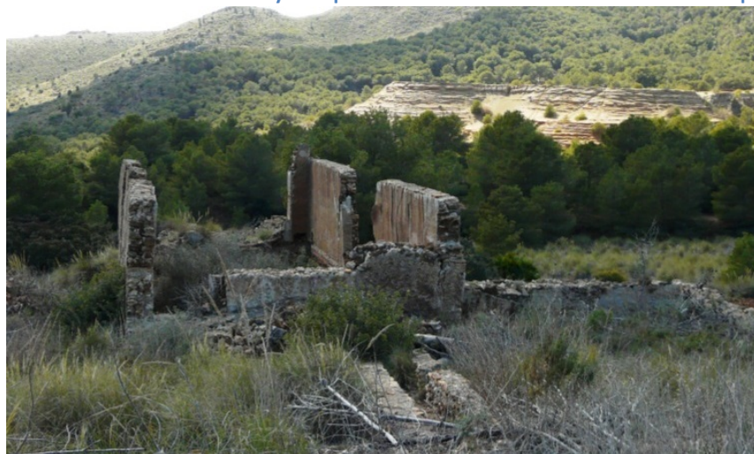
14. Vista general del estado actual de la casa de máquinas y la galería de humos de las instalaciones minero-metalúrgicas de la mina Siete Dolores II.
