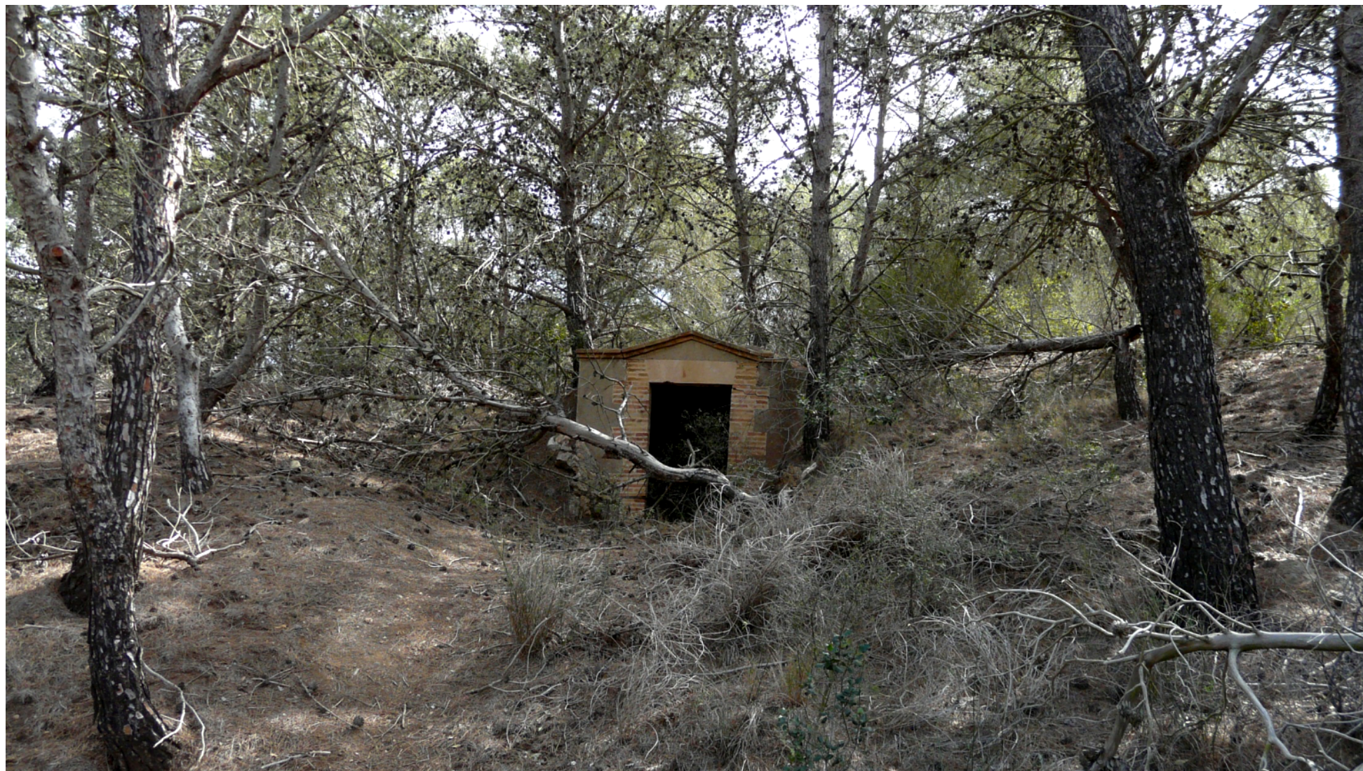
1. Vista general del estado actual del polvorín de la mina Consuelo II – mina Loba entre la densa vegetación de la Peña del Águila.
