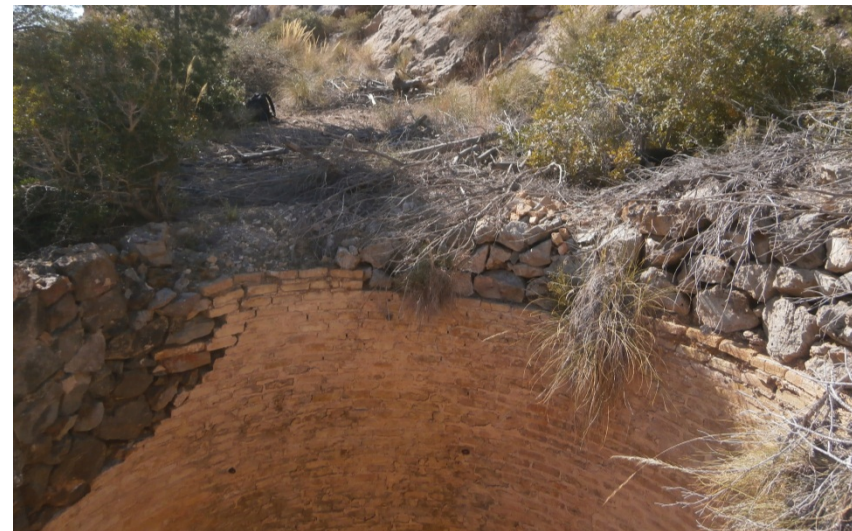
17 y 18. Estado actual del pozo sin brocal C-1400 localizado en la zona oriental de las instalaciones minero-metalúrgicas de la mina La Montaña.
