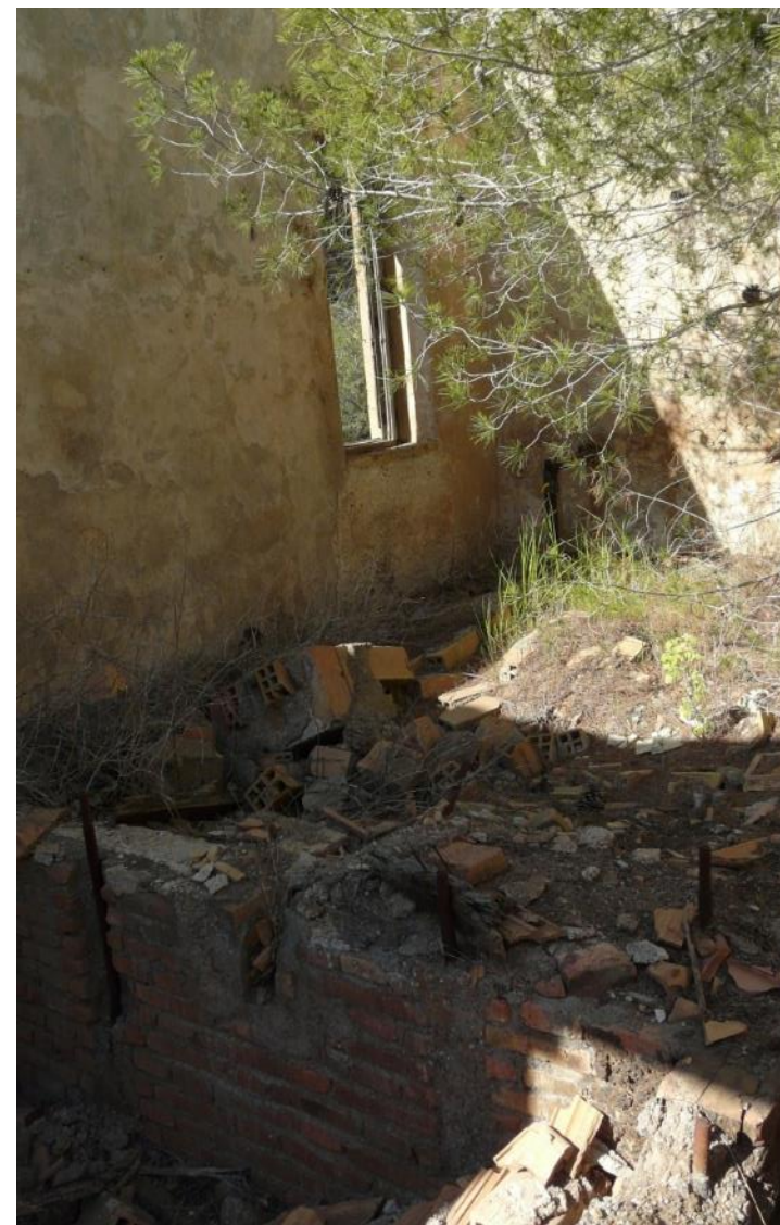
15. Estado actual del interior de la casa de máquinas de la mina Teresita.
