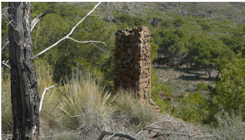
4. Detalle de pivote de las instalaciones minero-metalúrgicas de la mina Siete Dolores I.
