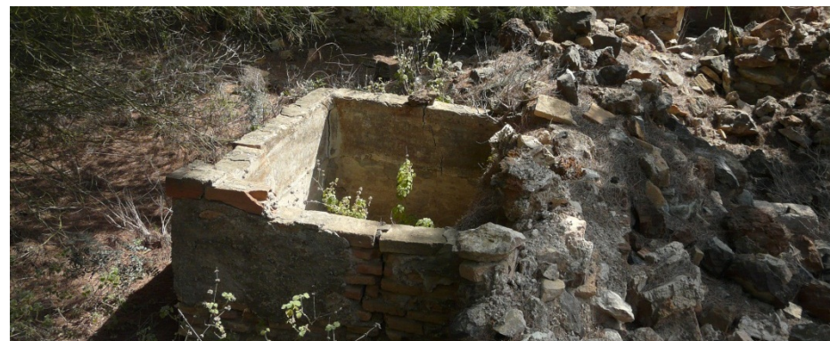
14. Cimentación con pernos de anclaje para la antigua maquinaria de la mina San Dionisio.
