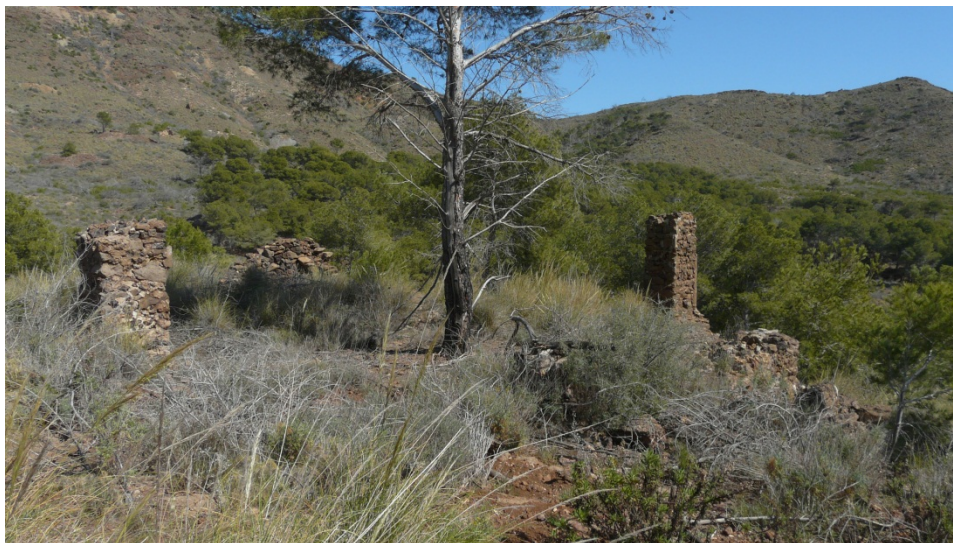
2. Estado actual de las instalaciones minero-metalúrgicas de la mina Siete Dolores I.
