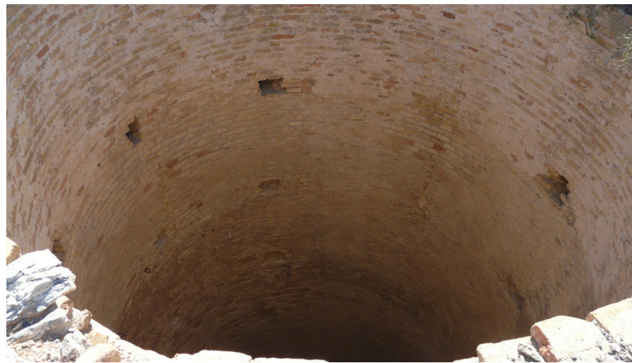
7 y 8. Estado actual del pozo maestro completamente forrado de ladrillo macizo de la mina Genara.
