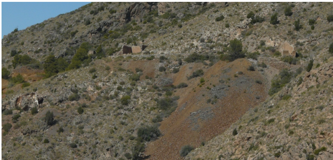
1 y 2. Vistas generales del estado actual de las instalaciones minero-metalúrgicas de la mina La Montaña que se distribuyen por la parte alta de la ladera sur de la Peña del Águila
