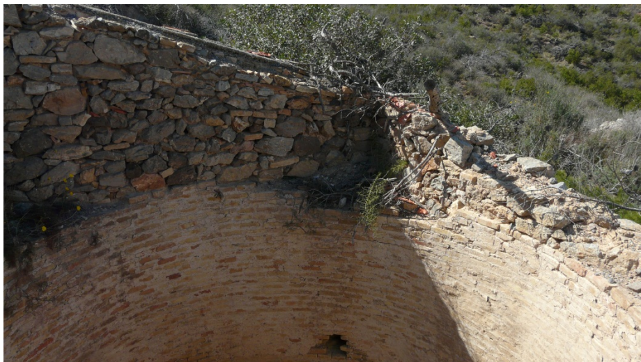
7 y 8. Estado actual del pozo maestro completamente forrado de ladrillo macizo de la mina Genara.
