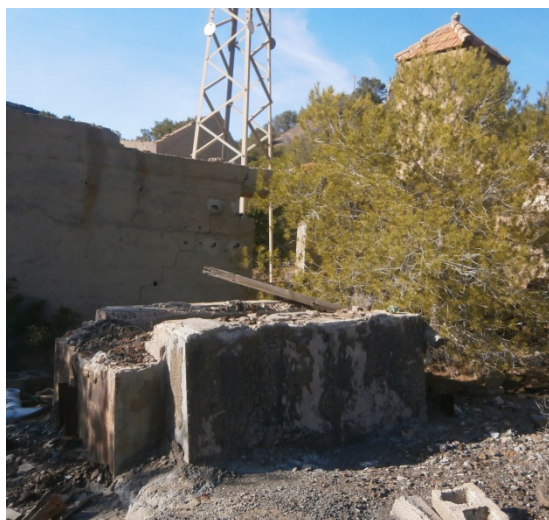
11, 12 y 13. Cimentaciones con elementos metálicos para el anclaje de maquinaria de machaque y molienda en el lavadero La Pinada.
