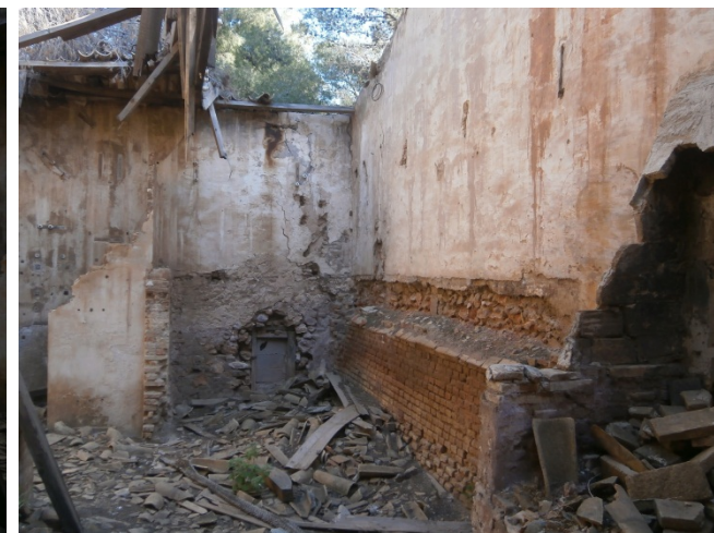
20 y 21. Estado actual del interior de la casa de máquinas de la mina Santo Tomás.
