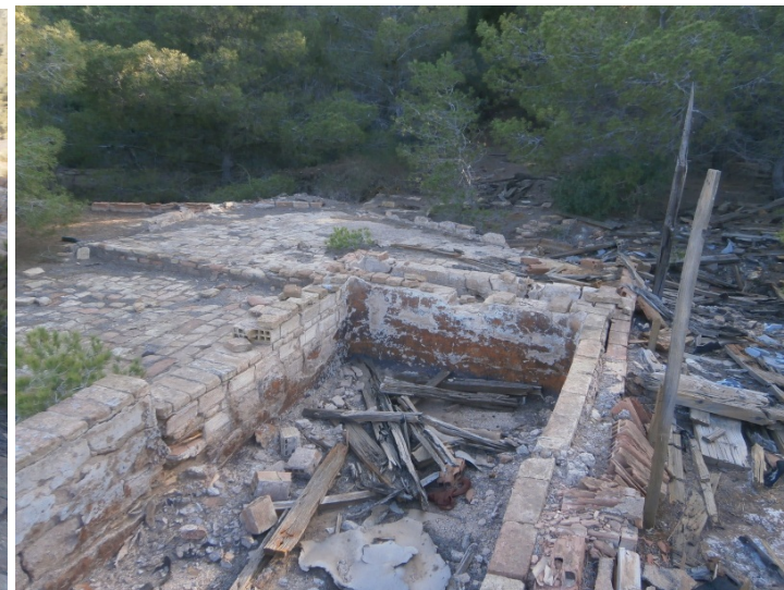
28, 29 y 30. Balsas de secado del mineral concentrado en el lavadero de la mina Consuelo II.
