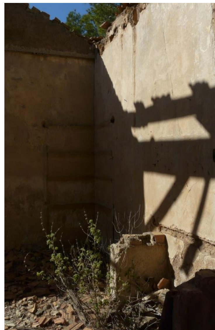
22. Estado actual del interior de la vivienda de la mina Teresita.
