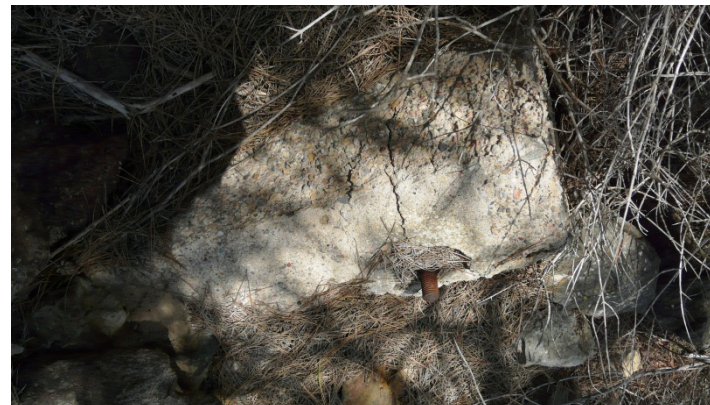
14. Cimentación con pernos de anclaje para la antigua maquinaria de la mina San Dionisio.
