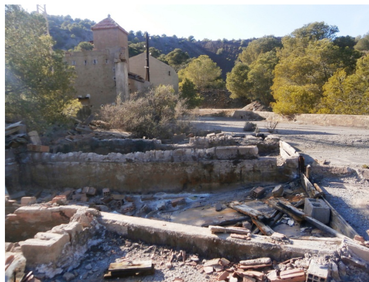
17 y 18. Área de secado del mineral concentrado con distintas balsas y una gran explanada en la parte norte del lavadero La Pinada.
