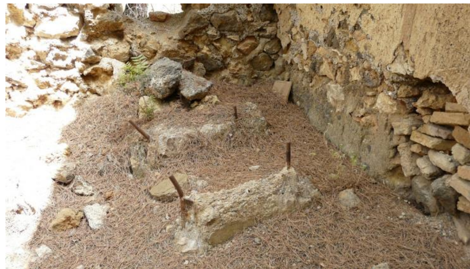
20. Basamento con pernos metálicos para maquinaria en el interior de la casa de máquinas de la mina Candelaria.
