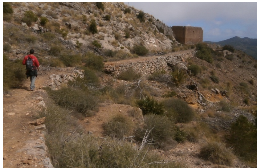
11. Vista general de la instalación existente en la zona intermedia del camino minero y que consta de un edificio de altos muros y una balsa asociada.
