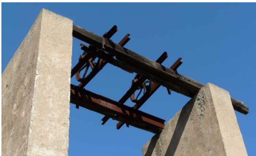
6. Detalle de las poleas del castillete.
