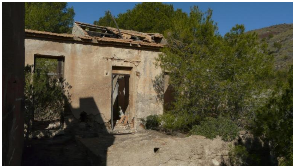
20 y 21. Estado actual del exterior de la vivienda de la mina Teresita.
