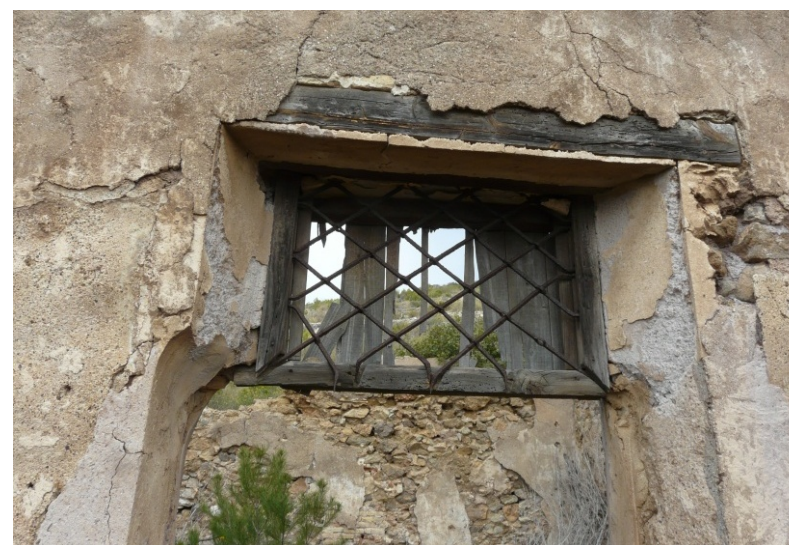
14. Detalle de rejería y marquetería de un vano de la casa de máquinas.
