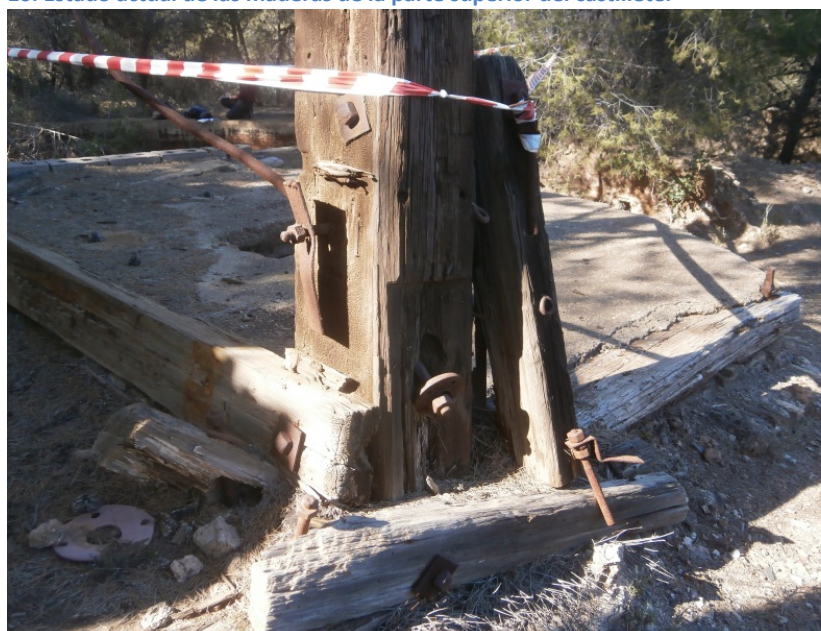
11, 12 y 13. Situación actual del estado de conservación de los pies del castillete con el deterioro de la madera que precisa una urgente restauración.
