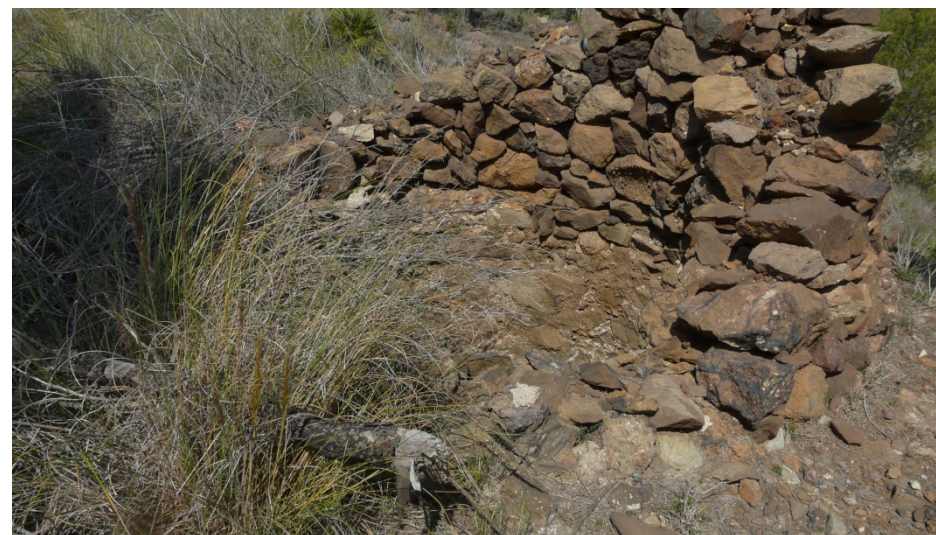
3. Estado actual del exterior del pozo maestro y los pivotes de un antiguo malacate de las instalaciones minero-metalúrgicas de la mina Siete Dolores I.
