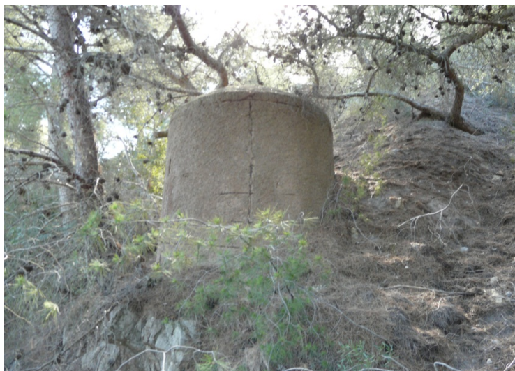
12 y 13. Depósito de agua construido en hormigón con refuerzos metálicos de la mina Secretaria.
