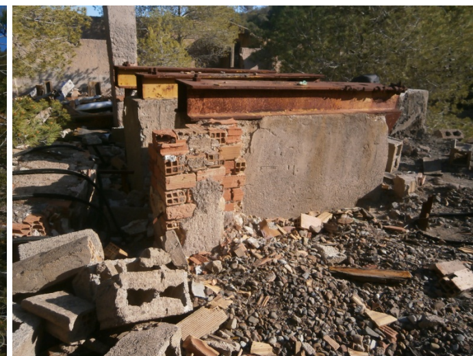
11, 12 y 13. Cimentaciones con elementos metálicos para el anclaje de maquinaria de machaque y molienda en el lavadero La Pinada.
