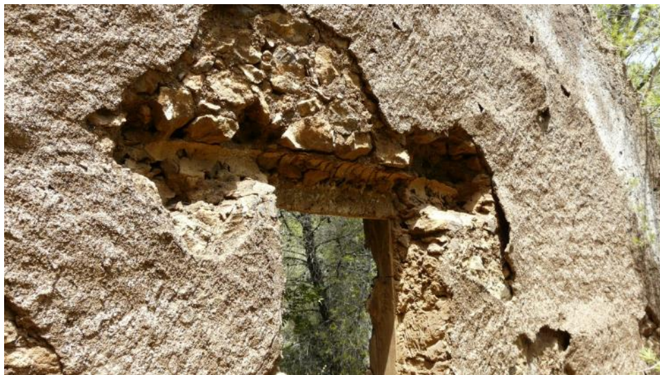
19. Detalle de vano de una de las paredes de la casa de máquinas con el dintel de madera expoliado.
