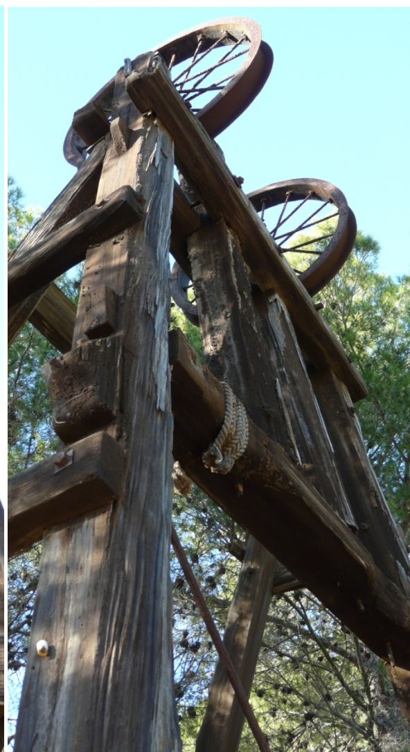
7 y 8. Detalles del estado actual del castillete de madera de la mina Santo Tomás.
