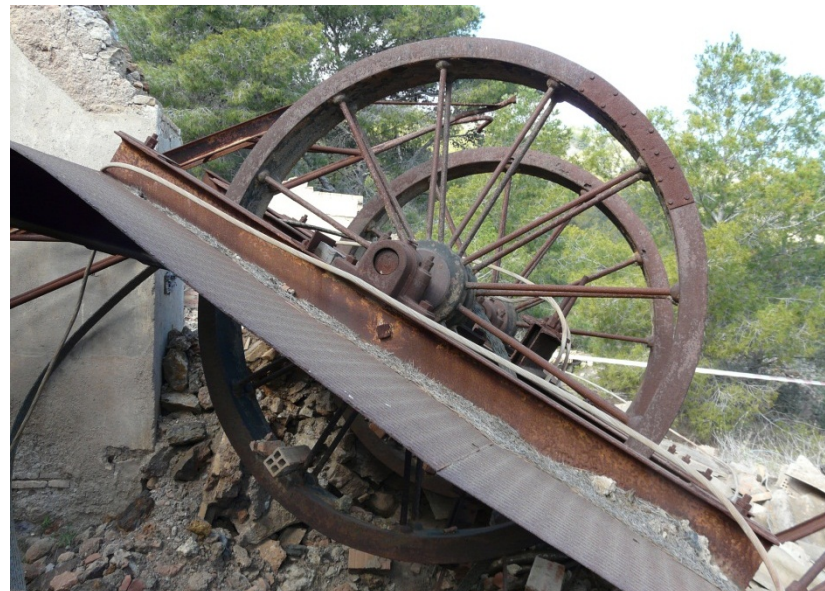
8, 9, 10 y 11. Detalle del estado actual de las poleas y elementos metálicos del castillete de la mina Secretaria.
