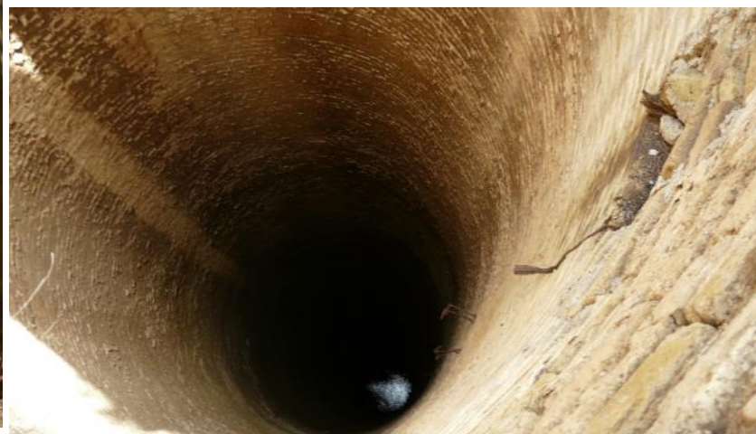
13 y 14. Exterior e interior del pozo maestro de la mina Candelaria.
