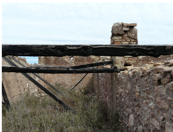
8, 9 y 10. Estado actual de las dependencias localizadas en el interior de los patios del establo. Se aprecian algunas vigas de madera calcinadas por el gran incendio que afectó a la zona el año 2011.
