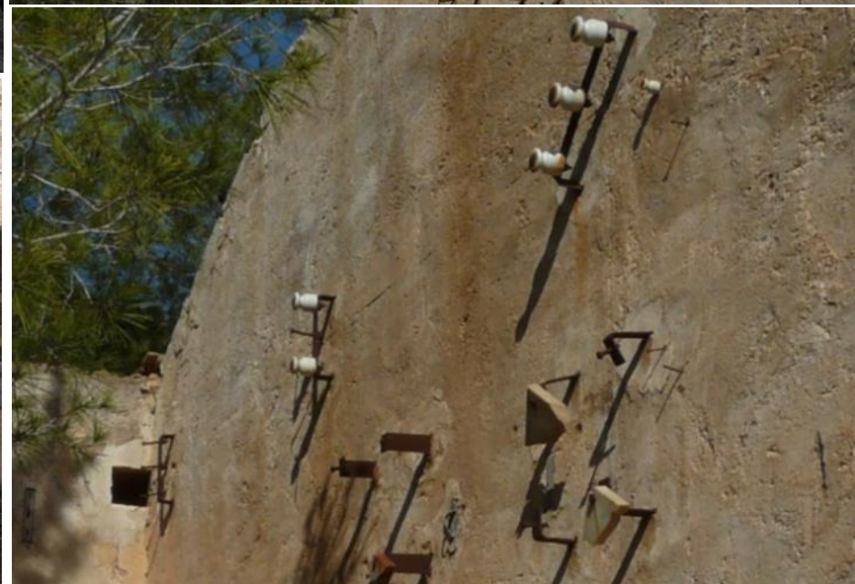
18y 19. Restos de cuadros eléctricos de la casa de máquinas de la mina Teresita.
