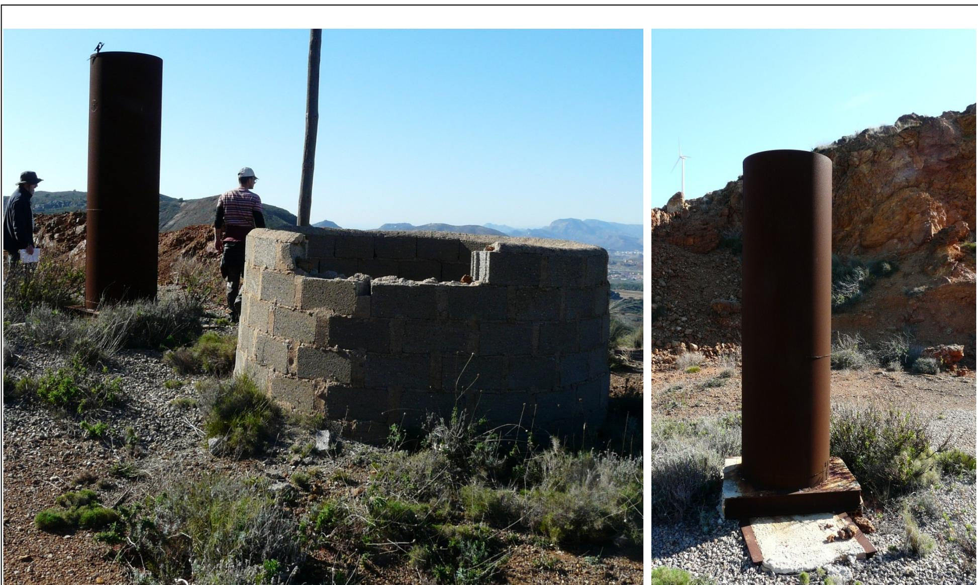
20 y 21. Vista de uno de los pozos de la concesión Agrupa Vicenta y de la protección metálica del sondeo de aireación de las galerías subterráneas de la mina.
