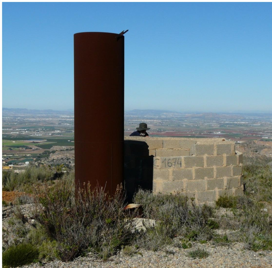
22. Estructura metálica de protección del sondeo de aireación de la mina Agrupa Vicenta.
