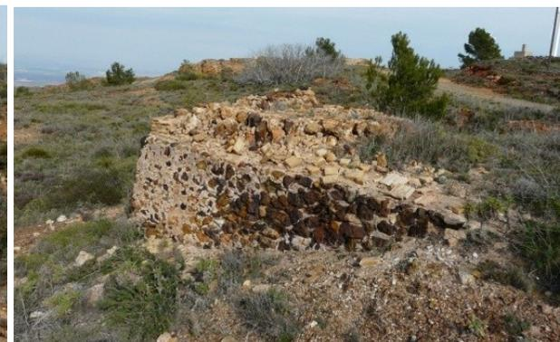
17, 18 y 19. Cimentaciones de posible transporte de mineral por cable o basamentos de anclajes de maquinaria.
