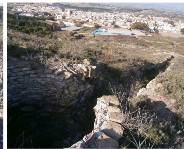
9, 10 y 11. Base de la antigua chimenea de evacuación de humos y conexión de ésta con la galería-serpentin.
