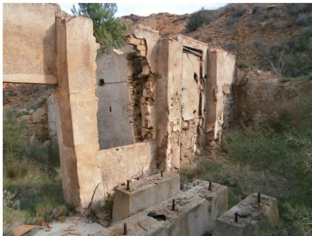
16. Interior de la casa de máquinas de la mina Pronta con restos de cimentaciones para la maquinaria de extracción.
