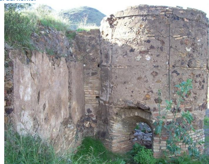
10. Fotografía retrospectiva del horno de calcinación de la mina Remunerada en 2007.
