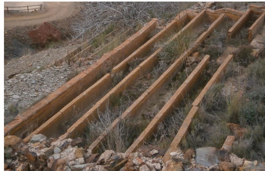
20 y 21. Estado actual de las baterías de balsas para la concentración de cobre localizadas en las inmediaciones del lavadero de la mina Remunerada.
