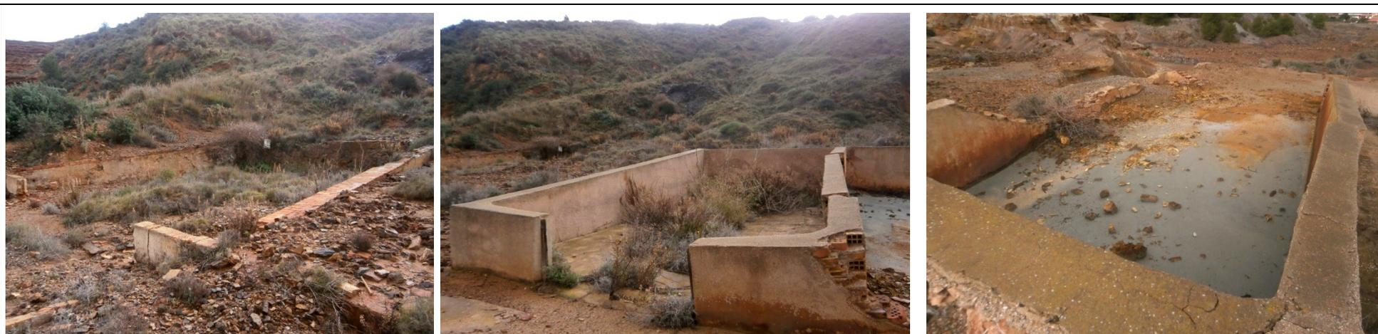
13,14 y 15. Restos de balsas de secado de mineral de un antiguo lavadero situado en la mina Agua Amarga.
