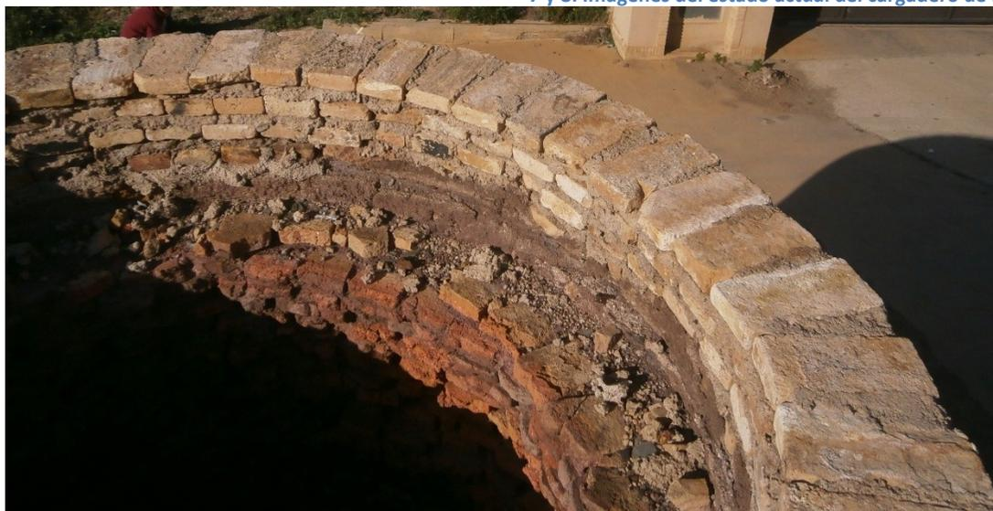
9. Detalle del cilindro interior de ladrillo macizo del horno de la mina Remunerada.
