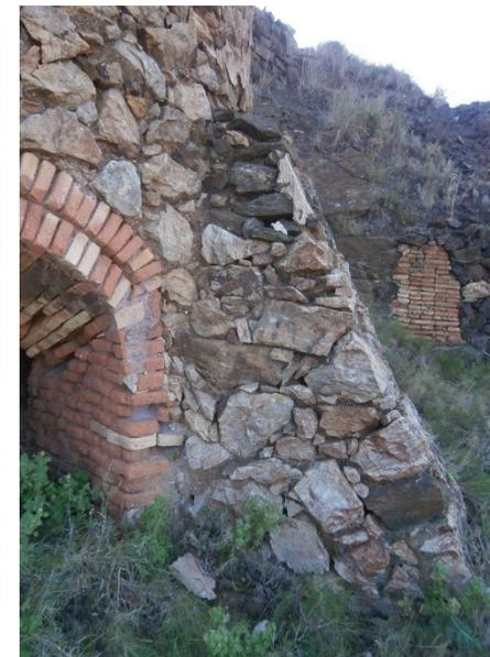
4 y 5. Contrafuertes de refuerzo de la estructura del horno.
