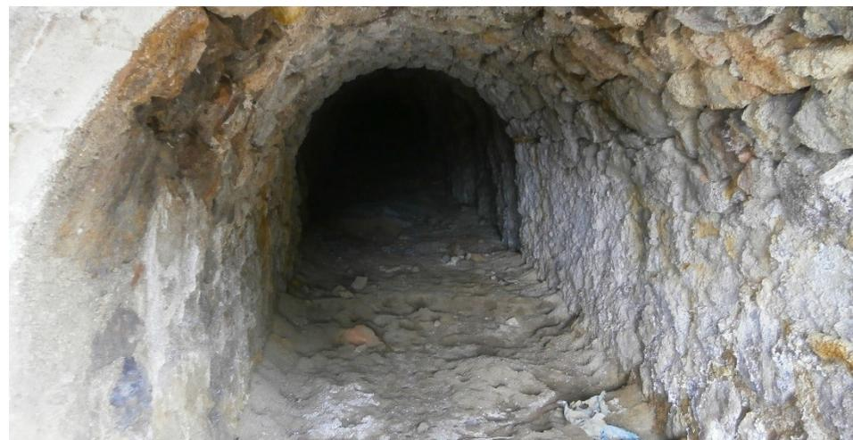
3 y 4. Galería de transporte a la que llegaba el mineral de estaño de la mina Remunerada mediante tolvas y resbaladeros.
