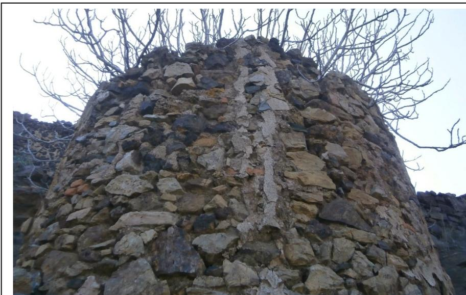
8. Imprinta de argamasa de estructura metálica de refuerzo expoliada.
