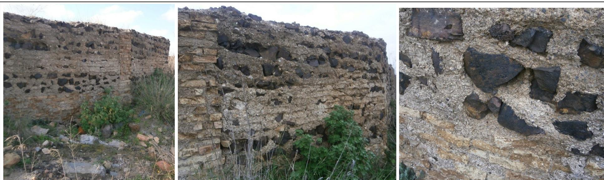
6, 7 y 8. Detalle de los muros con incrustaciones de escorias de la fundición Trinidad.
