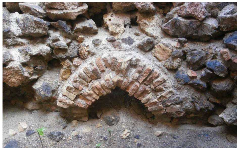
13 y 14. Detalle de las bocas de alimentación del horno occidental de la mina San Jorge.
