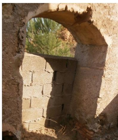
11 y 12. Apertura en forma de arco de medio punto rebajado parcialmente tapiada del lateral este del castillete.
