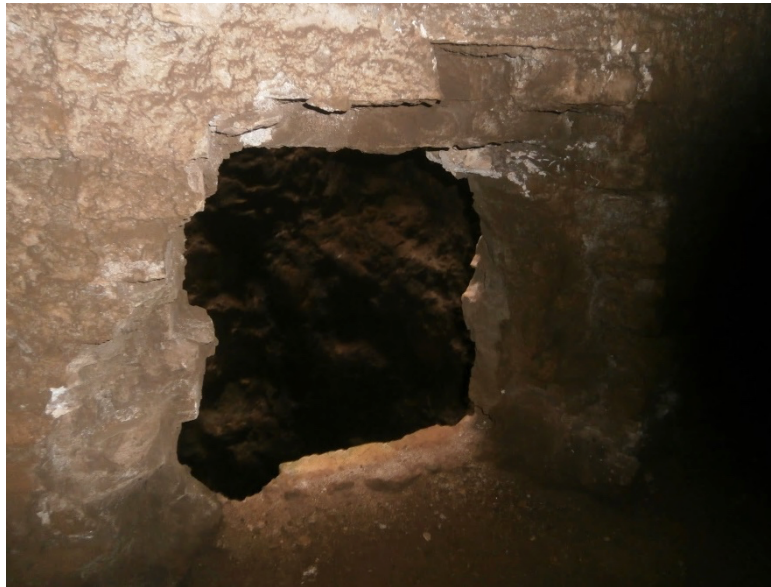
14 y 15. Orificio o ventana que conecta el túnel con el pozo maestro
