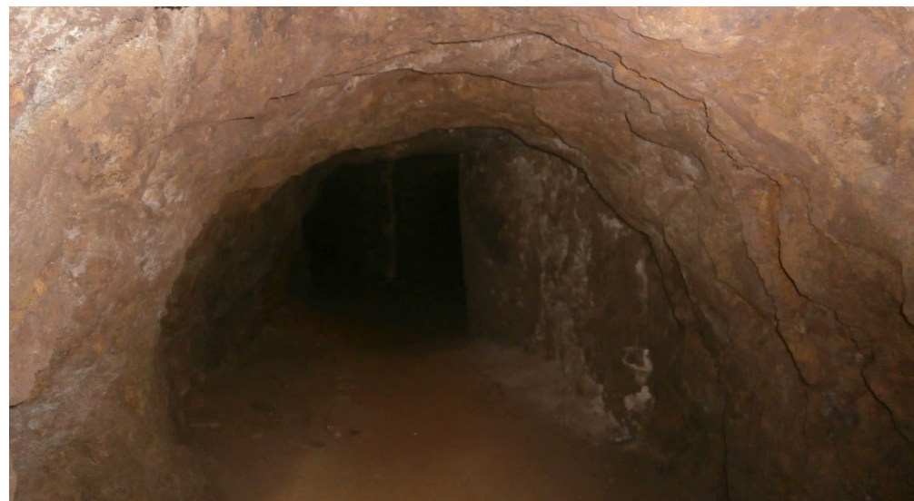
7, 8 y 9. Tramo del túnel de la mina María Dolores excavado en la roca natural.
