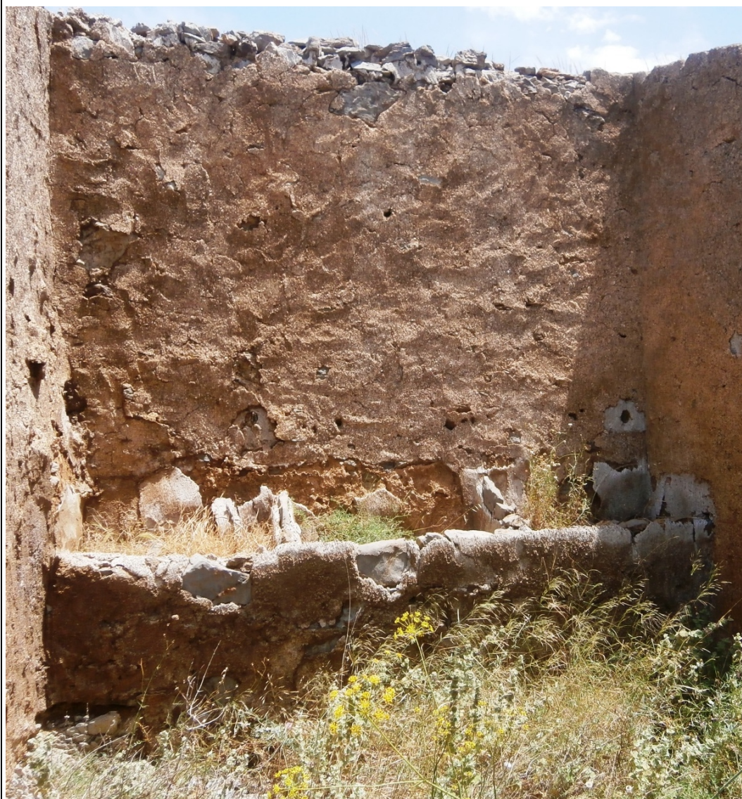
16. Estado actual del interior de la cuadra con el comedero para el ganado de la mina Santa Eduvigis.
