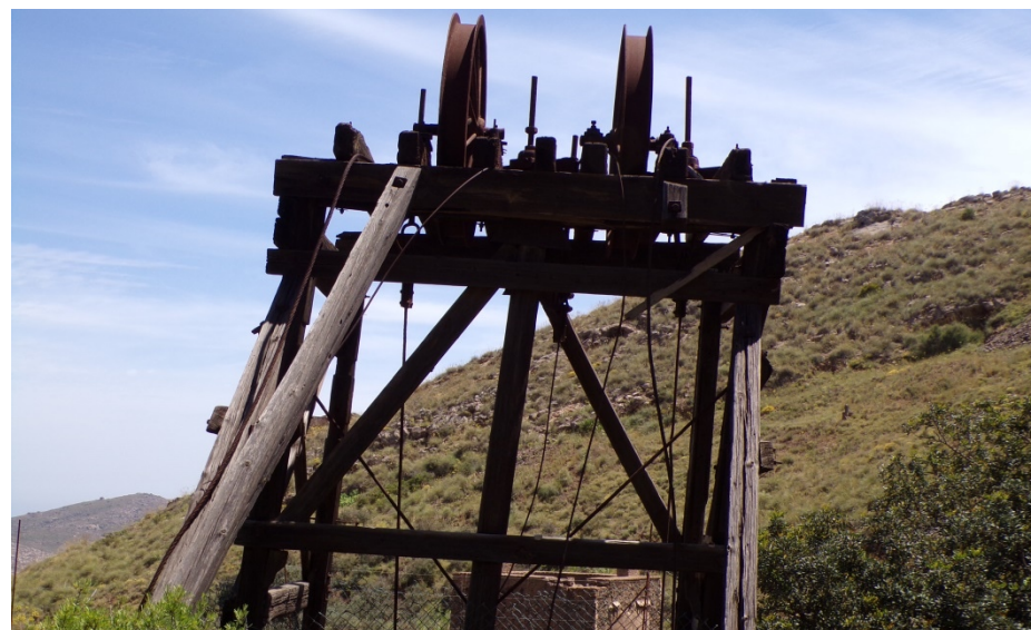
6, 7, 8 y 9. Estado actual del castillete de la mina Catón.
