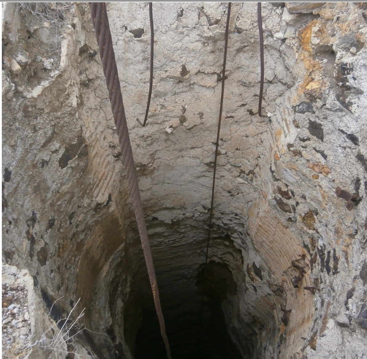
16. Pozo maestro de la mina Catón (2016).
