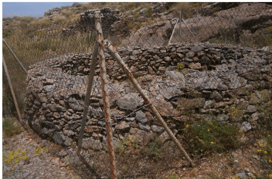
21. Pozo auxiliar protegido por vallado metálico de la mina Santa Eduvigis.
