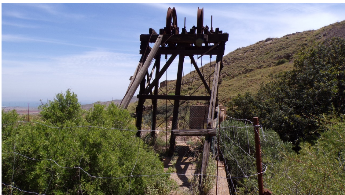
3, 4 y 5. Estado actual del castillete de la mina Catón.
