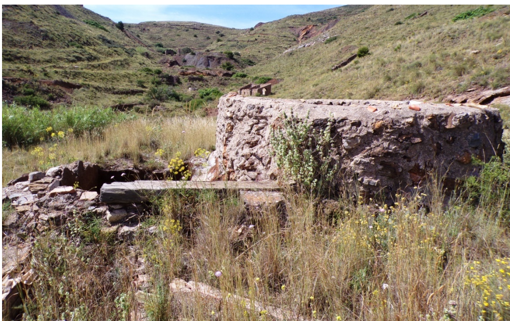
11 y 12. Estado actual del pozo maestro de la mina María Dolores que lleva anexo una pequeña balsa en su lado este.
