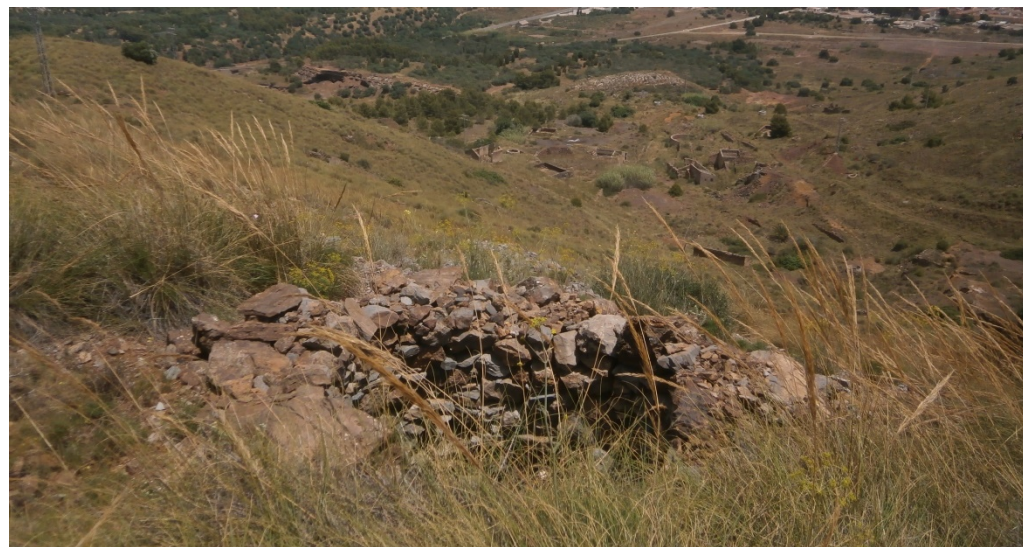
14, 15 y 16. Pozos con brocal deteriorado de la mina Crescencia Segunda.
