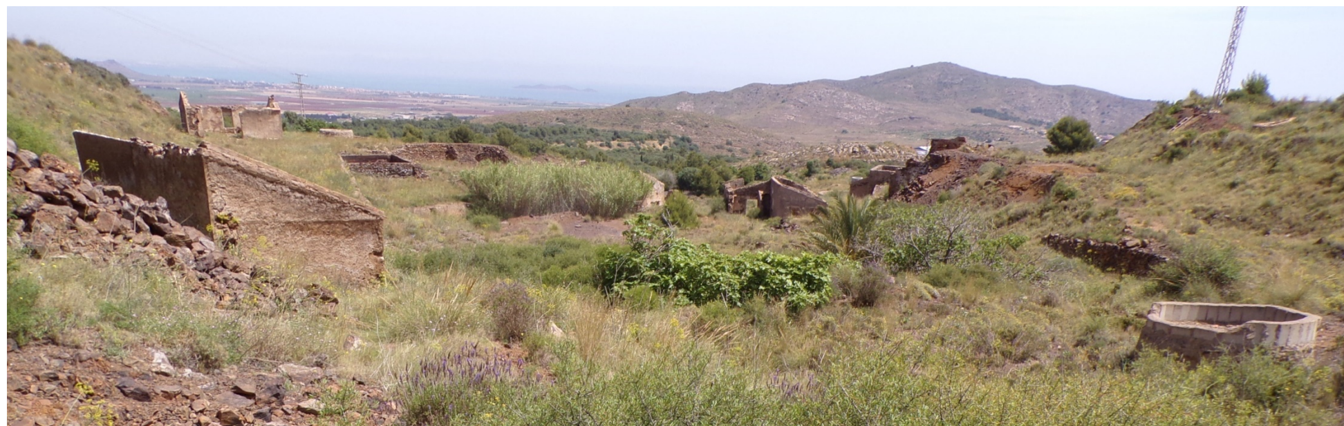
2 y 3. Vista general de las instalaciones minero-metalúrgicas de la mina María Dolores en el año 2019 (arriba) y en la actualidad (2022, abajo)
