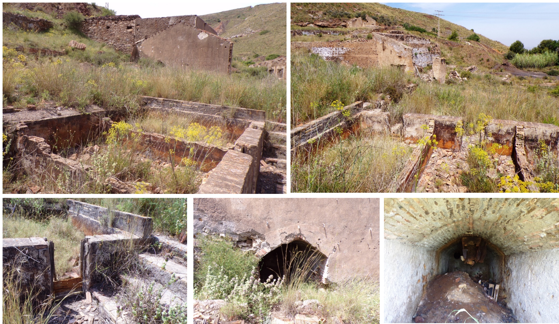
37, 38, 39, 40 y 41. Estado actual del lavadero de flotación noreste de la mina María Dolores.
