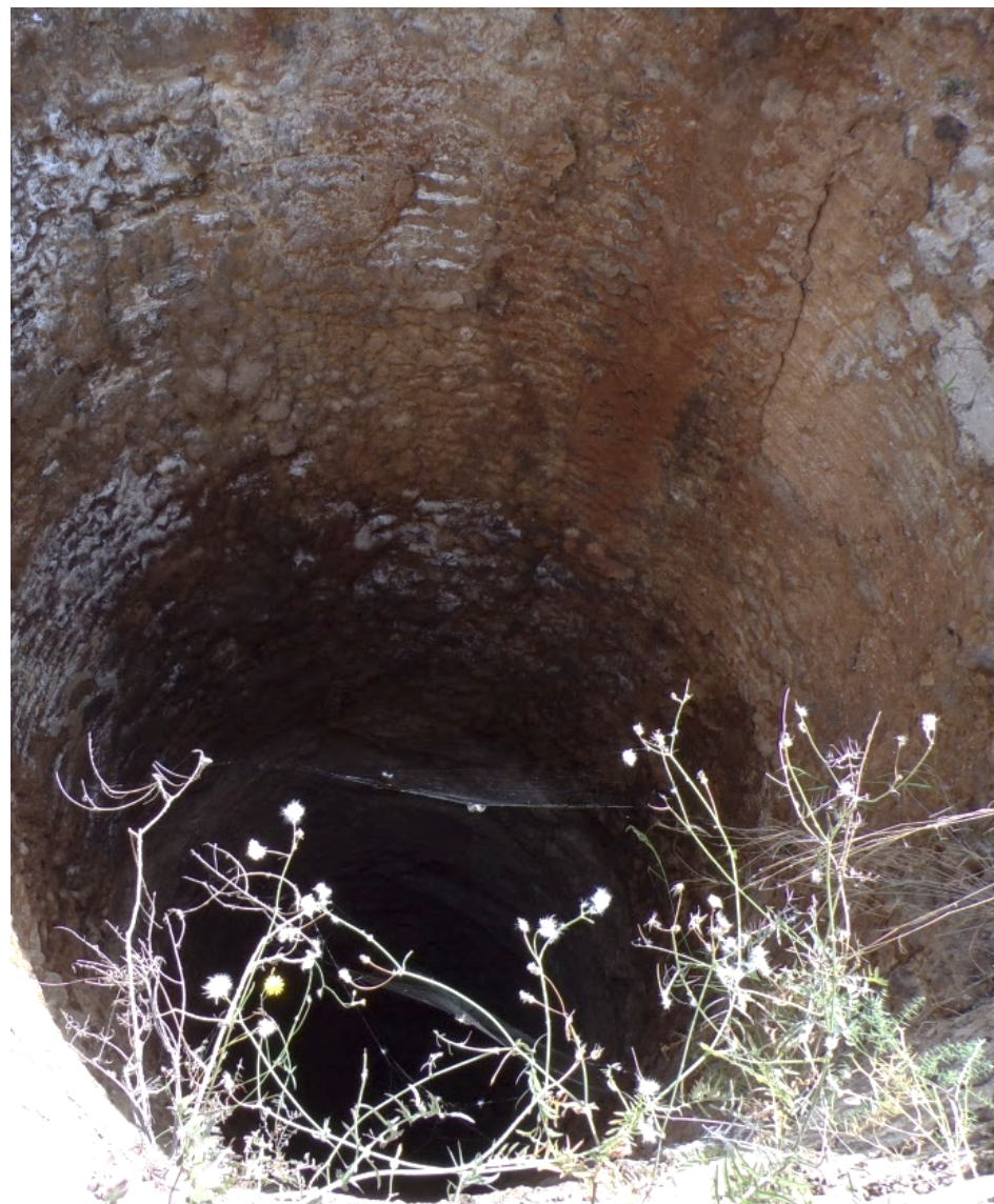
13. Interior del pozo maestro de la mina María Dolores.
