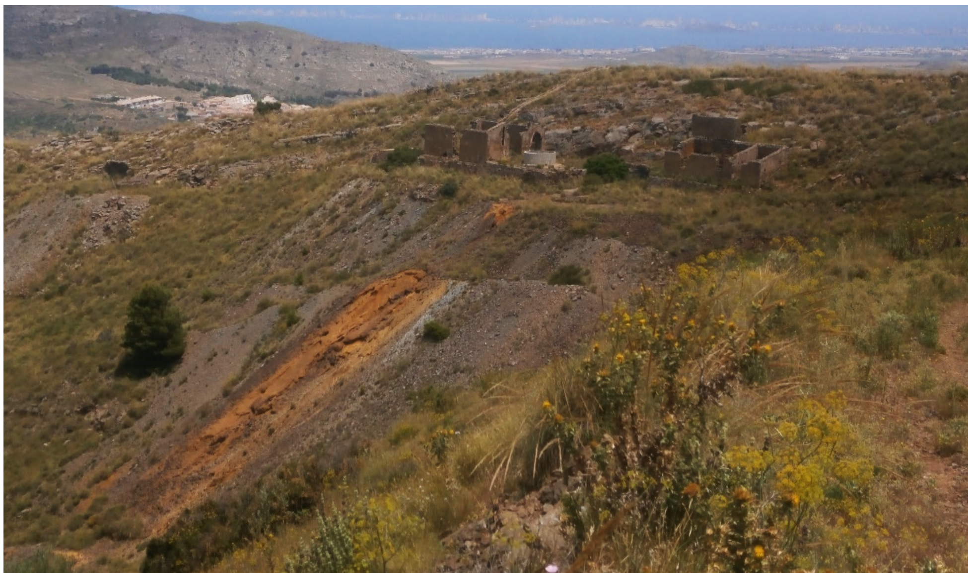
1 y 2. Vista general de las instalaciones de la mina Santa Eduvigis.
