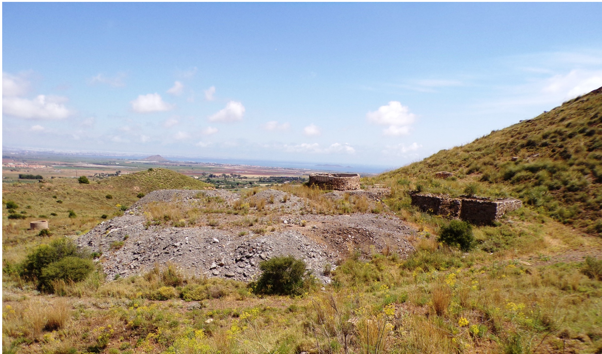
1. Vista general de las instalaciones minero-metalúrgicas de la mina Cuatro Santos
