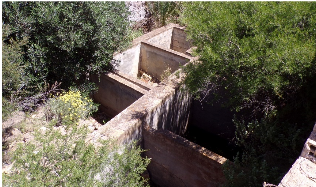
31. Piletas de la mina Catón, situadas entre el castillete y las oficinas.
