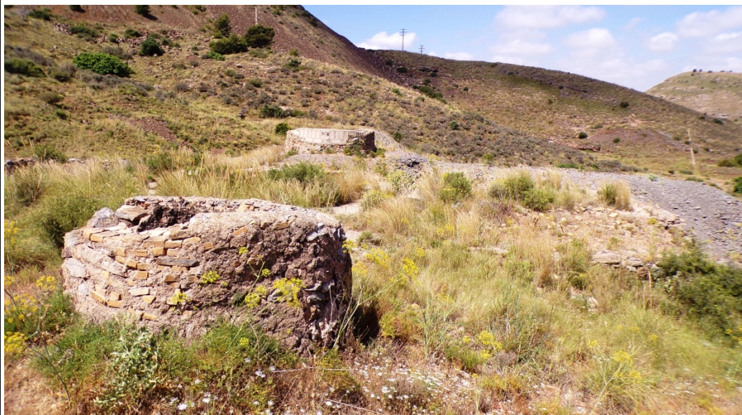
2 y 3. Vista general de los pozos maestro y auxiliar de la mina Cuatro Santos.
