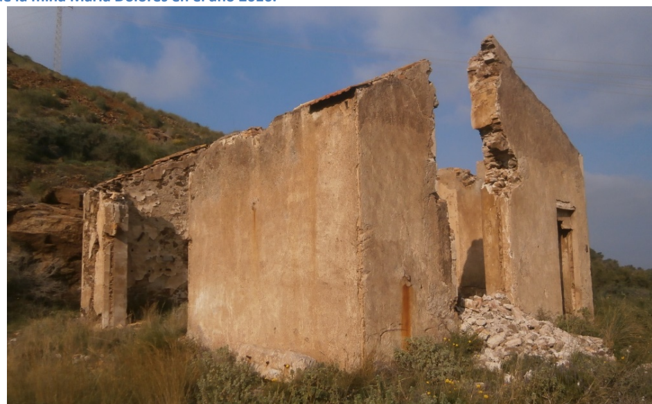
6 y 7. Estado actual del exterior la casa de máquinas con parte de la fachada principal derruida por el expolio del dintel del ventanal.
