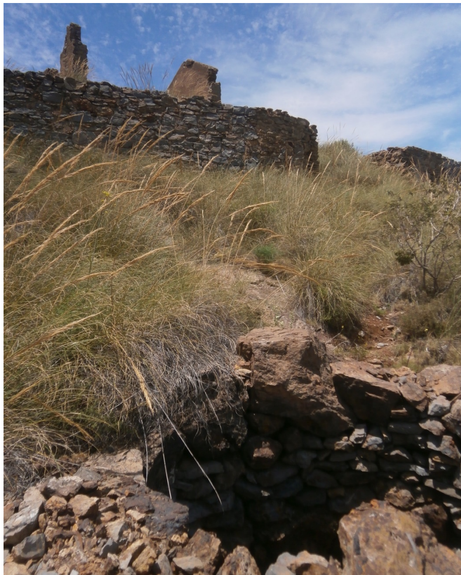
14, 15 y 16. Pozos con brocal deteriorado de la mina Crescencia Segunda.
