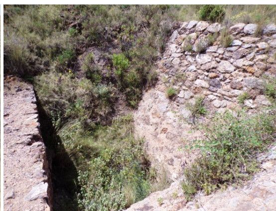
42, 43, 44, 45 y 46. Tolvas con rampas y restos de la estructura de transporte de mineral de la mina María Dolores.
