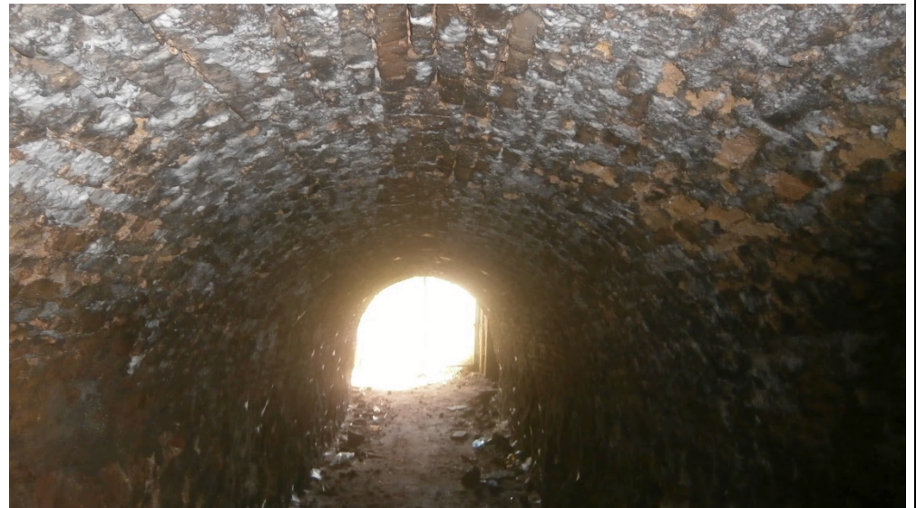
3, 4, 5 y 6. Tramo del túnel de la mina María Dolores fortificado con ladrillos macizos.
