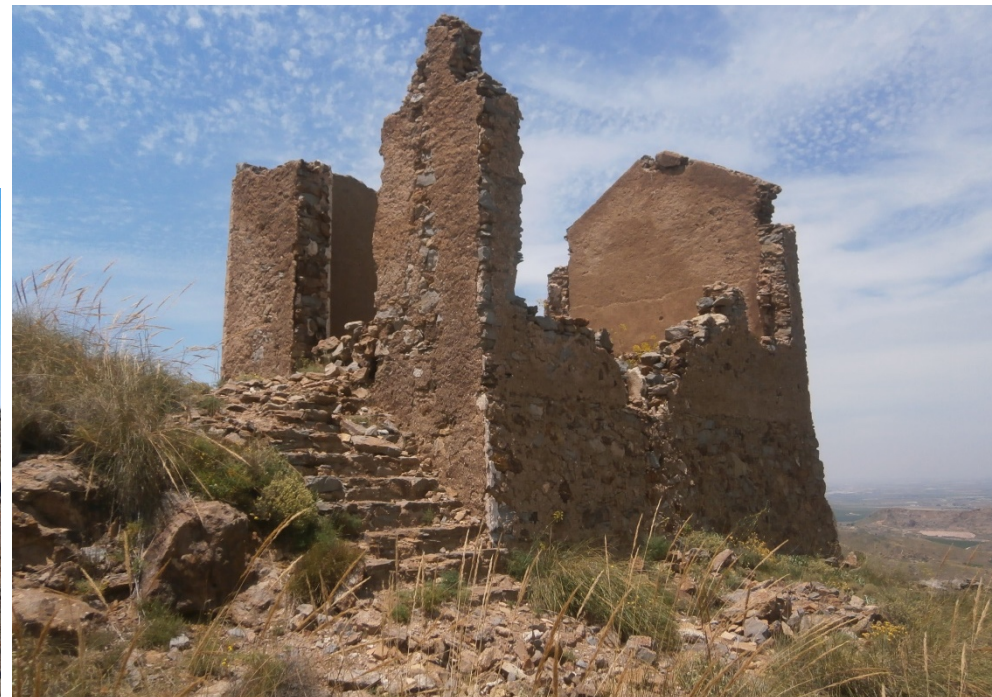
4 y 5. Estado actual de la caseta de maquinaria del plano inclinado de la mina Crescencia Segunda.
