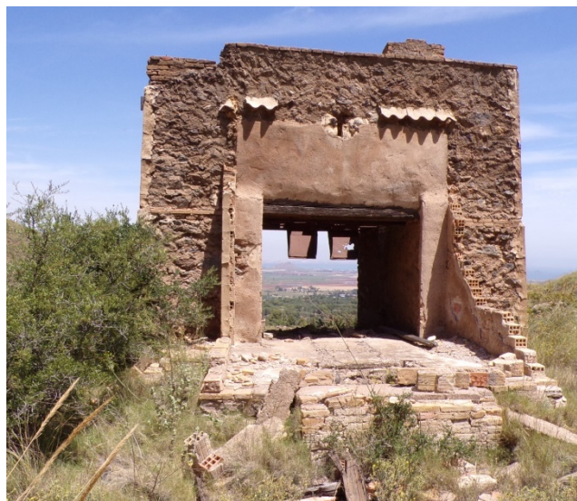
26, 27 y 28. Estado actual de la tolva y caseta de maquinaria del plano inclinado de la mina Catón.
