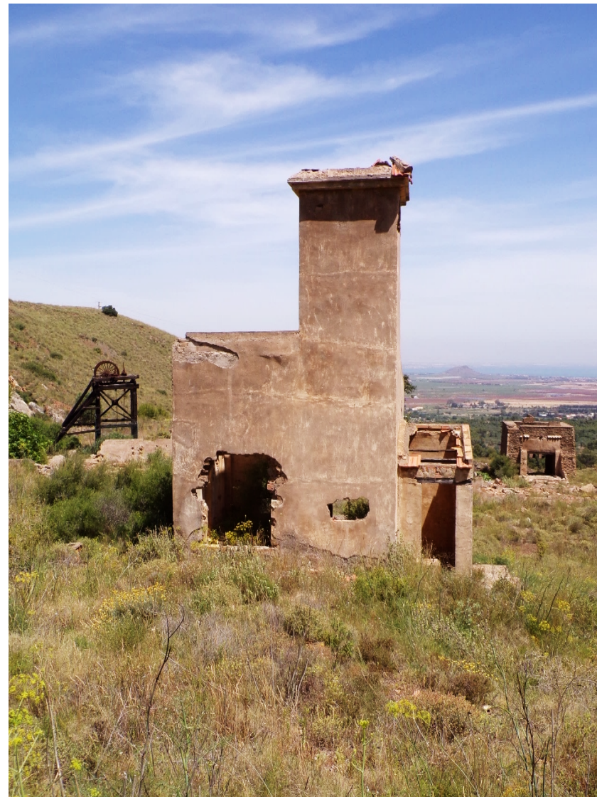
32, 33 y 34. Estado actual del transformador de electricidad de la mina Catón que lleva adosado en su lateral oriental dos retretes.
