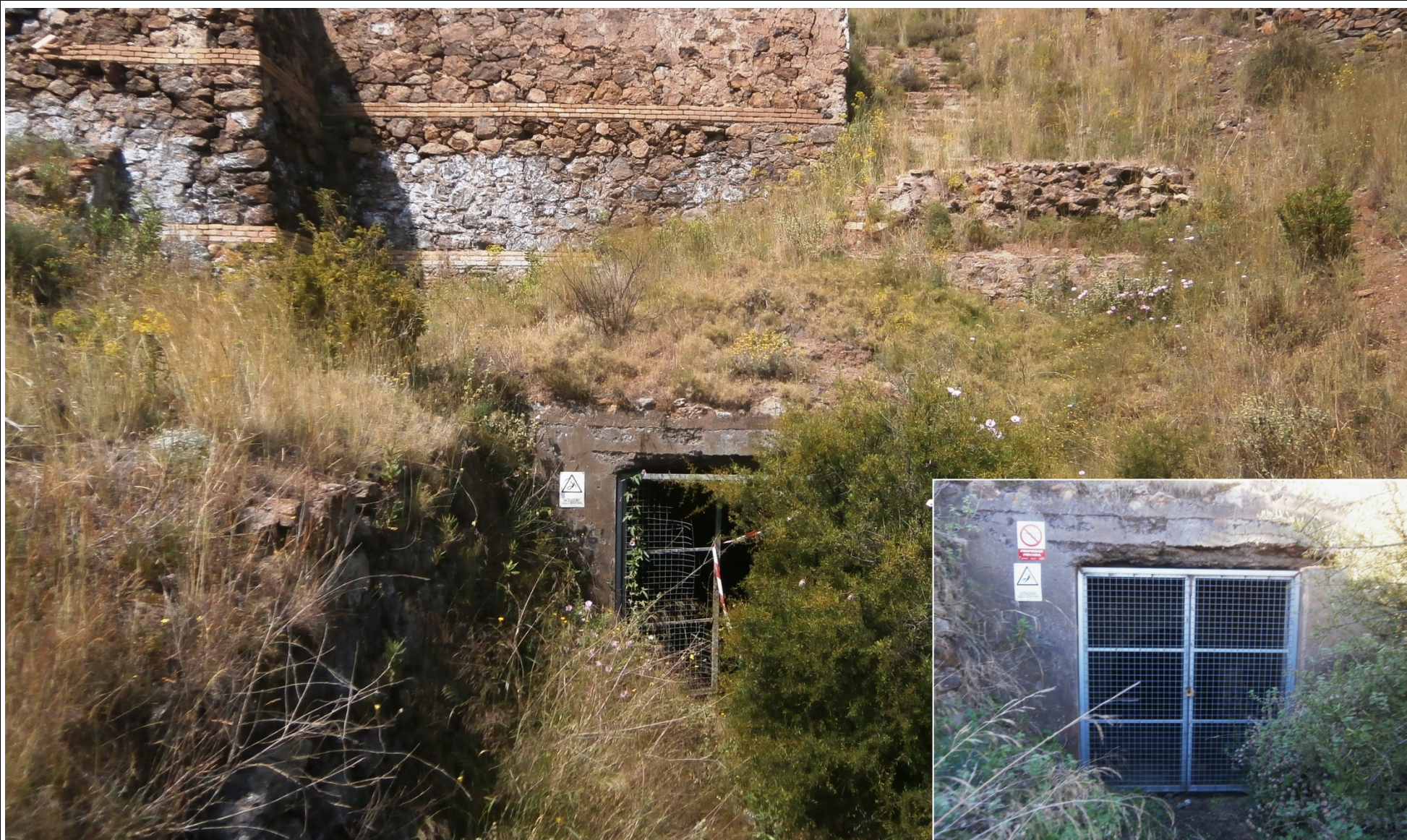
1 y 2. Vista general de la entrada al túnel de la mina María Dolores en la actualidad (2022) y en diciembre de 2021 con la puerta metálica cerrada (imagen pequeña).
