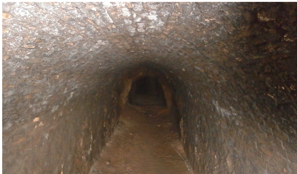
3, 4, 5 y 6. Tramo del túnel de la mina María Dolores fortificado con ladrillos macizos.
