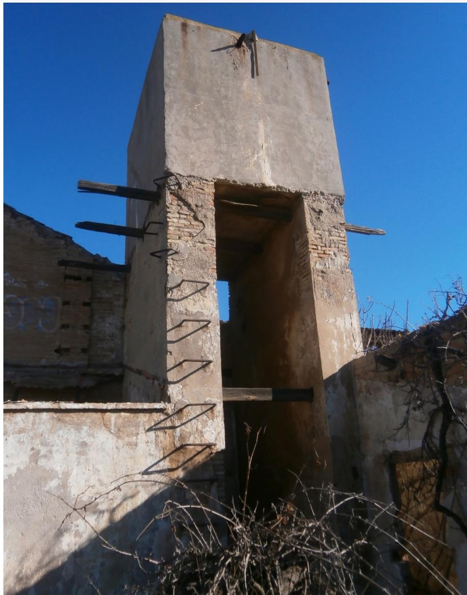
27. Gran depósito de agua cuadrangular elevado sobre dos muros de carga de ladrillo.
