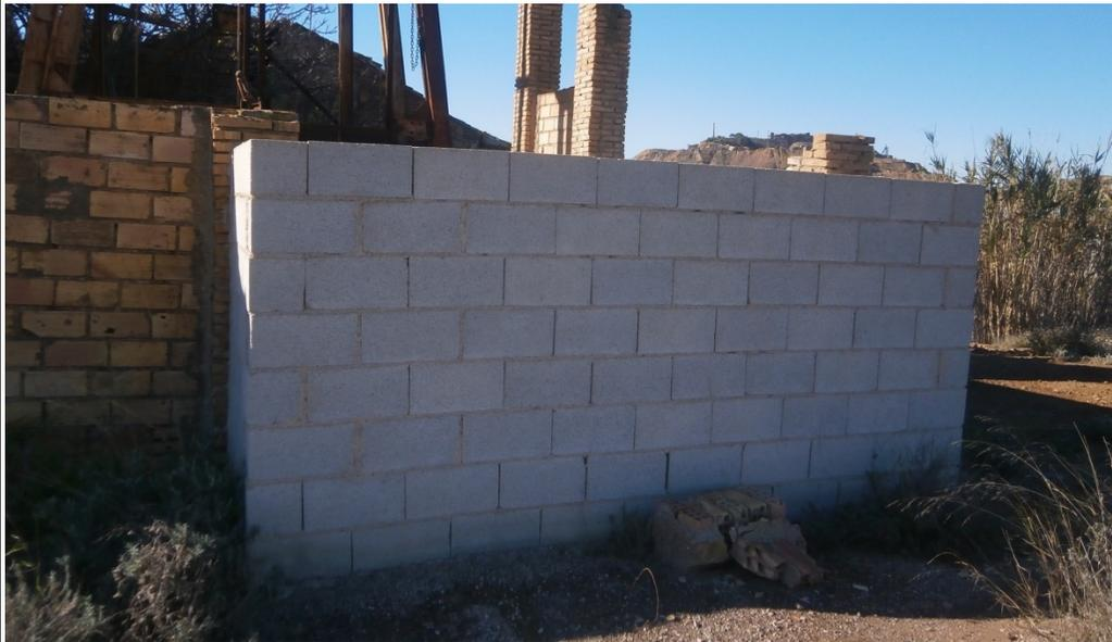
10 y 11. Exterior e interior del brocal de bloques de hormigón del pozo maestro de la
