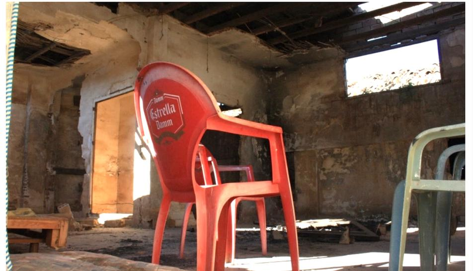
19, 20, 21 y 22. Estado actual de los edificios auxiliares del lavadero, con cubierta en mal estado, pintadas y signos de calcinación y de ocupación con muebles abandonados.
