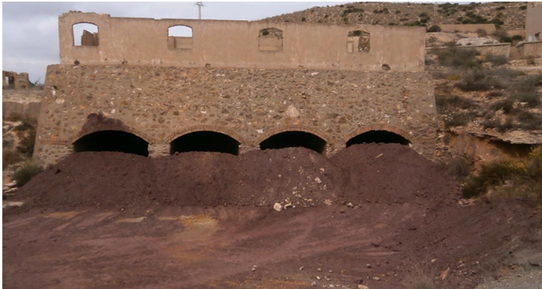
17. Estado de la fachada del edificio de tolvas en 2016 con restos de cenizas de pirita en sus vanos y con el paño de la fachada completa.
