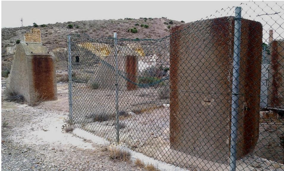
21 y 22. Pozo maestro de la mina en 2016 protegido con valla metálica y en la actualidad con brocal de bloques de hormigón.
