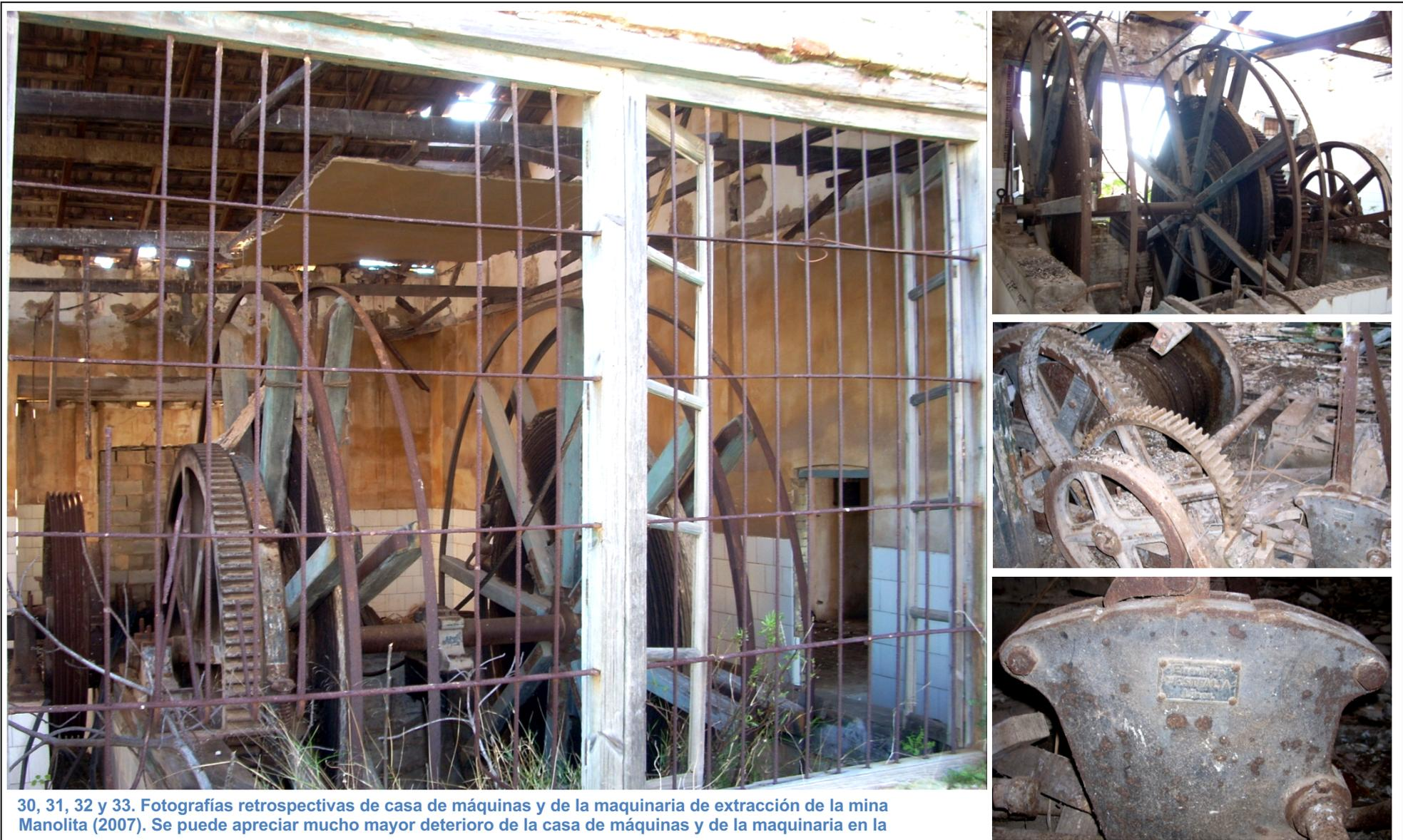
30, 31, 32 y 33. Fotografías retrospectivas de casa de máquinas y de la maquinaria de extracción de la mina Manolita (2007). Se puede apreciar mucho mayor deterioro de la casa de máquinas y de la maquinaria en la
