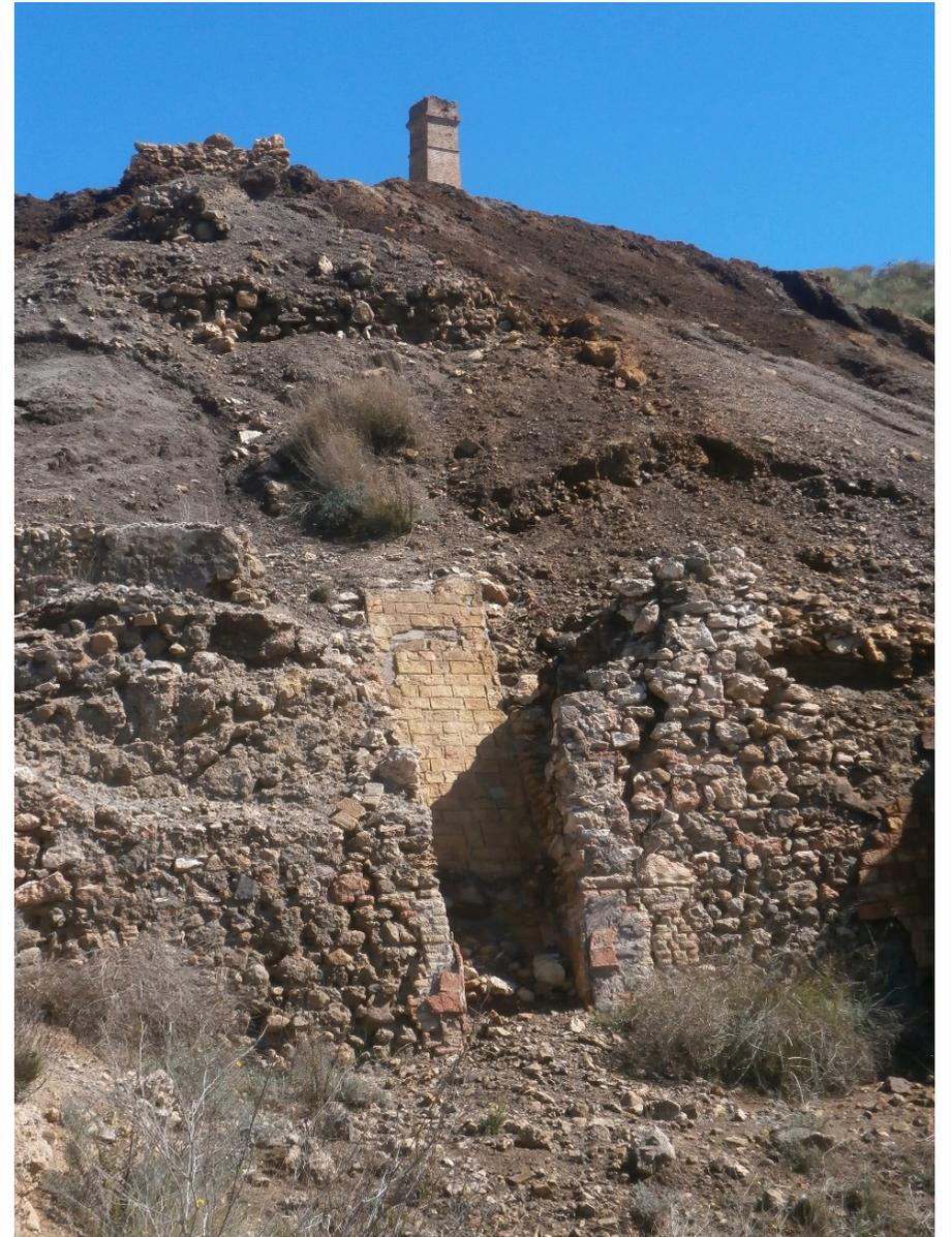
15 y 16. Tolva-rampa para el transporte del mineral del lavadero de la mina Manolita a una cota inferior.
