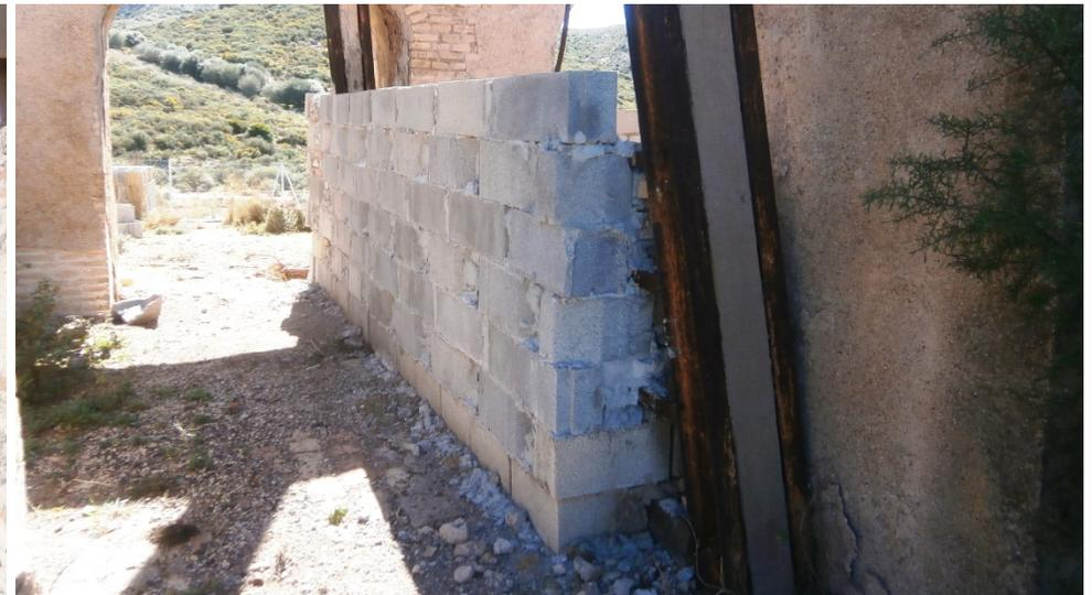
24 y 25. Exterior del pozo maestro con brocal realizado en bloques de hormigón en la actualidad (2022).
