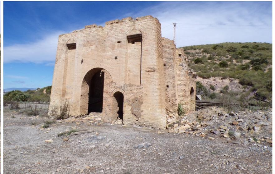
4 y 5. Muelle de carga del mineral construido en ladrillo macizo.
