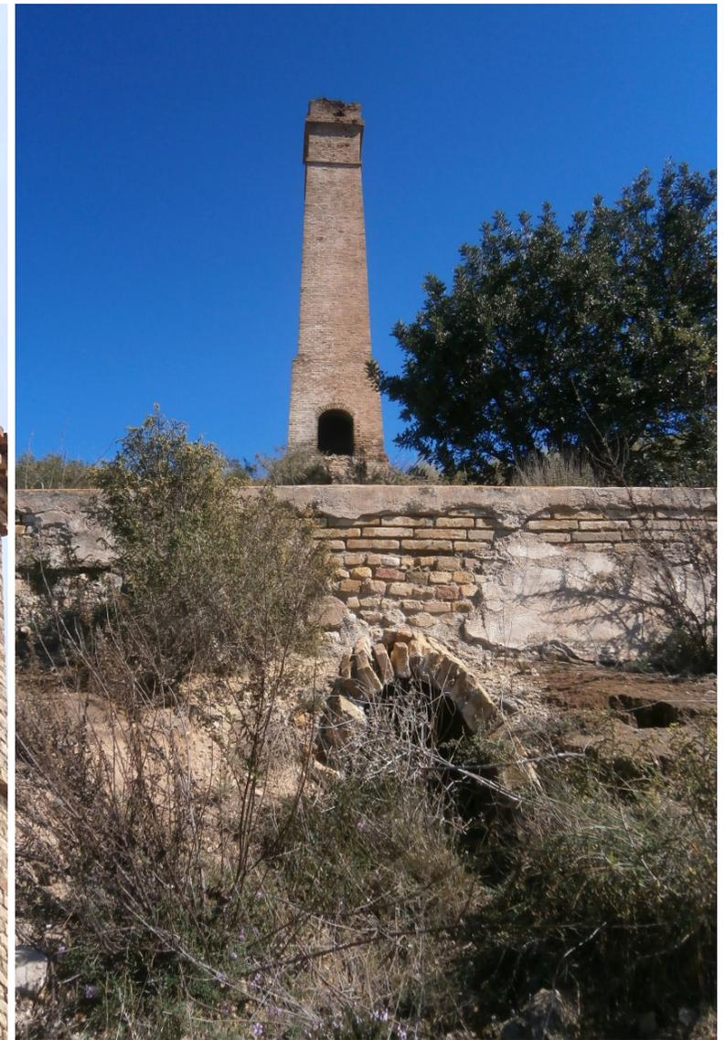
8. Restos de las galerías de humos que enlazan la chimenea con el lavadero gravimétrico existente ladera abajo (véase Ficha Nº 4).
