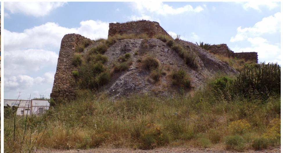
2 y 3. Vista general de la mina El Faro. Basamento casa de máquinas y plano inclinado de transporte del mineral hasta el ferrocarril.
