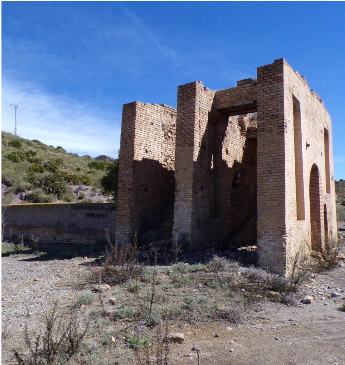
6. Vista del muelle de carga del mineral construido en ladrillo macizo.
