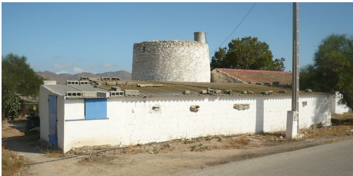
Imagen nº 177. Edificación anexa al Molino nº 220. Molino de la Escucha
