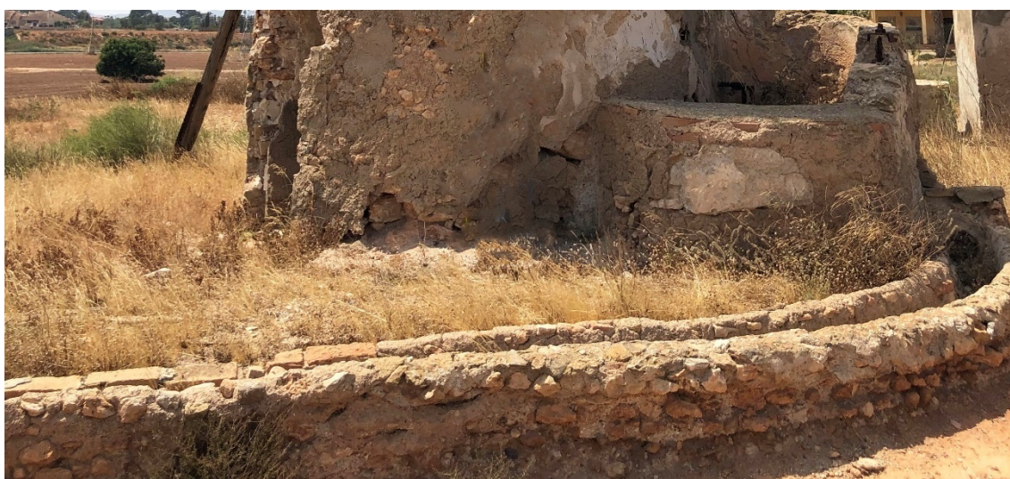
Imagen nº 91. Pozo, canal y andén Molino 042. Molino de Las Cañadas
