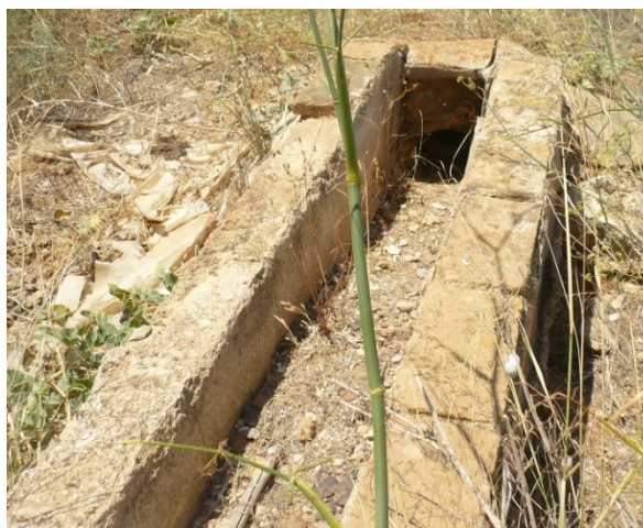
Imagen nº 95. Canal Molino 098. Molino del Tío Monterón
