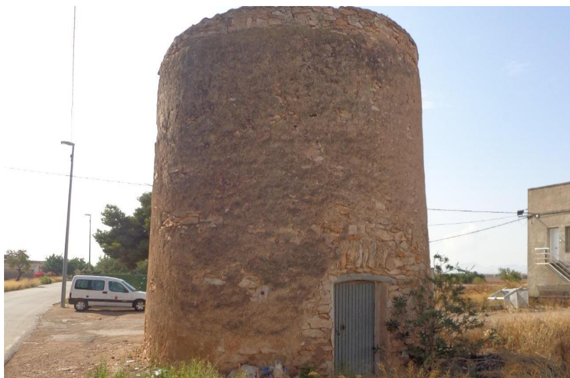
F2: Molino de La Pedrera. Alzado Noroeste. Acceso / DSC02669 - Exp 38061 DGBC
