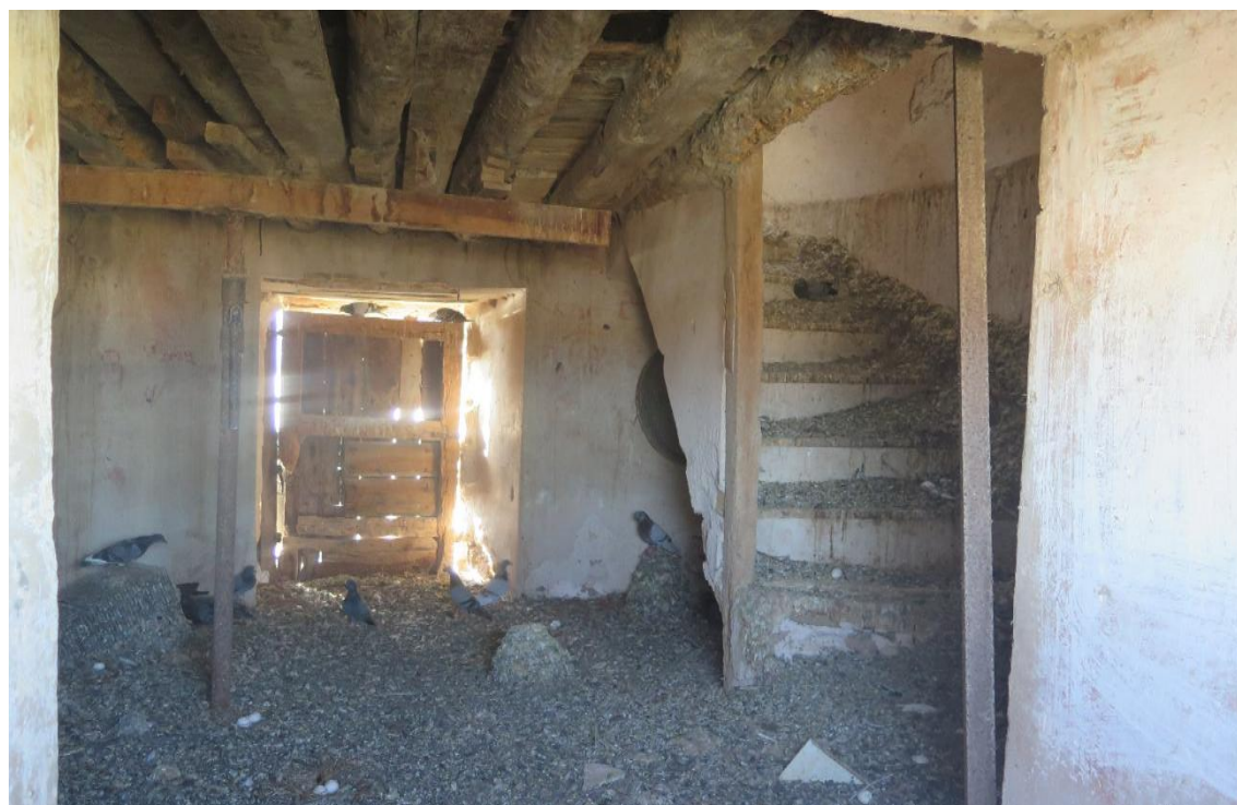
F4: Molino de Cope. Interior planta baja / IMG_3911
