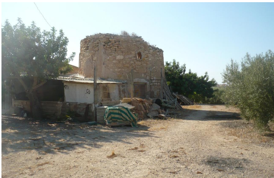
F3: Molino Los Romeras. Vista Sureste. Acceso / P1390208
