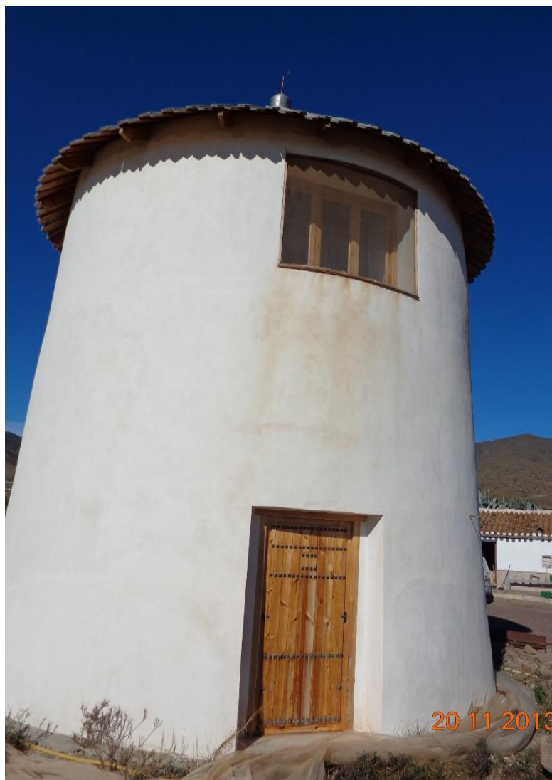
F3: Molino de Encarna. Vista Sureste. Acceso y ventana de levante / DSC03310 - Exp 24644 DGBC
