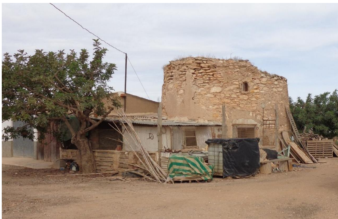
F1: Molino Los Romeras. Vista Sureste. Acceso / DSC01870 - Exp 30860 DGBC
