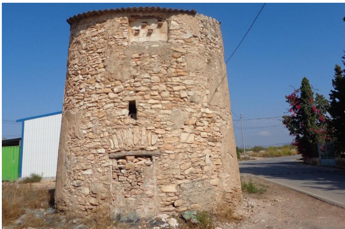
F1: Molino de La Pedrera. Alzado Sureste. Acceso / DSC02672 - Exp 38061 DGBC
