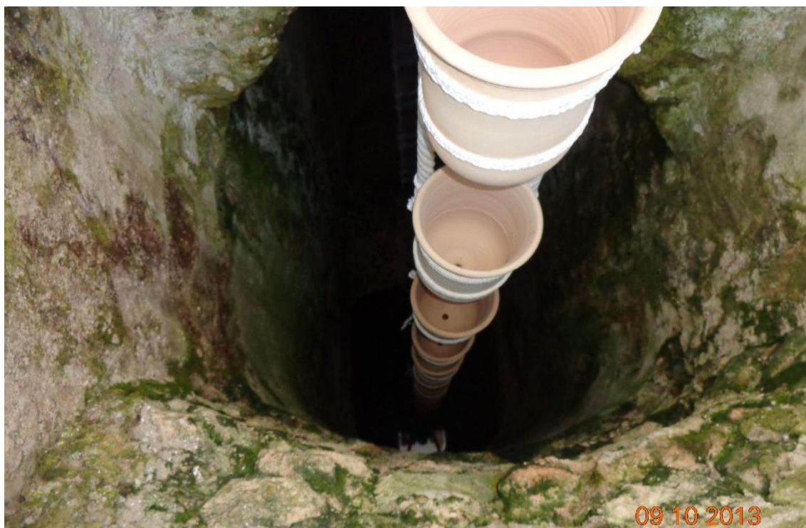
F4: Molino de Los Pereas. Cangilones dentro del pozo / DSC02854 - Exp 38052 DGBC
