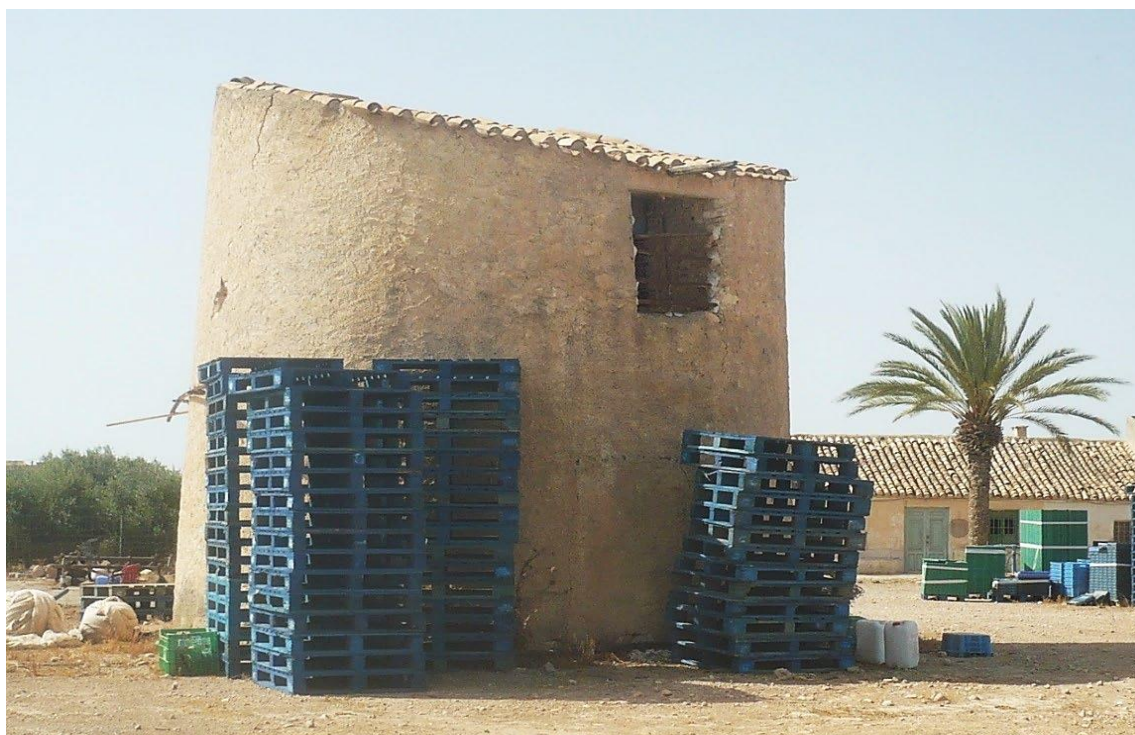
F1: Molino del Campanero. Alzado Sureste. Acceso / P1370706
