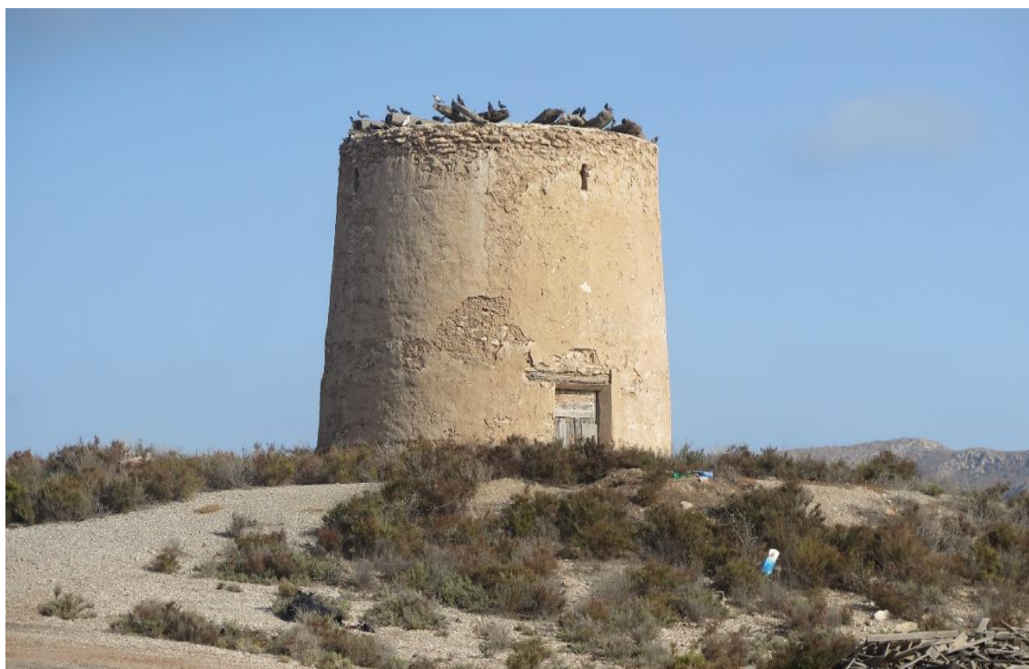
F3: Molino de Cope. Alzado Noroeste. Acceso / IMG_3900
