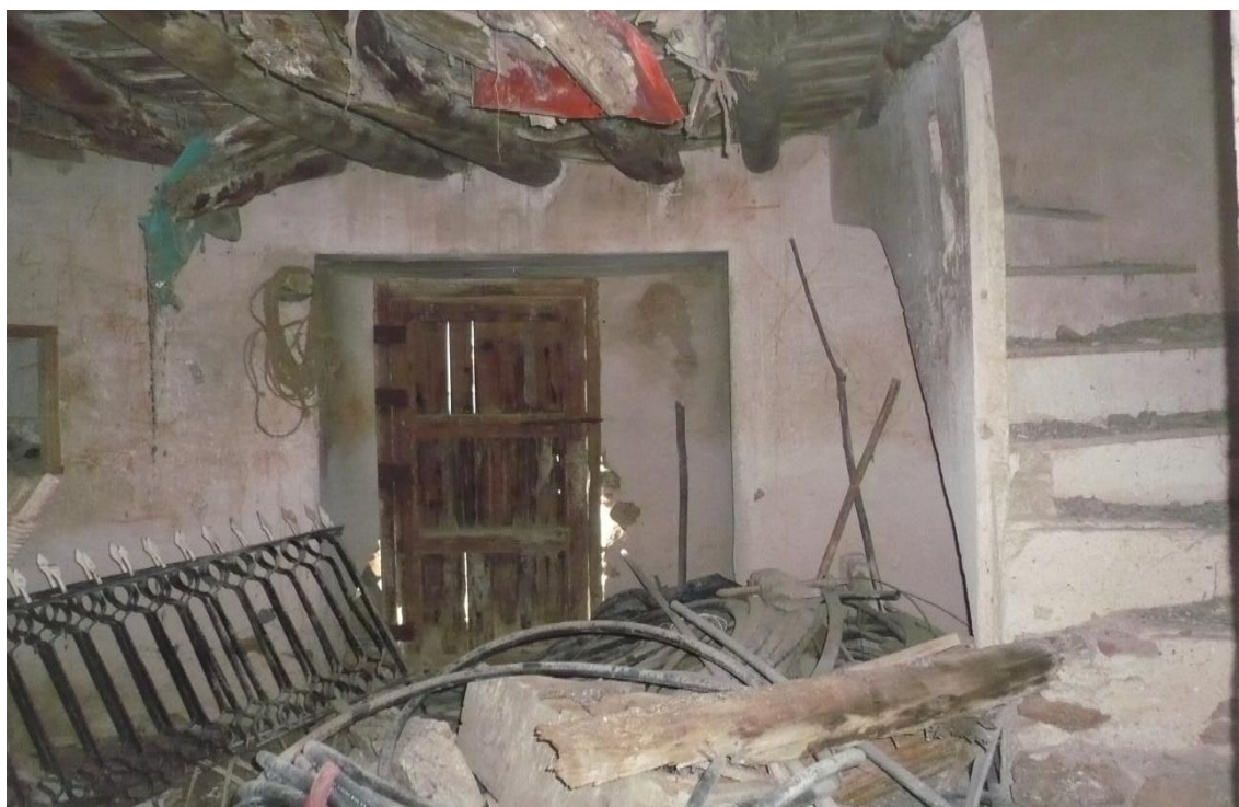
F4: Molino de la Casa de Parazuelos. Vista Interior y acceso NW / P1380702
