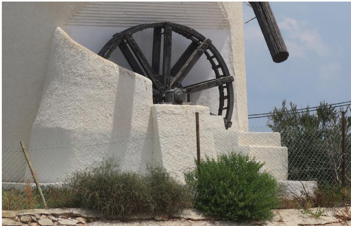
F6: Molino de Lo Rizo del Pino. Pozo y rueda de arcaduces / IMG_1134
