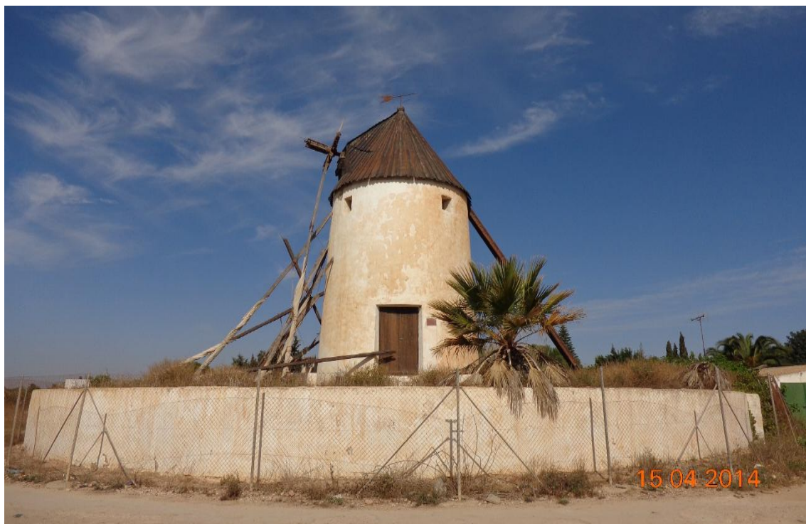
F3: Molino de las Casicas. Alzado Sureste. Acceso / DSC01018 - Exp 160771 DGBC
