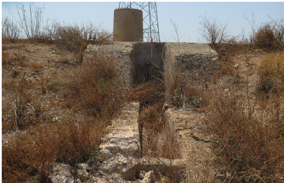
F8: Molino El Arquillo. Canal / IMG_0437
