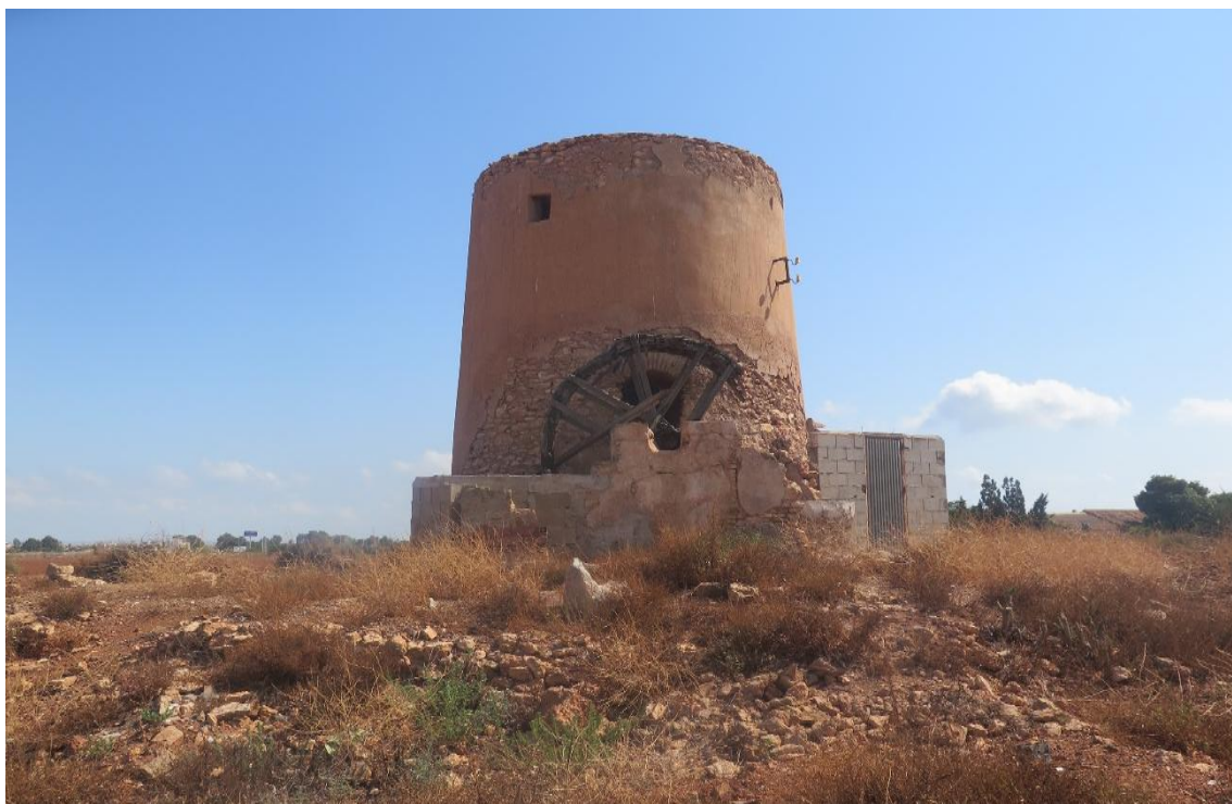
F5: Molino Lo Monteron. Alzado Suroeste. Pozo / IMG_2997
