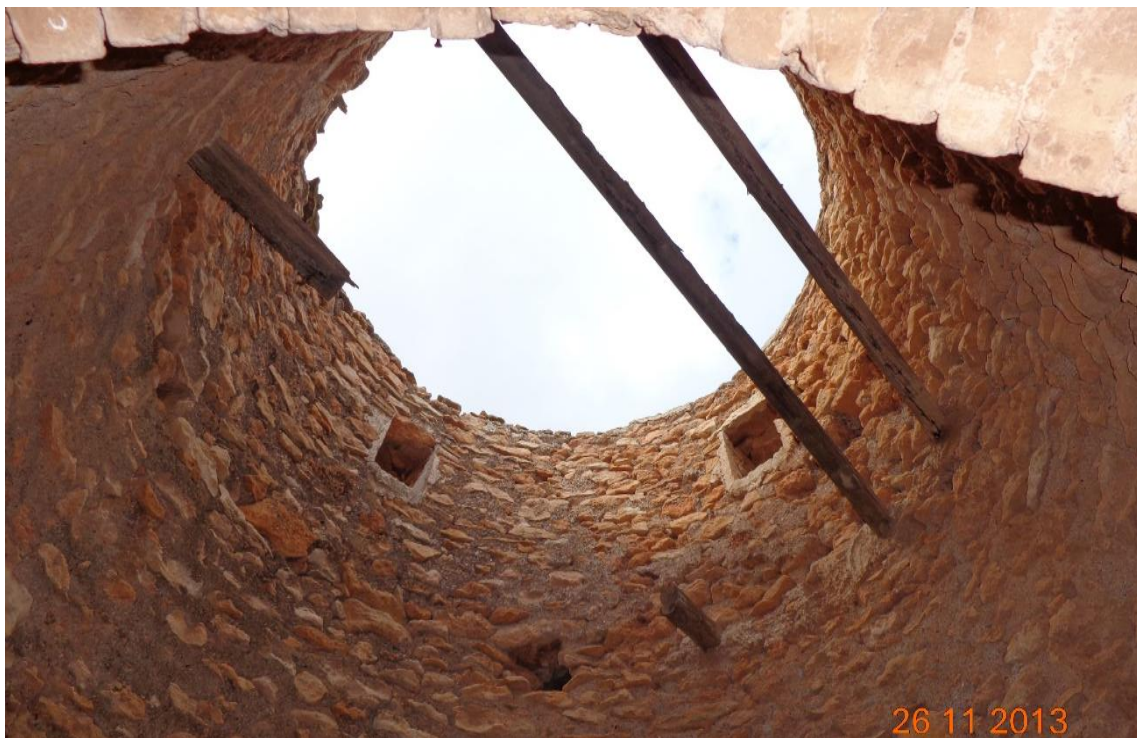
F3: Molino de Los Cuenca . Interior torre / DSC03378 - Exp 160751 DGBC
