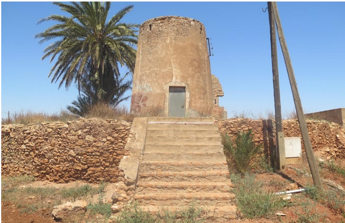
F5: Molino Miramar. Alzado Sureste. Acceso / IMG_3118
