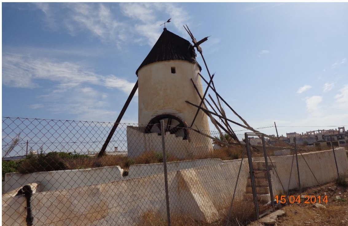
F4: Molino de las Casicas. Alzado Suroeste. Pozo y balsa / DSC01014 - Exp 160771 DGBC
