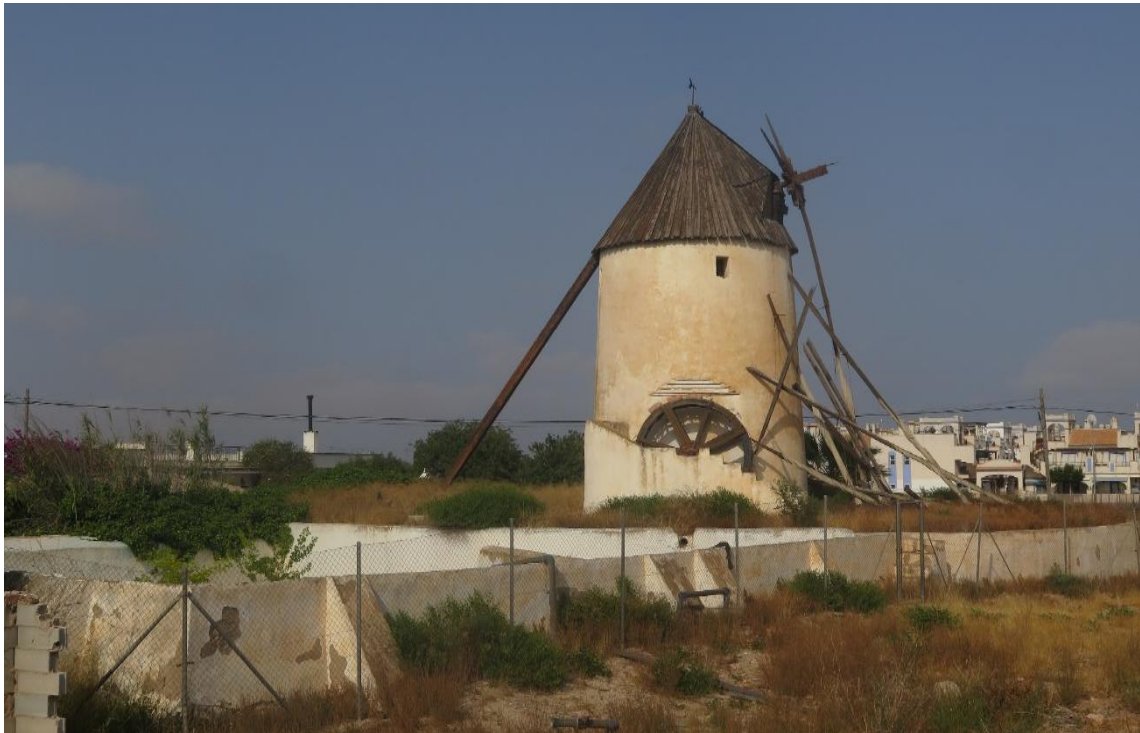
F5: Molino de las Casicas. Alzado Suroeste. Pozo y balsa / IMG_0659
