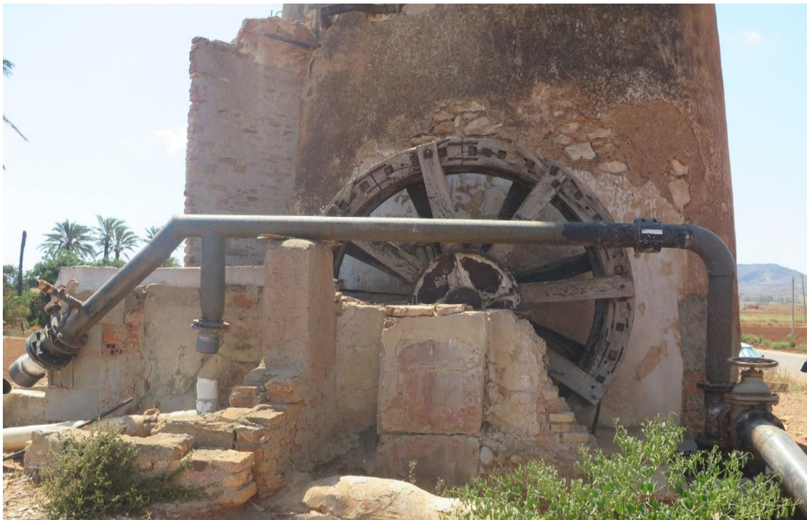
F6: Molino Miramar. Pozo y tambor de arcaduces / IMG_3097
