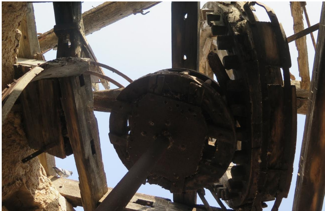
F8: Molino de los Roses. Maquinaria del aire / IMG_0570
