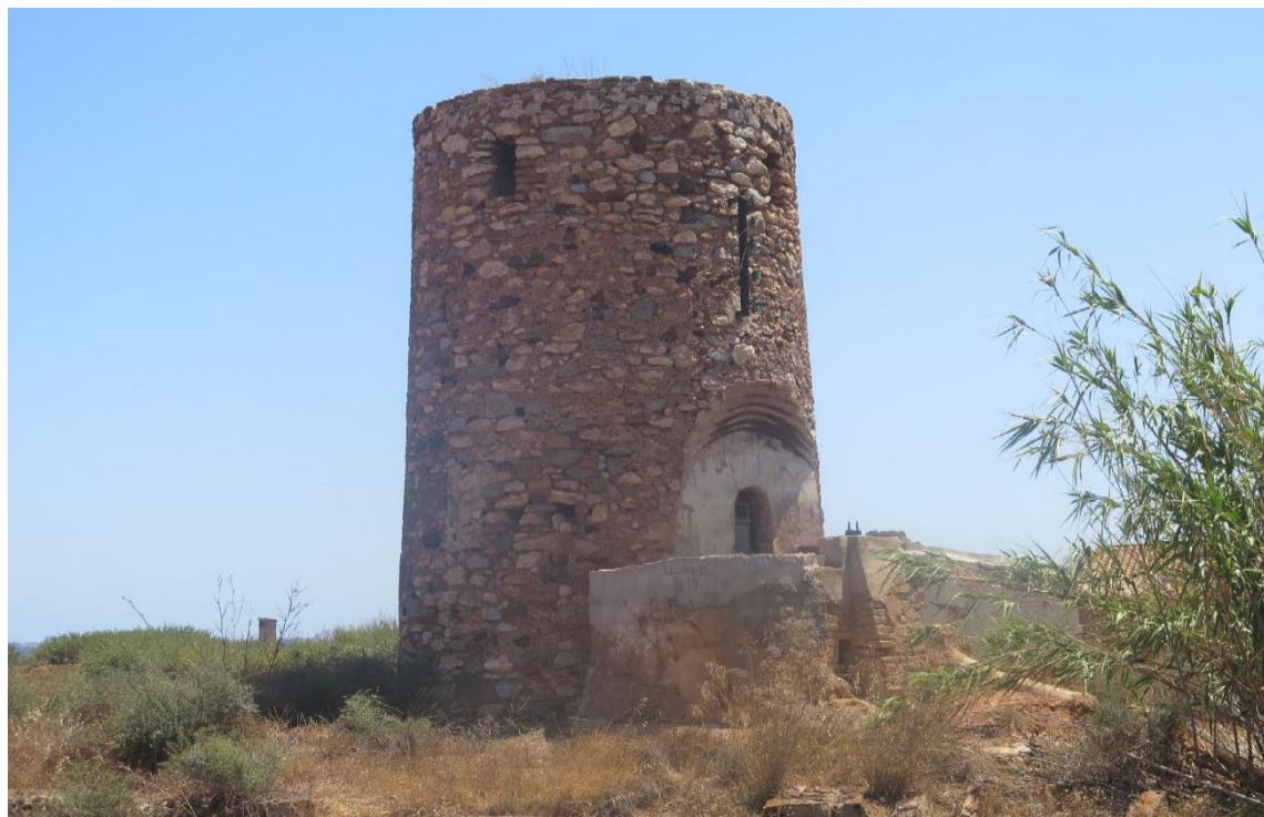
F5: Molino La Huertecica. Alzado Oeste. Vista pozo / IMG_3168
