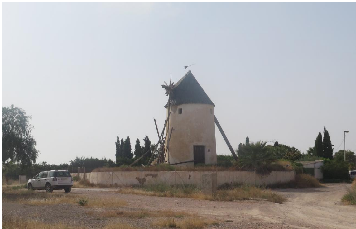
F6: Molino de las Casicas. Alzado Sureste. Acceso / IMG_0653
