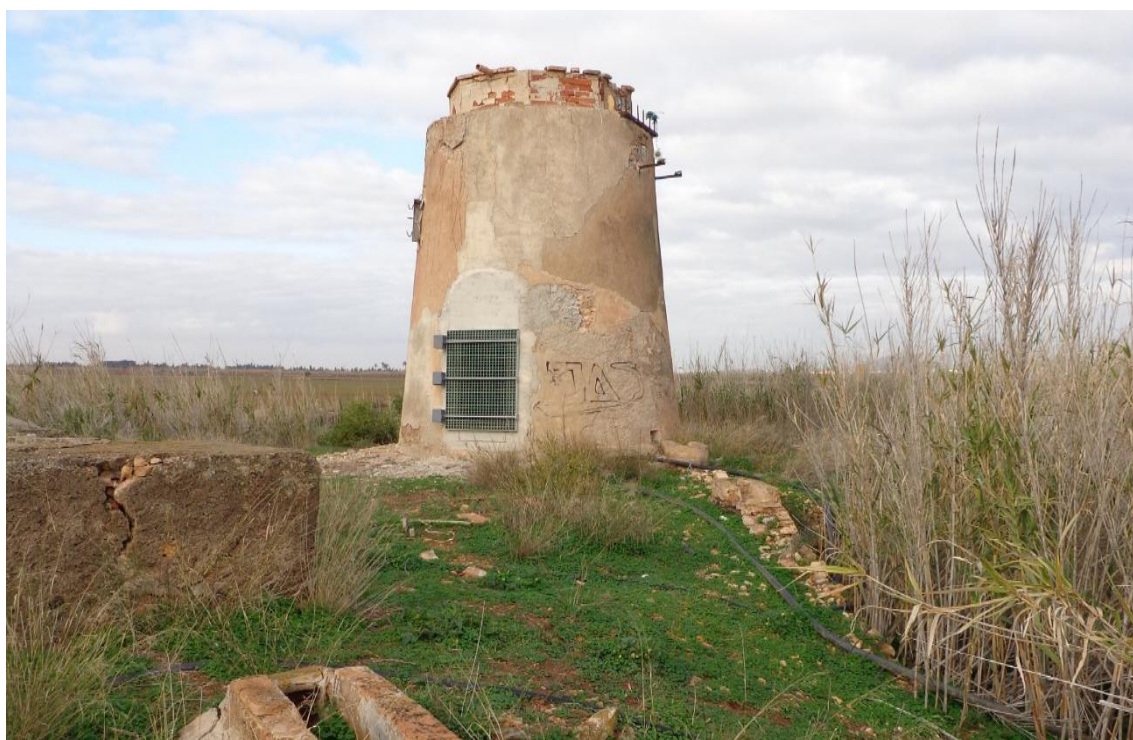
F3: Molino Tío Monterón. Alzado Sureste. Acceso / DSC03489 - Exp 160763 DGBC
