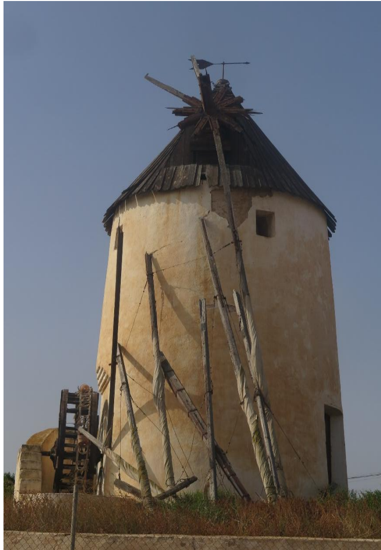
F7: Molino de las Casicas. Alzado Sur. Vista acceso y pozo / IMG_0652
