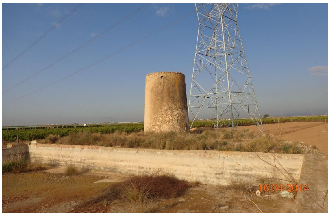
F3: Molino El Arquillo. Vista Noreste. Molino y Balsa / DSC01036 - Exp 160773 DGBC
