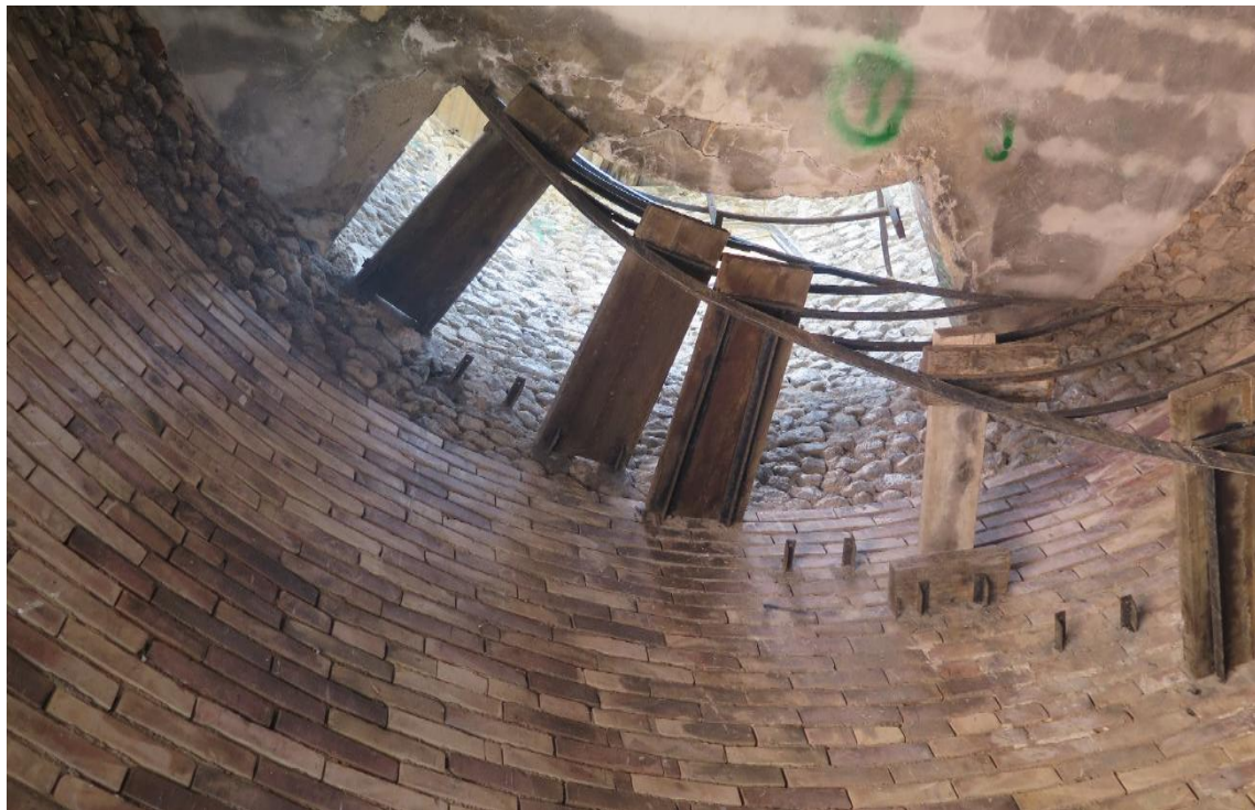
F7: Molino Las Palmeras. Vista Interior torre desde andén / IMG_0805
