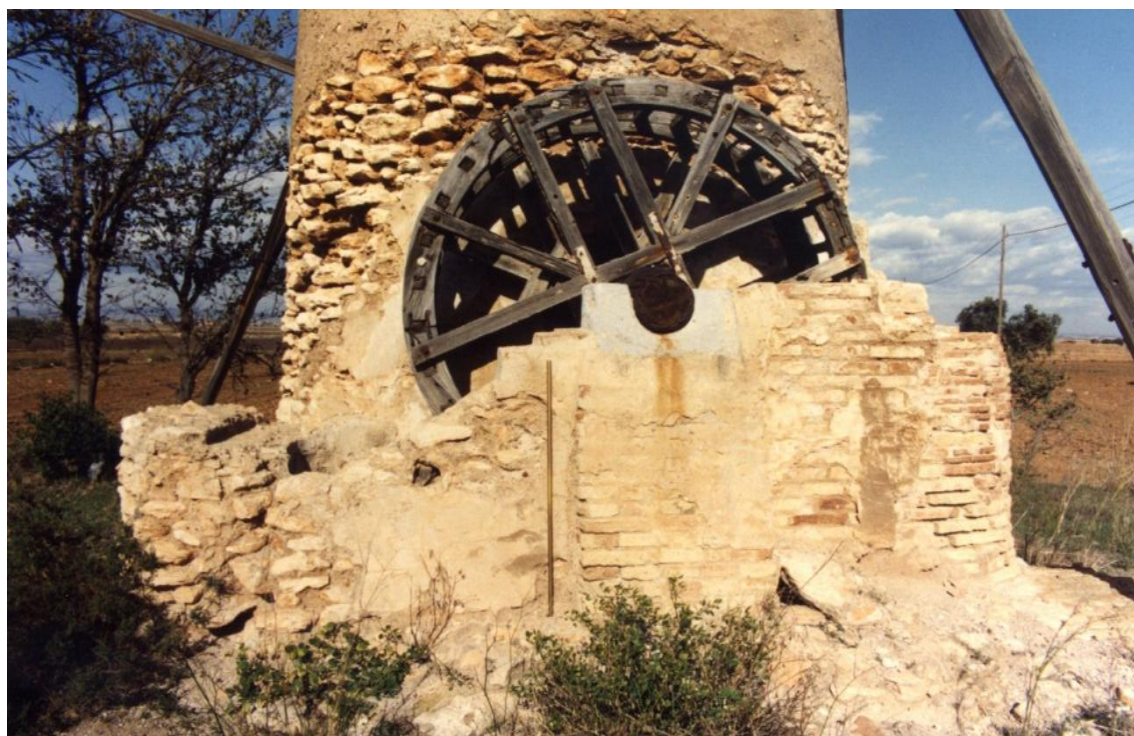
F2: Molino Los Zaleano. Pozo y tambor de arcaduces / 160743 -1- Año 1989 - Exp 160743 DGBC
