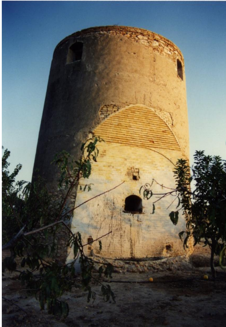
F1: Molino de elevar agua. Alzado Noroeste. Pozo / 160724-1-Año 1989 - Exp 160724 DGBC
