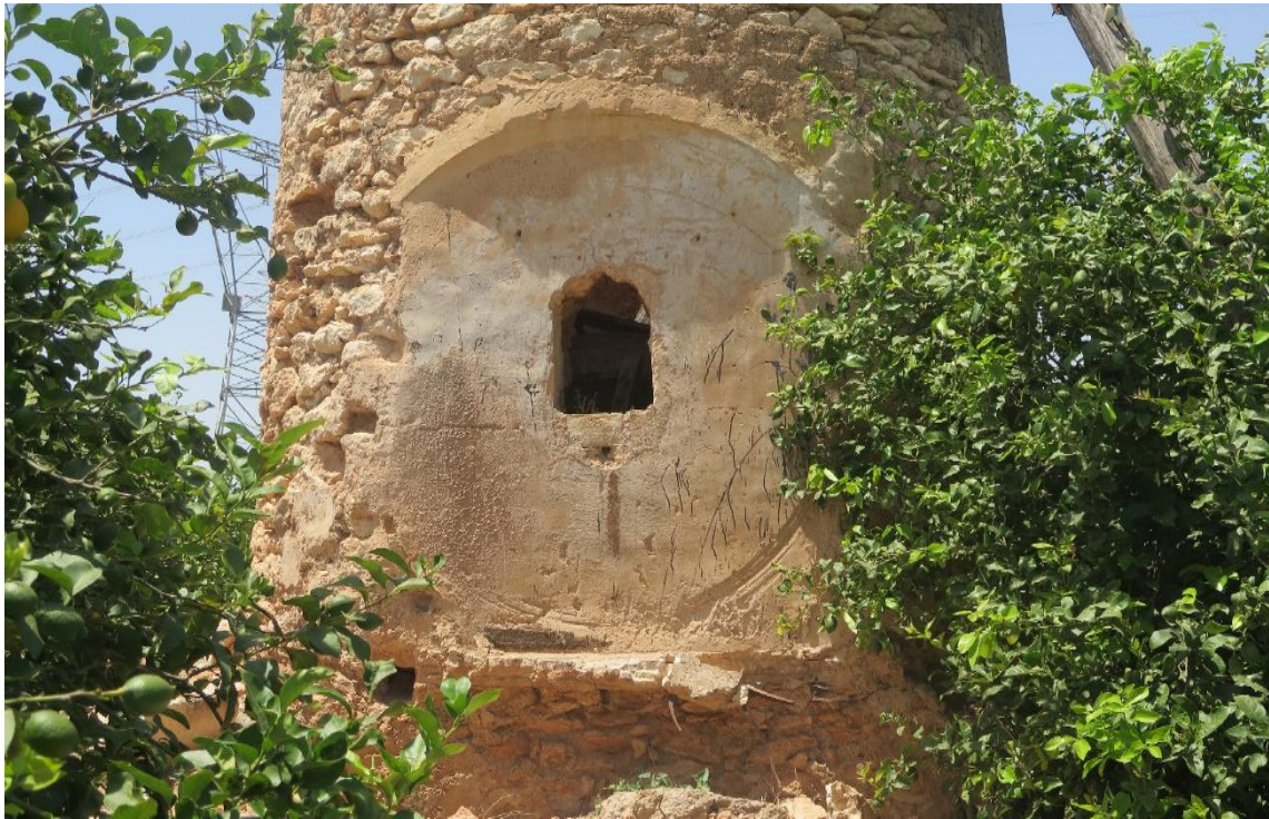
F6: Molino Lo Ferreros. Alzado Sureste. Pozo / IMG_2095
