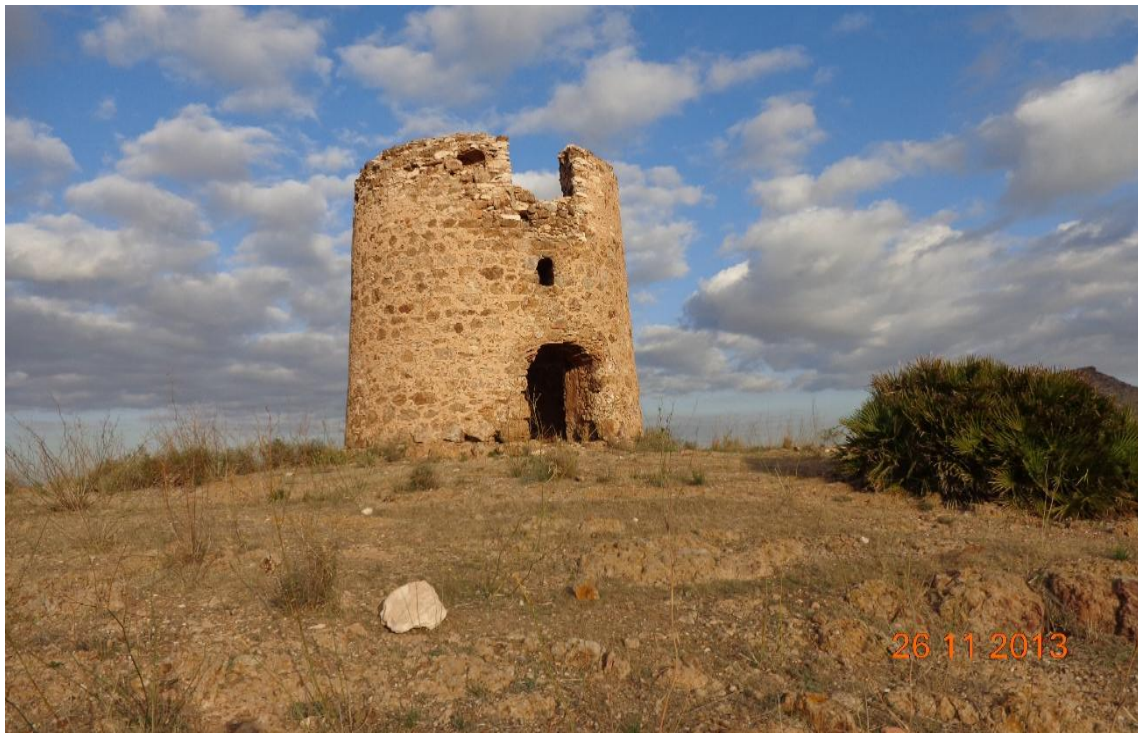
F2: Molino del Miedo. Alzado Sur. Vista acceso y ventana de levante / DSC03327- Exp 160748 DGBC
