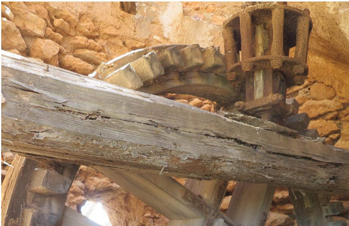
F8: Molino Los Zaleano. Linterna y Rueda del infierno / IMG_2489
