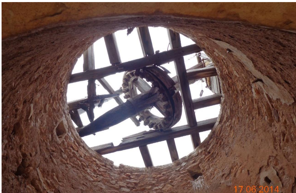
F4: Molino Lo Ferreros. Telar y rueda del aire / DSC01557 - Exp 160734 DGBC
