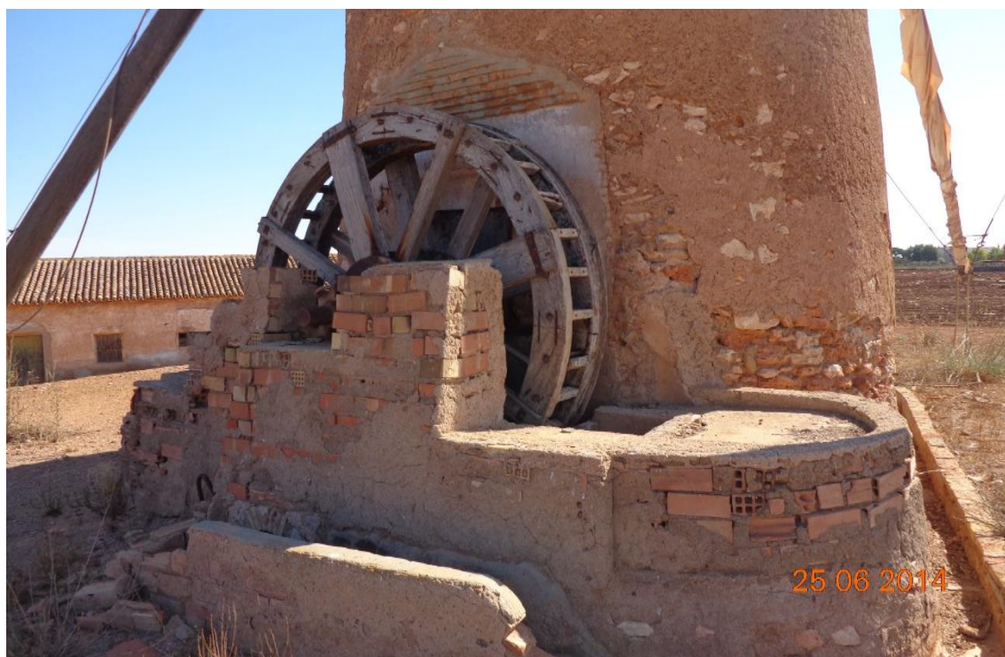
F4: Molino Los Cobachos. Pozo y tambor de arcaduces / DSC01666 - Exp 160725 DGBC
