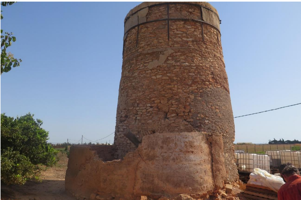
F5: Molino Viejo Paco Luengo. Alzado Sur. Vista pozo / IMG_1904
