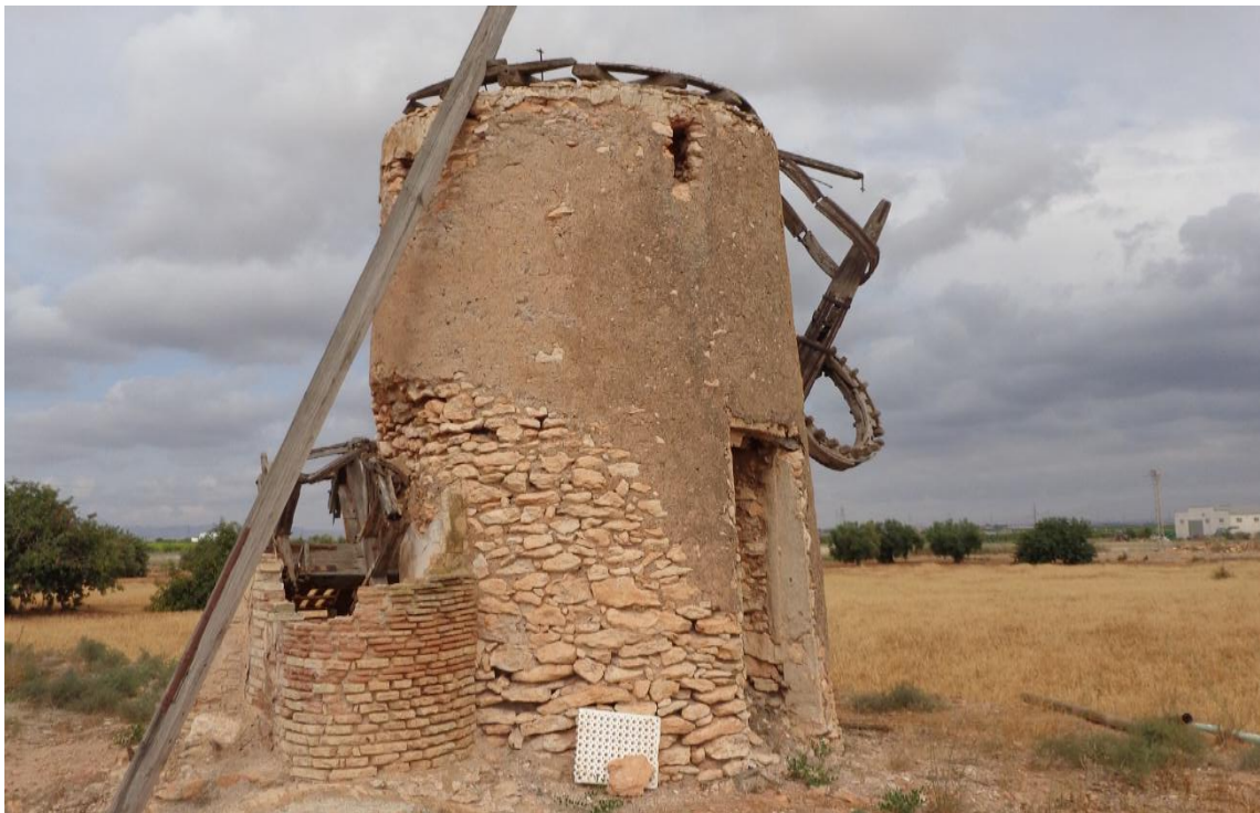
F4: Molino Los Zaleano. Alzado Este. Vista Acceso y Pozo / DSC01542 - Exp 160743 DGBC
