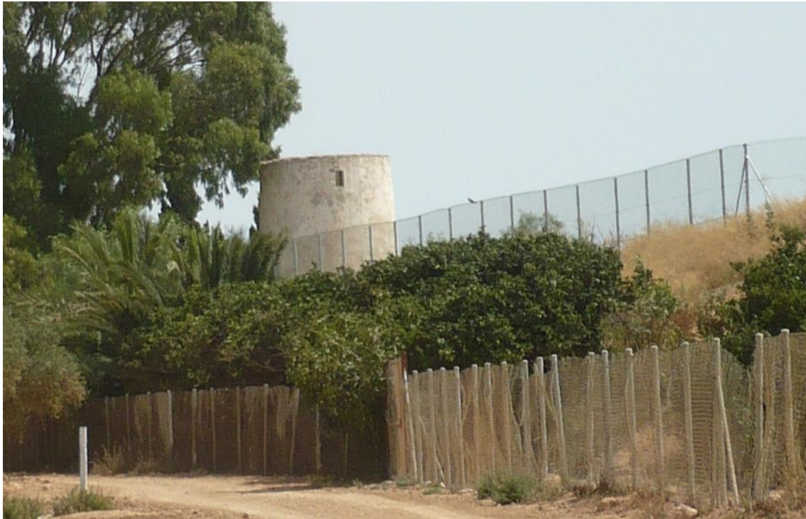
F5: Molino La Flora. Vista Suroeste. Pozo / P1370931
