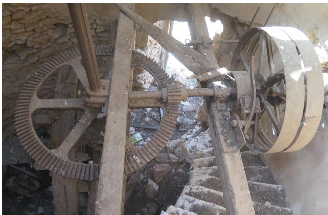
F8: Molino Los Isauras. Maquinaria del agua / IMG_2260
