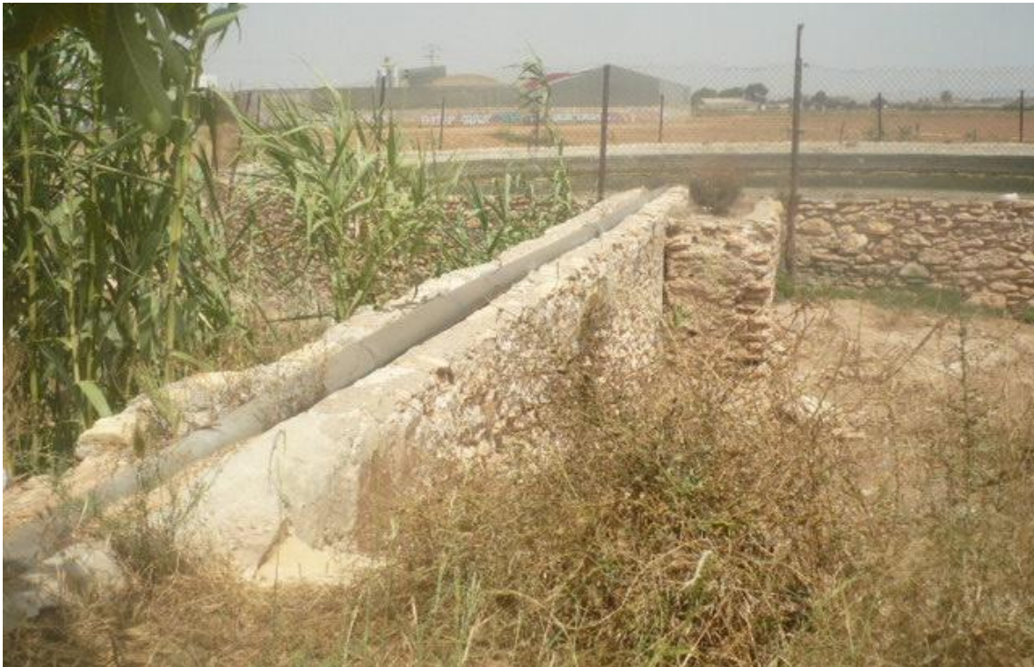
F6: Molino La Mariposa. Acueducto y balsa / P1360712
