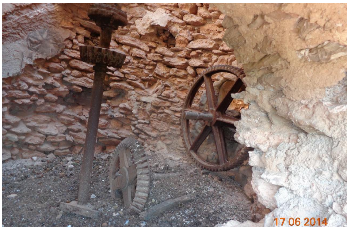
F3: Molino de Balsalobre. Vista interior acceso / DSC01595 - Exp 160736 DGBC
