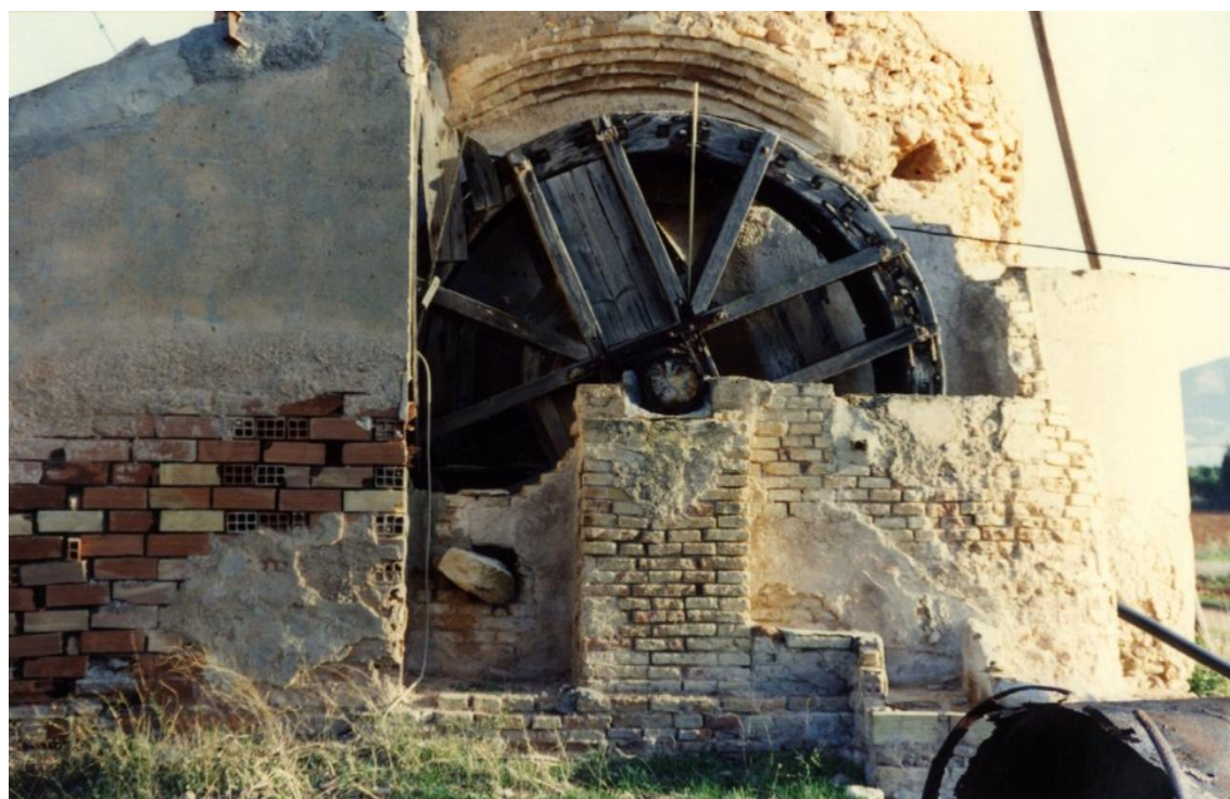
F2: Molino Lo Rufo. Pozo y rueda de arcaduces / 160723-1-Año 1989 - Exp 160723 DGBC
