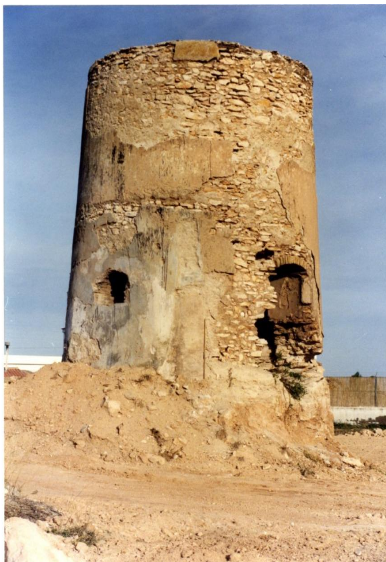
F1: Molino Blaya. Alzado Suroeste.Vista Acceso y Pozo / 160744 -1- Año 1989 - Exp 160744 DGBC
