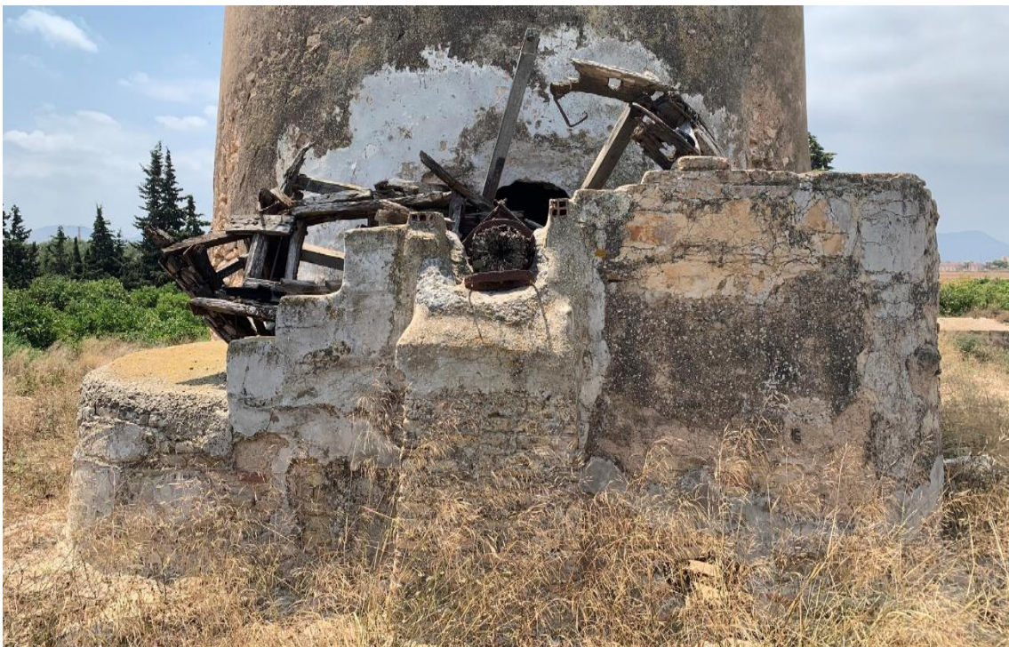
F5: Molino de Los Madriles. Alzado Norte. Pozo y rueda de Arcaduces / IMG_4935
