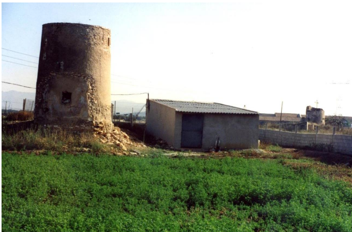
F1: Molino de Los Rosiques. Alzado Norte. Pozo. Al fondo Molino 019 demolido / 160683-3-Año 1989 - Exp 160683 DGBC
