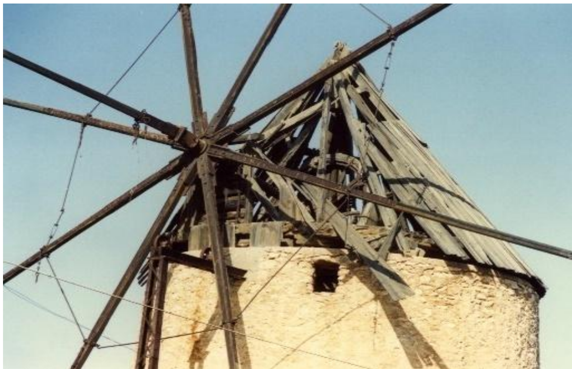
F2: Molino Los Bartolones . Chapitel y corona metálica / 160688-2-Año 1989 - Exp 160688 DGBC
