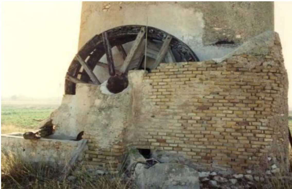
F2: Molino de la Buena Muerte. Tambor de arcaduces y pozo/ 160674-1-Año 1989 - Exp 160674 DGBC
