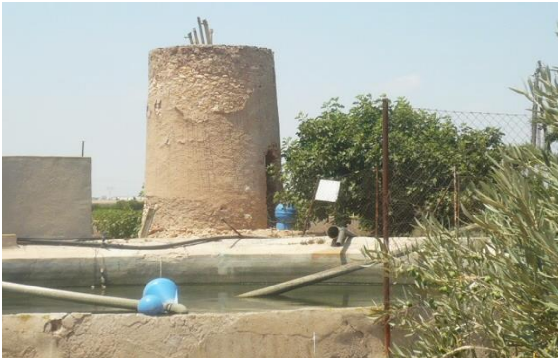
F5: Molino de Los Rosiques. Alzado Sur. Vista de acceso y balsa /P1360453
