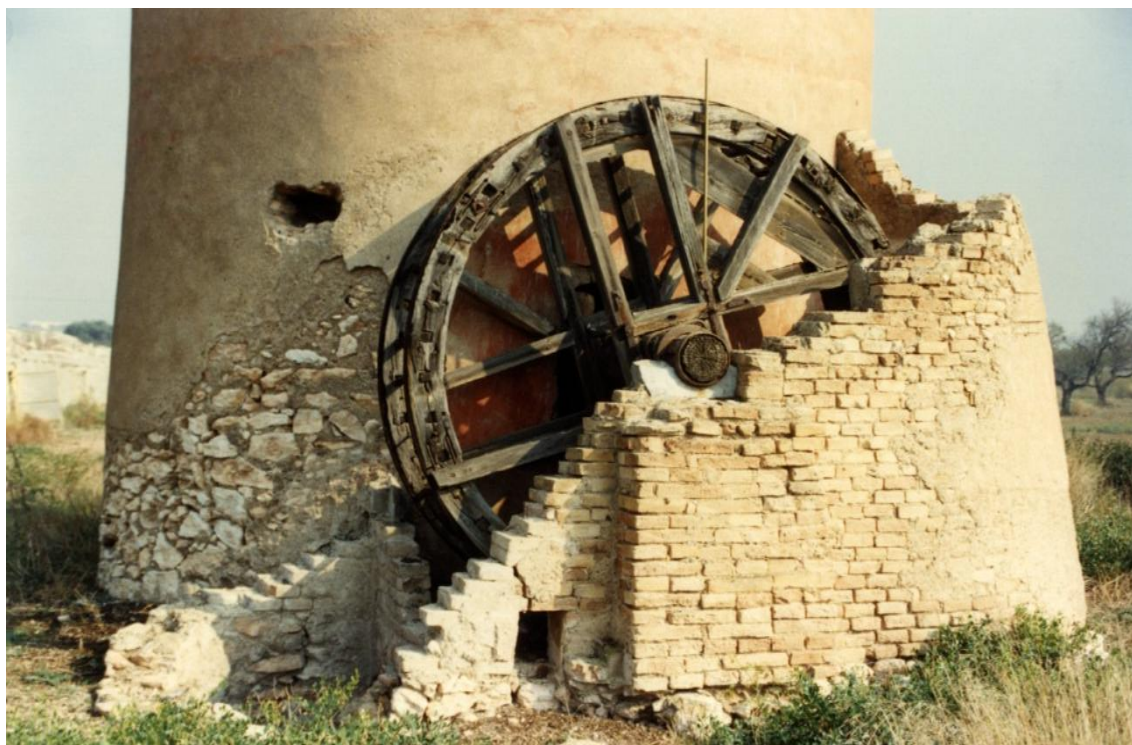
F2: Molino Colorao. Tambor de arcaduces y pozo / 160668 -1-1989- Exp 160668 DGBC
