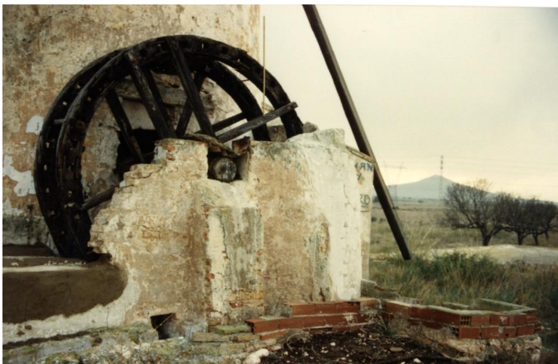
F2: Molino del Tío Lobo. Pozo y Tambor de arcaduces / 160665-2-1989- Exp 160665 DGBC
