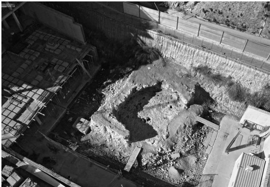
Lámina 5. Vista aérea de la cavidad finalizada la excavación y restaurada la estructura que la cubría.
