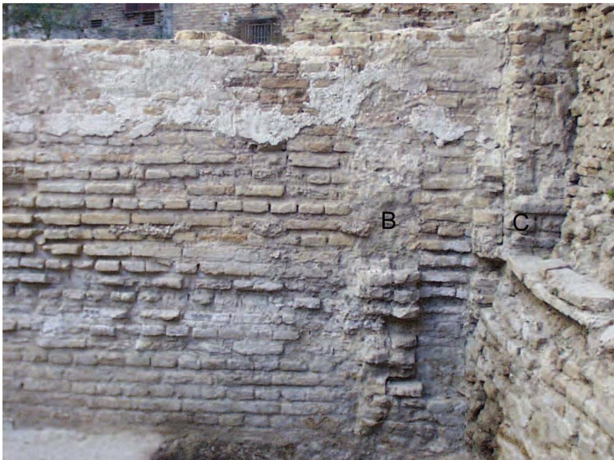
Lámina 5. Extremo oriental de la obra cristiana con las dos mochetas aparejadas B y C, la de la derecha semioculta por la medianera y la de la izquierda parcialmente recortada en una fase posterior.
