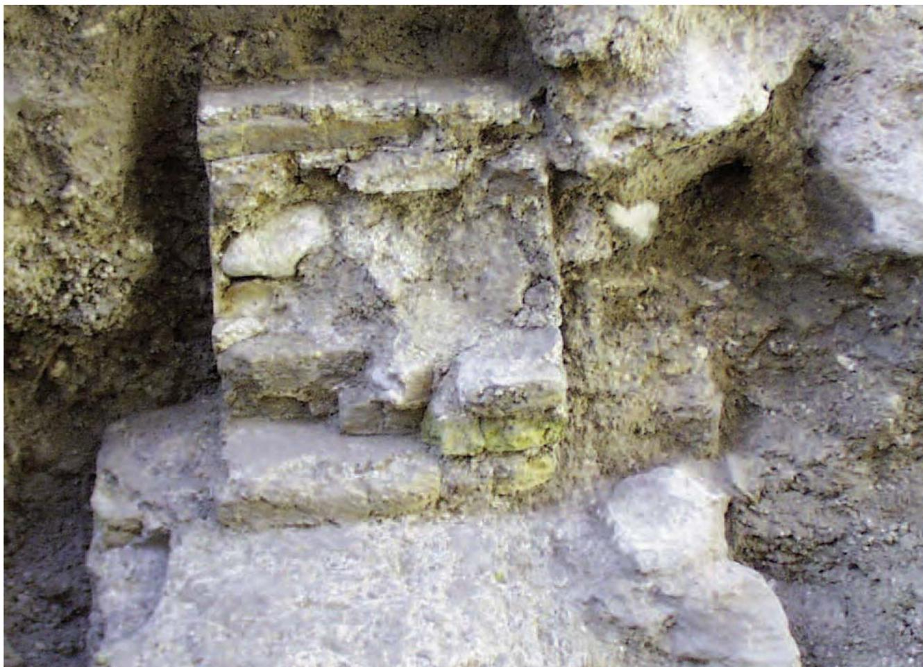
Lámina 12. Umbral de ladrillo y mortero de cal sobre el muro de contención de argamasa encofrada.
