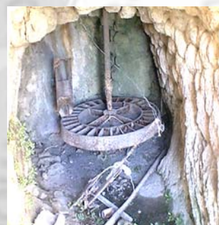
Fig.3: Cárcavo del molino Rejano.
