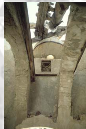
Figura 3: Arcos de cantería
