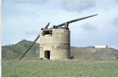
Figura 8: En esta vista del molino del Pozo de los Frailes se observa la situación de la volandera en la cama del molino. Igualmente se aprecia el palo guía y parte del telar. El estado de la mampostería es excelente.
