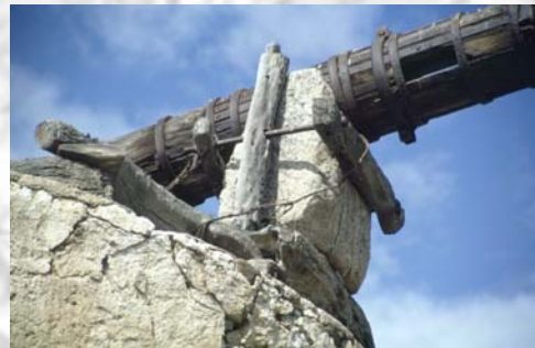
Figura 7: Detalle de la piedra fuélliga, hojalambres, restos del eje y vírgenes sobre lo que queda del telar.
