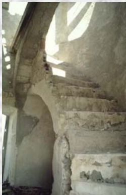
Figura 4: Detalle de la escalera y troje.
