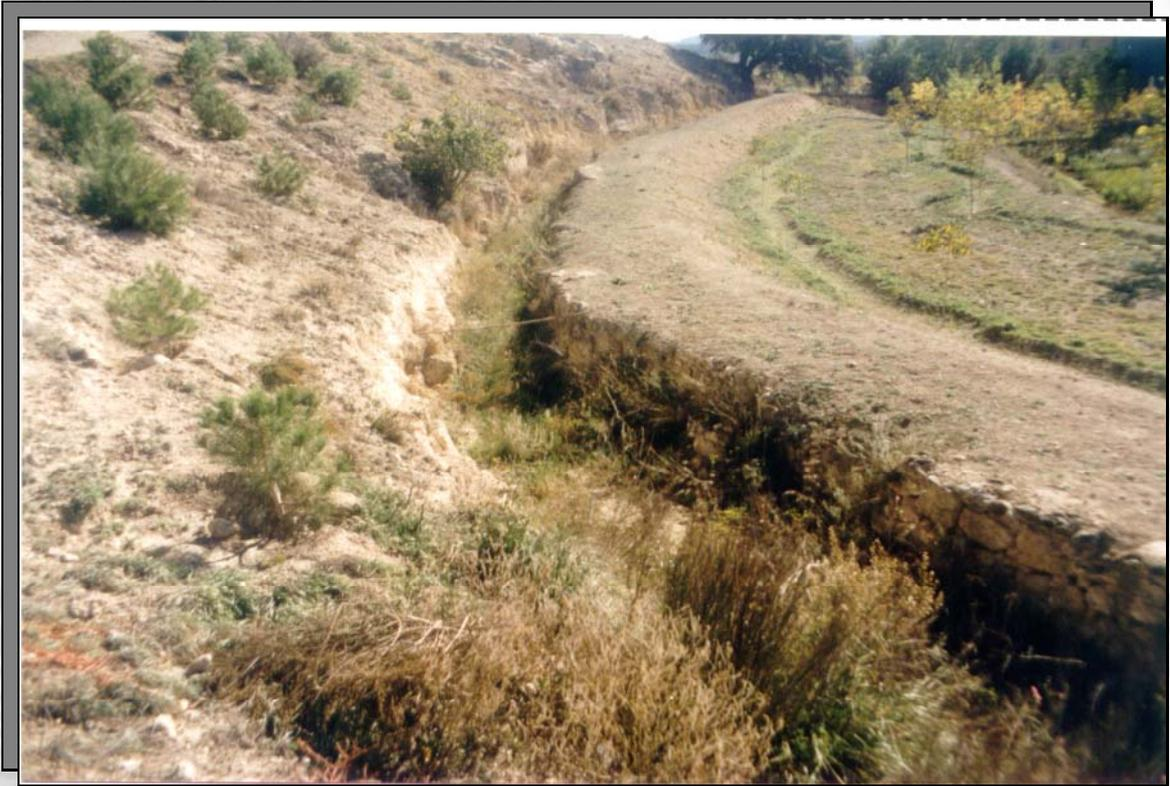
Lám. V. Canal abierto en la roca que conduce a los cubos de molino de Las Fuentes, huerta de Caravaca.
