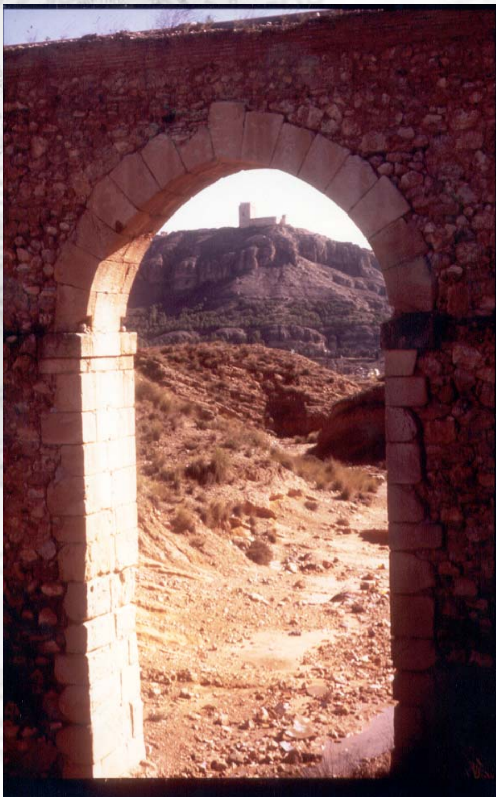
ACUEDUCTO EL PONTÓN
