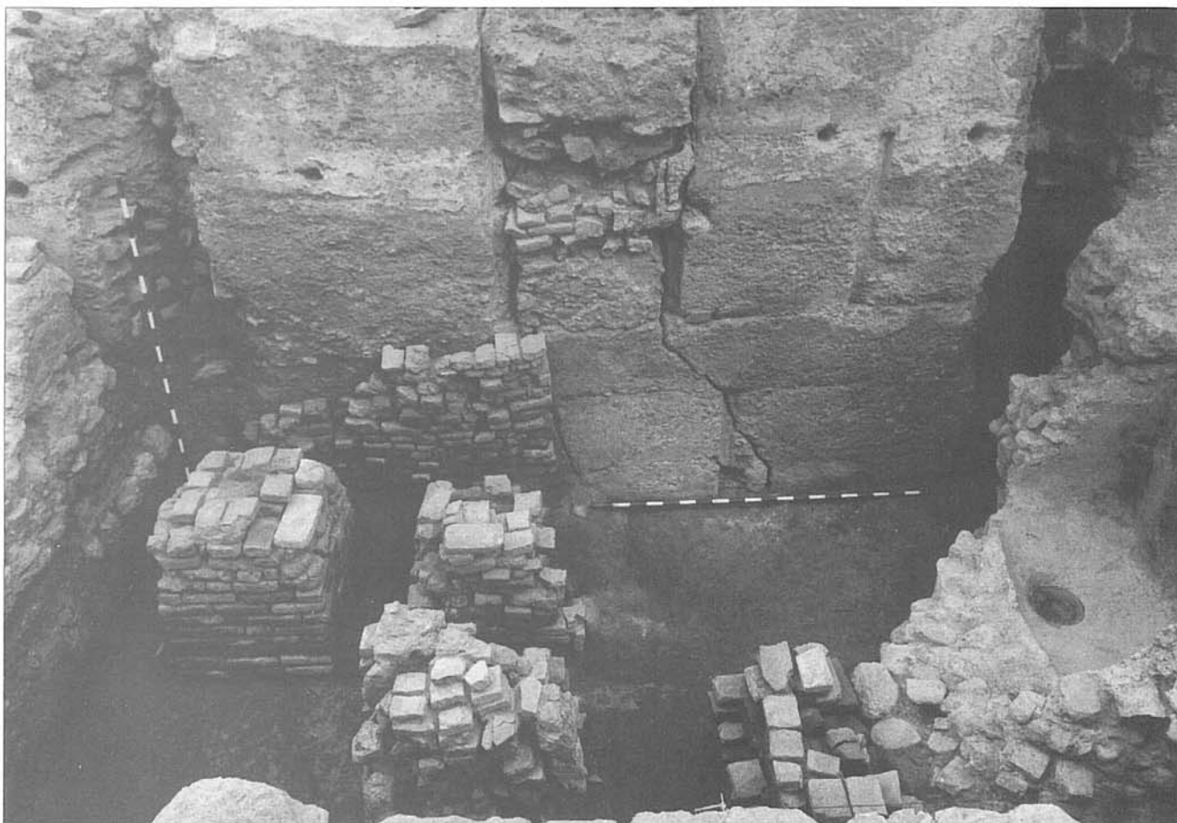
Fig. 6.- Baño de San Nicolás. Vista de su hipocausto. A la derecha el depósito cristiano con un plato en su interior. Al fondo la puerta tapiada que comunicaba la sala caliente con la templada.
