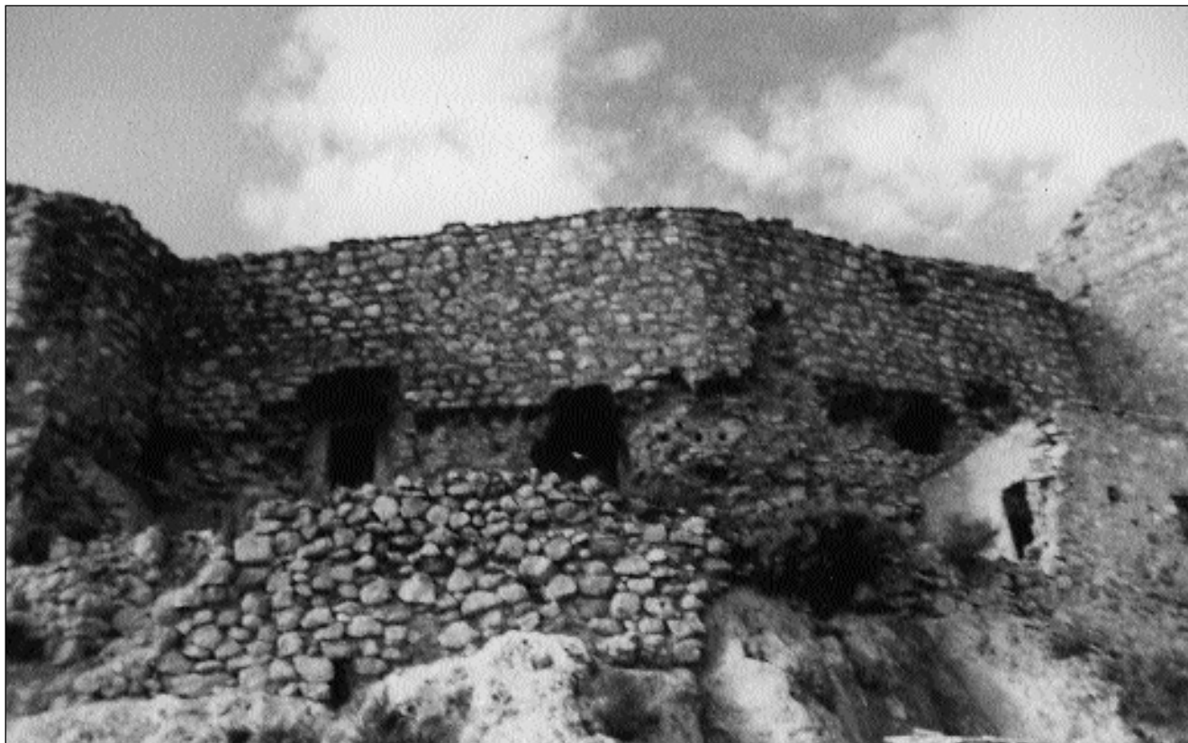
Lámina 1. C/. San Ramón. Torre y lienzo de muralla antes de la intervención (año 1985).
