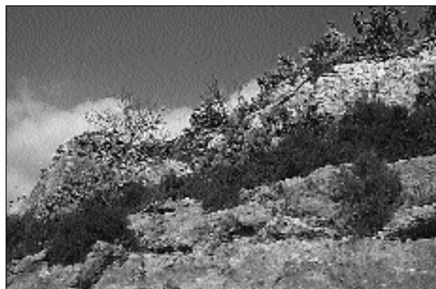
Lámina 23. Sector Oeste del antemuro. Vista general antes de la intervención (año 1990).
