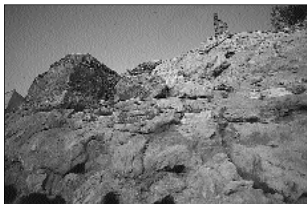
Lámina 24. Sector Oeste del antemuro, tras la intervención (año 1991). A la izquierda de la imagen, «La Torrecilla»; en la parte superior del escarpe, restos de la muralla principal.
