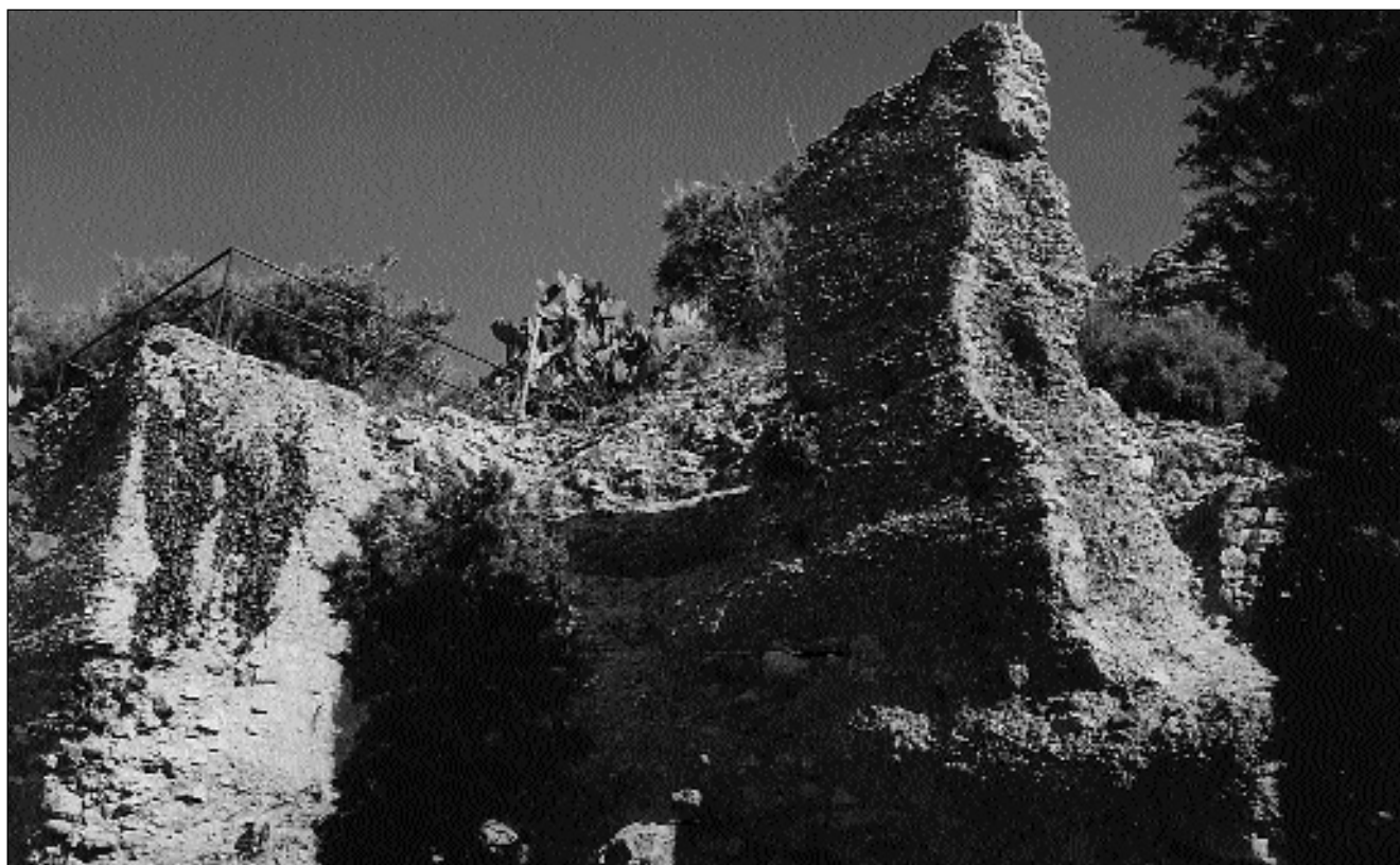
Lámina 16. Lienzo del antemuro inmediato al torreón, durante la intervención (año 1991).
