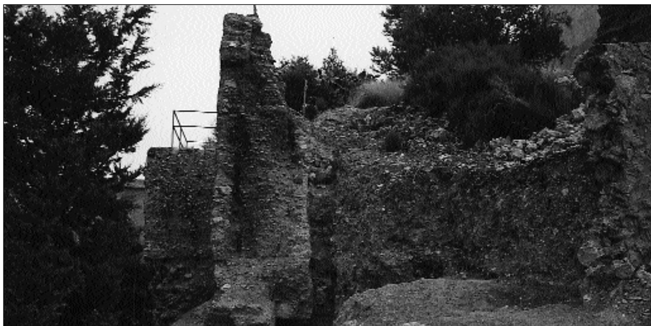
Lámina 20. Lienzo del antemuro inmediato al torreón. Vista de la sección del muro y de la superposición de estructuras defensivas.
