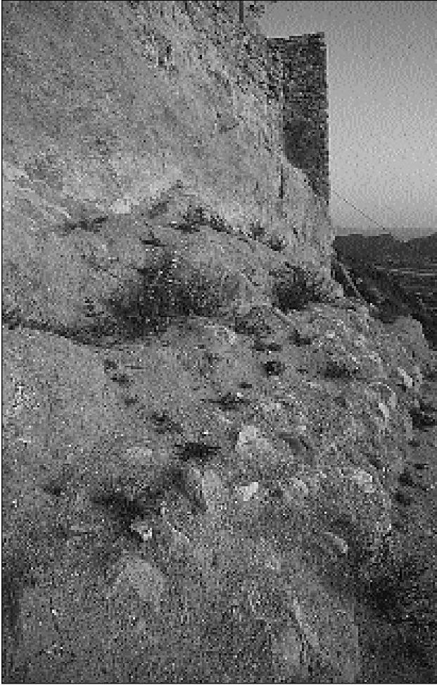
Lámina 25. Tramo Oeste del antemuro, en primer término de la imagen, visto desde el Norte. Al fondo, lienzo saliente de la muralla principal.
