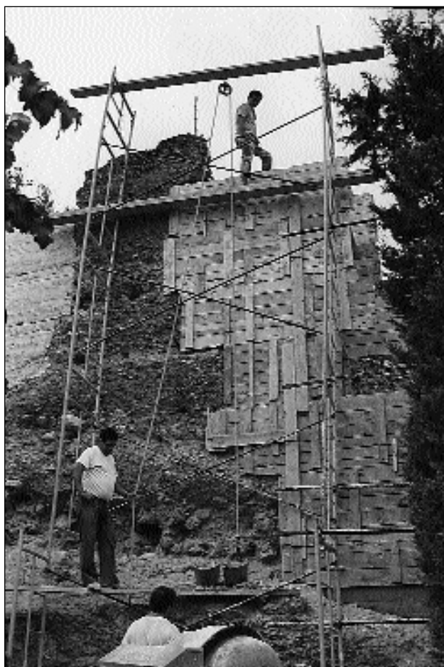
Lámina 18. Lienzo del antemuro inmediato al torreón. Proceso de encofrado.
