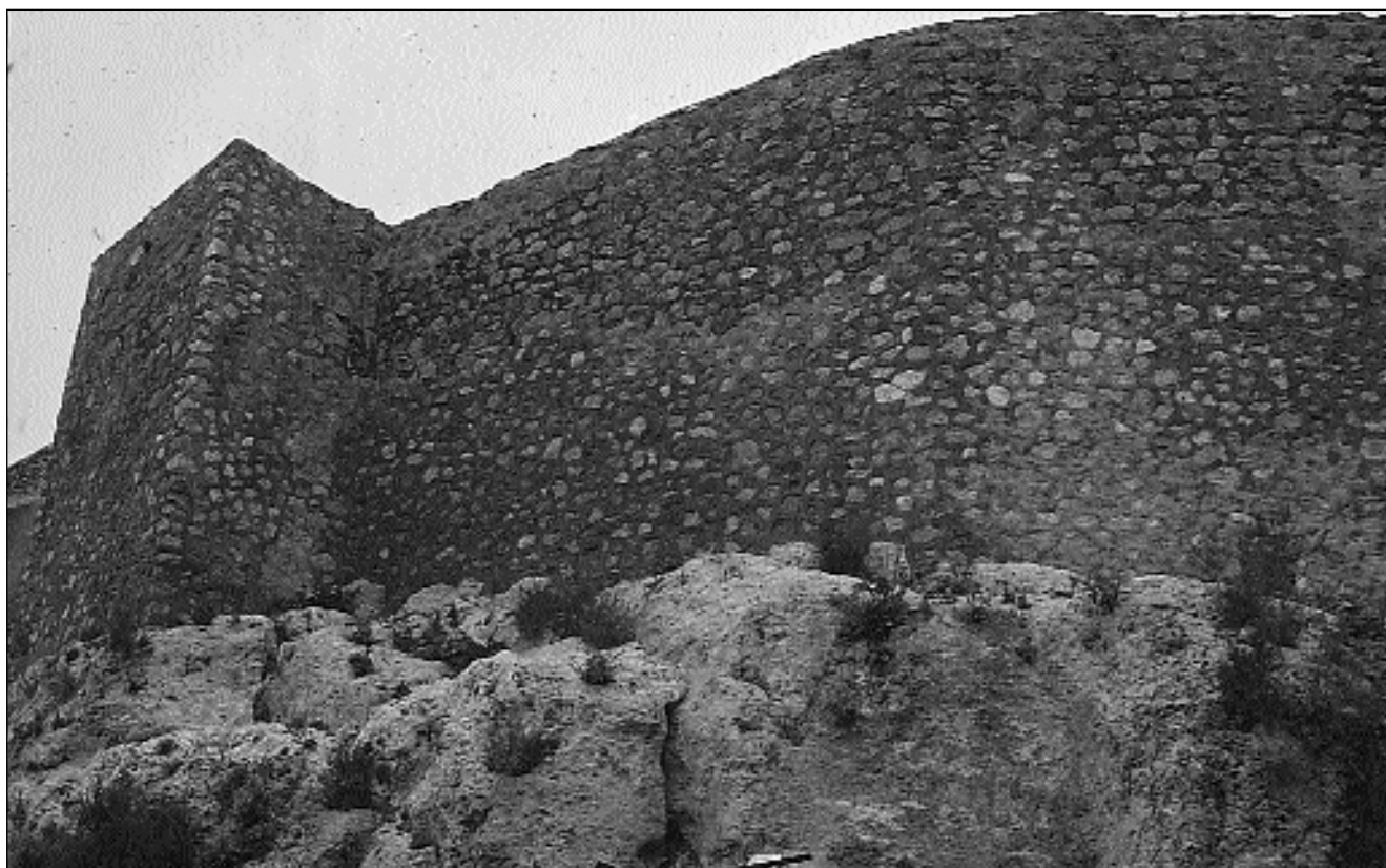
Lámina 2. C/. San Ramón. Torre y lienzo de muralla después de la intervención (año 1985).
