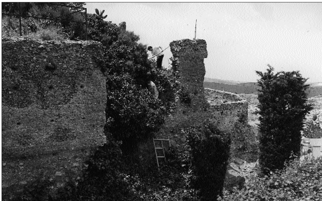
Lámina 17. Lienzo del antemuro inmediato al torreón (retirada de la cobertera vegetal).
