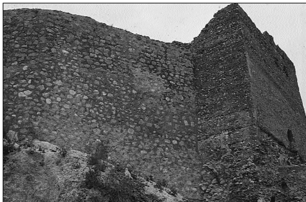
Lámina 6. Torre de La Calahorra, vista desde el Sureste, antes de la intervención (año 1990).
