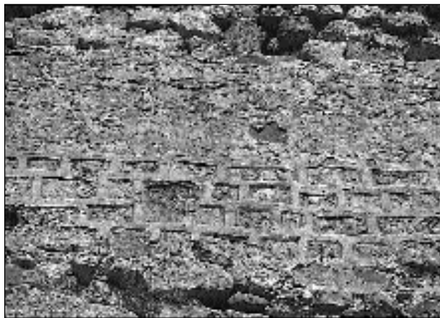
Lámina 14. Lienzo saliente. Detalle de la fábrica y tratamiento de la superficie.
