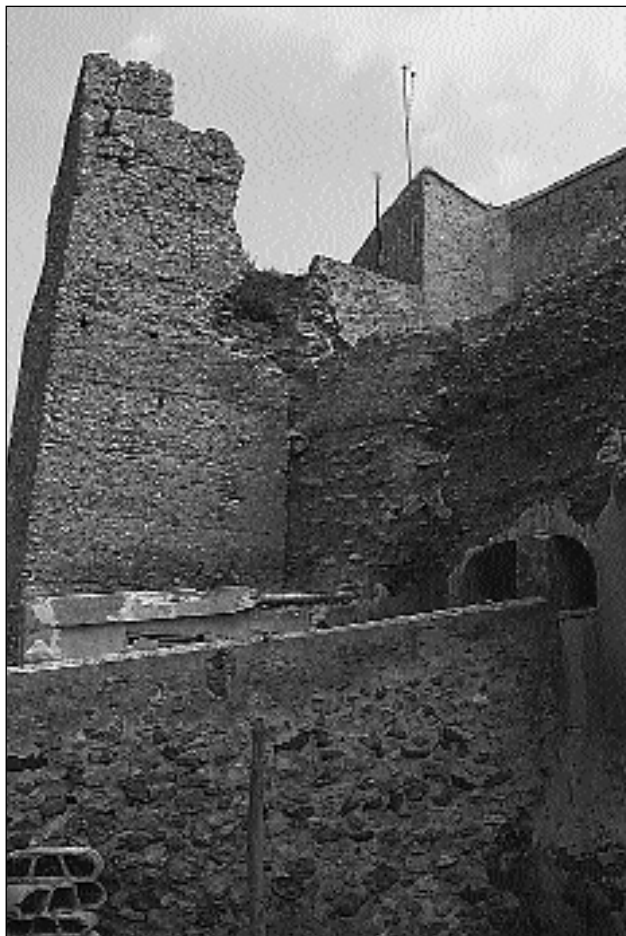
Lámina 8. Torre de La Calahorra, vista desde el Oeste, antes de la intervención (año 1990).
