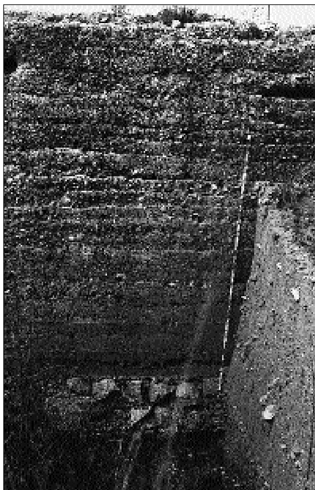
Fig. 49. Puerto de La Cadena. Portazgo Rec. Inf.: muro perimetral occidental.
