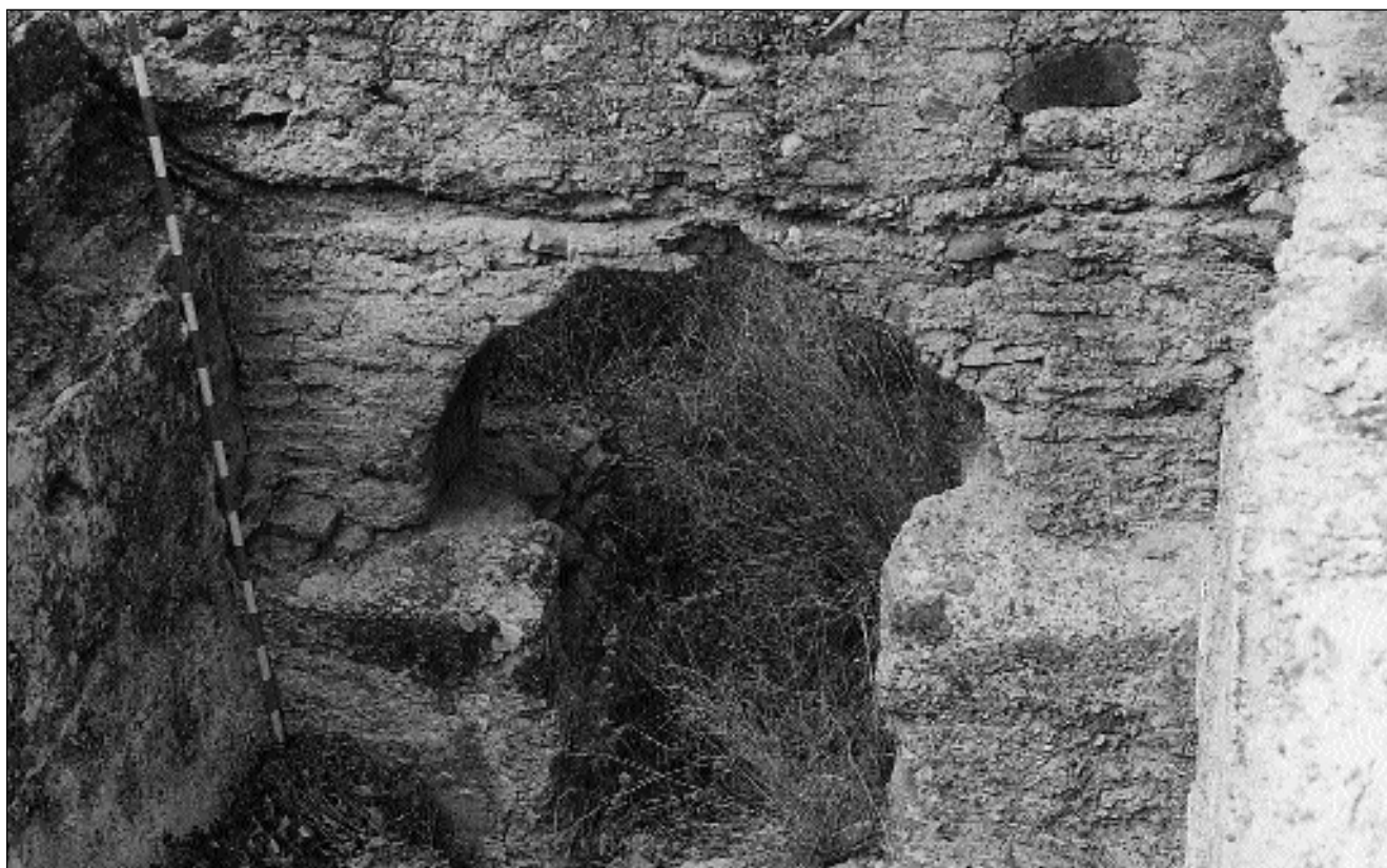
Fig. 46. Puerto de La Cadena. Portazgo Rec. Sup.: crujía septentrional. Vano de comunicación entre dependencias.
