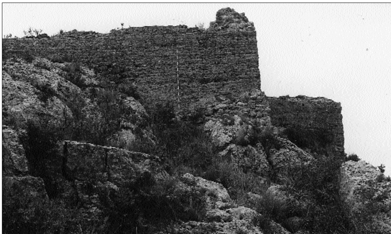
Fig. 41. Puerto de La Cadena. La Asomada. Angulo NE de la fortificación: torres de esquina.
