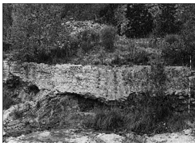
Fig. 51. Puerto de La Cadena. Entorno: rambla del Puerto / Acueducto. Detalle de la obra.
