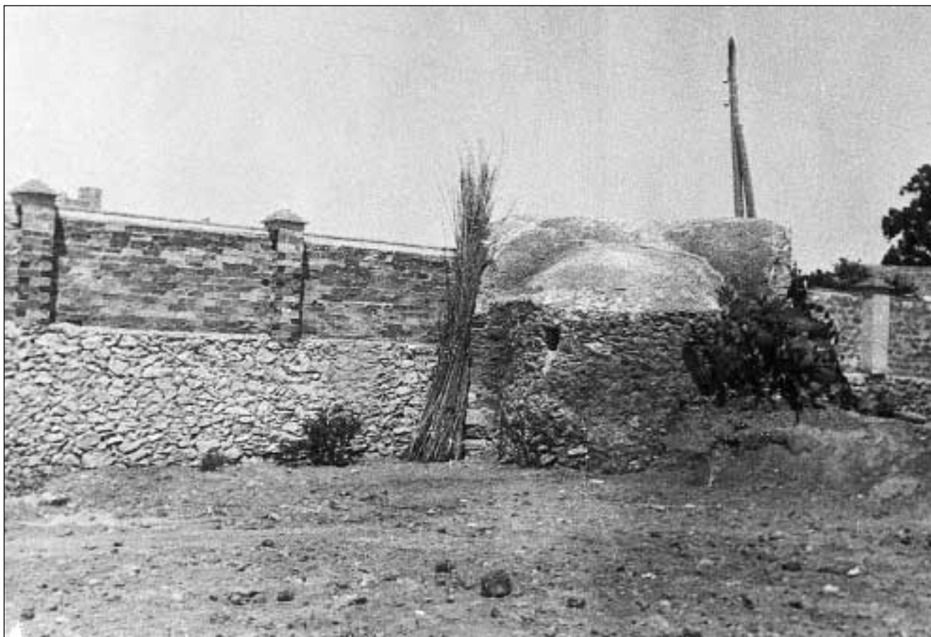
Lámina 6. Sepulcro de Jumilla ("Casón"). 1953. Vista desde el SO tras la construcción de un cercado de mampostería y ladrillo que apoyaba directamente en el mausoleo y las remociones de tierras que dejaron el cimacio del absidiolo meridional al descubierto (foto J. Tamés, Informe sobre obras efectuadas en el Casón de Jumilla y Catedral de Murcia. Monumentos Nacionales. 1953-IX-25. Ministerio de Educación, Cultura y Deporte, Secretaría de Estado de Cultura, Gabinete Archivo Central, c/ 88617).
