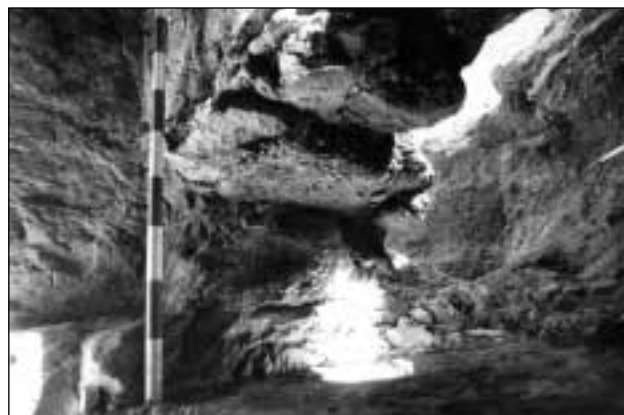
Lámina 21. Sepulcro de Jumilla ("Casón"). Cara interna de la fachada principal. Detalle de los restos del hastial N originario sobre el que apoya la zapata de cimentación del nuevo hastial restaurado a inicios del s. XX; al fondo, agujero de entrada del agua a través de la Cata nº 2.
