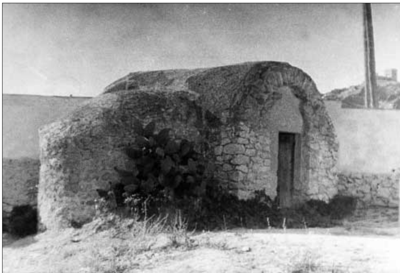
Lámina 7. Sepulcro de Jumilla ("Casón"). 1954. Vista desde el SE tras la construcción de un cercado de mampostería y ladrillo que apoyaba directamente en el mausoleo (foto J. Tamés, Propuesta de obras de consolidación y acondicionamiento en el "Casón" de Jumilla (Murcia). Monumento Nacional. 1954-X-8 ) (Expediente sobre obras urgentes en el "Casón" de Jumilla (Murcia), Monumento Nacional, importante, 10.000'00 pesetas. Ministerio de Educación, Cultura y Deporte, Secretaría de Estado de Cultura, Gabinete Archivo Central, c/ 87399).
