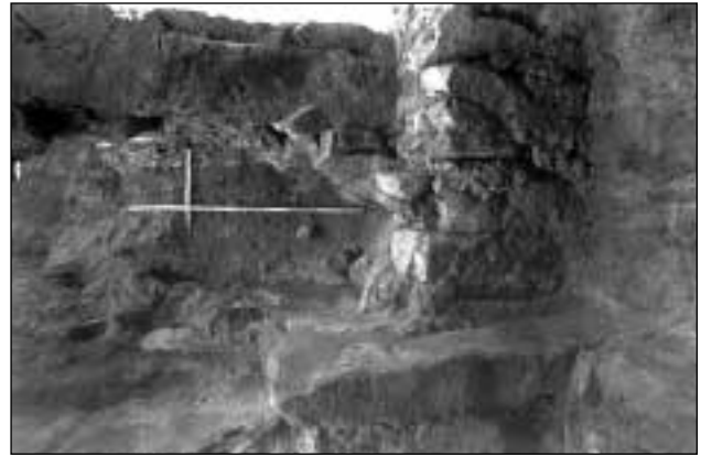
Lámina 19. Sepulcro de Jumilla ("Casón"). Cara interna de la fachada principal. Detalle de los restos del hastial S originario sobre el que apoya la zapata de cimentación del nuevo hastial restaurado a inicios del s. XX.
