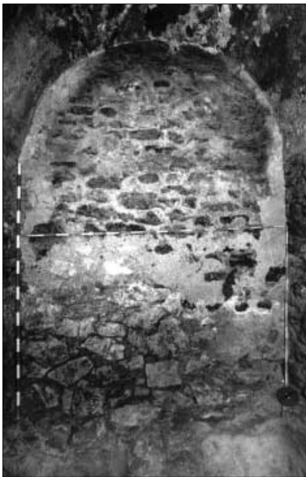
Lámina 8. Sepulcro de Jumilla ("Casón"). 1996. Muro interior reparado del testero de la nave central. La textura de la fábrica del tercio inferior evidencia la restauración de inicios del s. XX (foto A. López).
