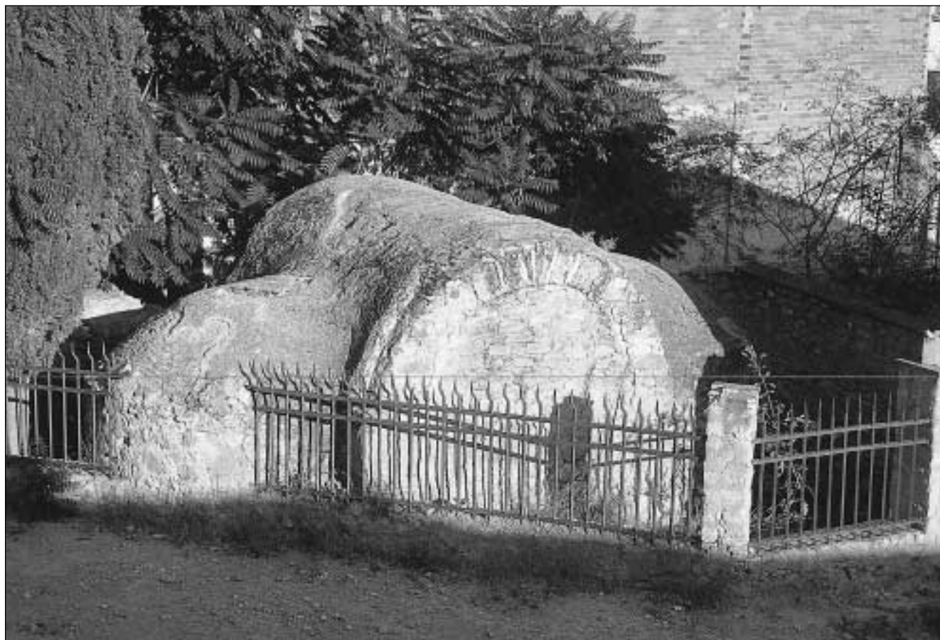
Lámina 1. Sepulcro de Jumilla ("Casón"). Julio de 1999. Cerco y verja de protección construido en 1956-1957. Nótese que el cercado apoya directamente en el absidiolo septentrional al haberse construido a tan sólo 1'60 m del mausoleo la línea férrea Jumilla-Cieza, cuyo antiguo trazado se aprecia en primer plano.
