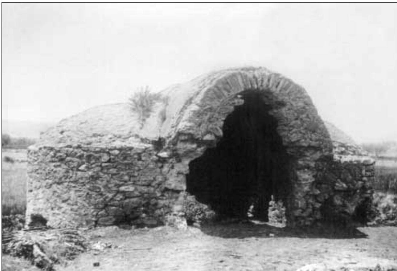
Lámina 2. Sepulcro de Jumilla ("Casón"). Fines del s. XIX–inicios del XX. Fachada principal arruinada (González Simancas, Catálogo Monumental de la Provincia de Murcia, 1905–1907 ) (Foto Archivo Centro de Estudios Históricos, CSIC).
