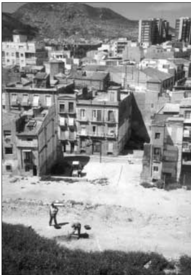
FOTO 2. Labores de limpieza en la terraza occidental del Cerro del Molinete.
