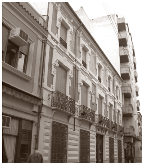
FACHADA PRINCIPAL. POSTERIOR A LA INTERVENCIÓN.
