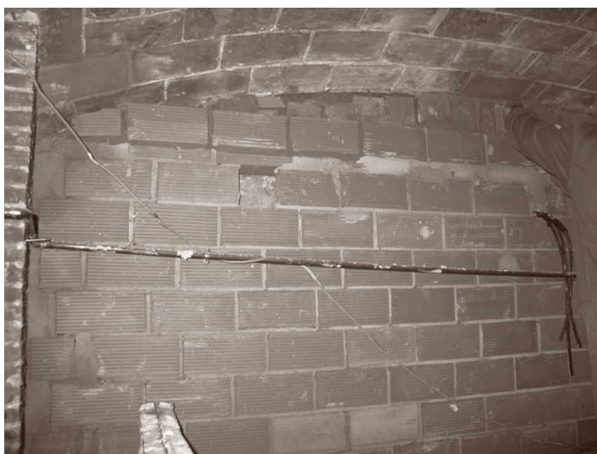
SOLUCIÓN DE HUMEDADES. DURANTE LA INTERVENCIÓN.
