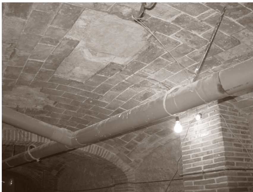
DURANTE LA INTERVENCIÓN. SUSTITUCIÓN DE LADRILLOS IRRECUPERABLES
