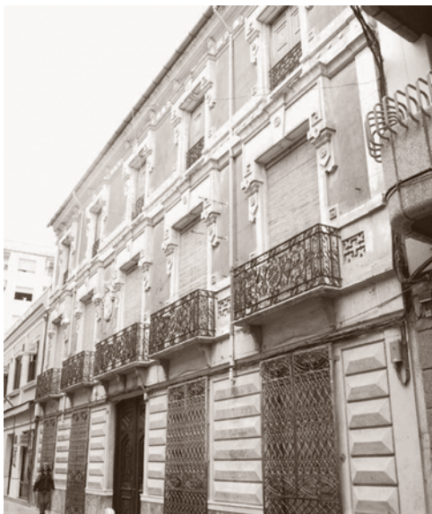
FACHADA PRINCIPAL. ANTERIOR A LA INTERVENCIÓN.
