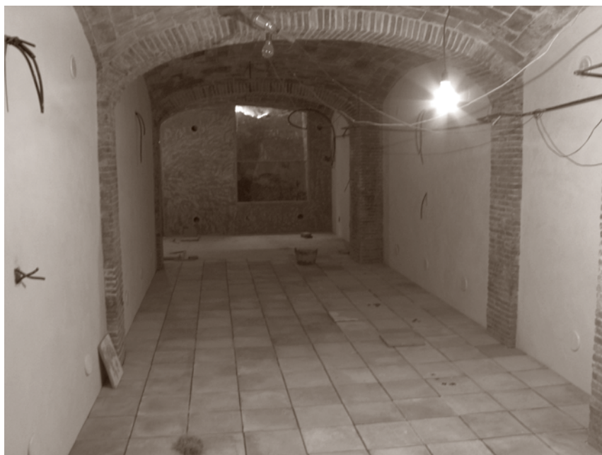
POSTERIOR A LA INTERVENCIÓN
