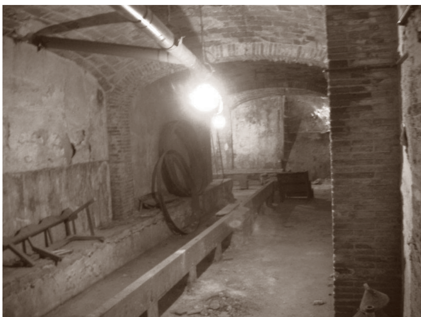
SÓTANO-BODEGA. ANTERIOR A LA INTERVENCIÓN
