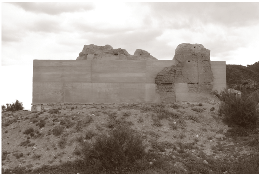
CARA SUROESTE. POSTERIOR A LA INTERVENCIÓN. (EJLM).
