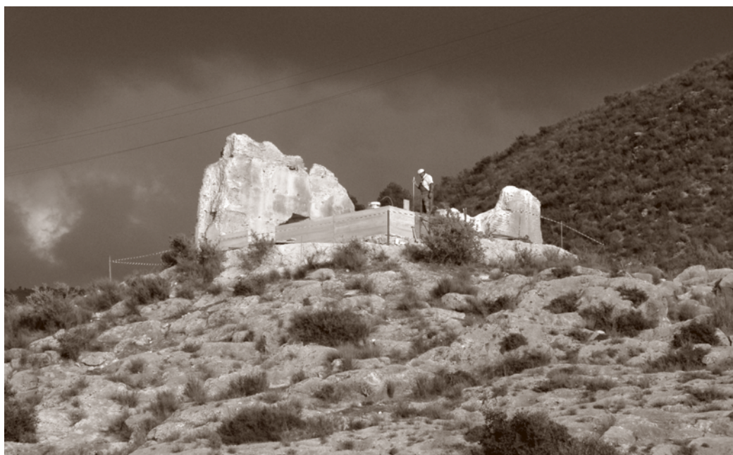
VISTA OESTE DURANTE LAS OBRAS. (FJLM).
