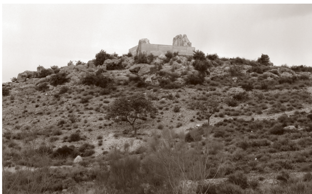
VISTA SUR. POSTERIOR A LA INTERVENCIÓN. (FJLM).
