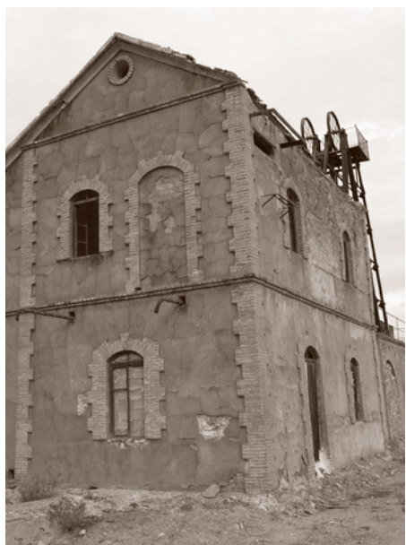
CASA DE MAQUINAS DEL CASTILLETE SAN CARLOS.
