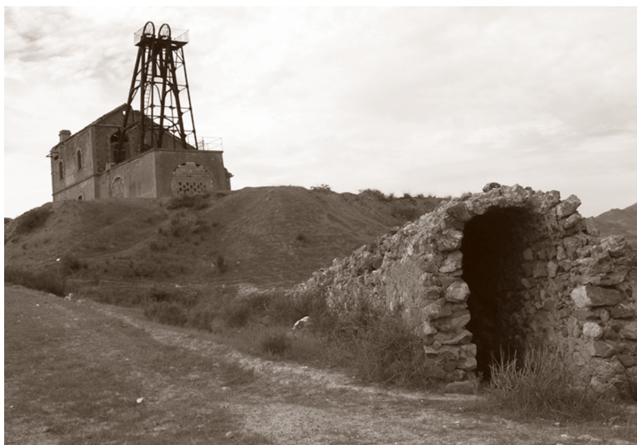
TRANCADA DEL POZO SAN CARLOS.
