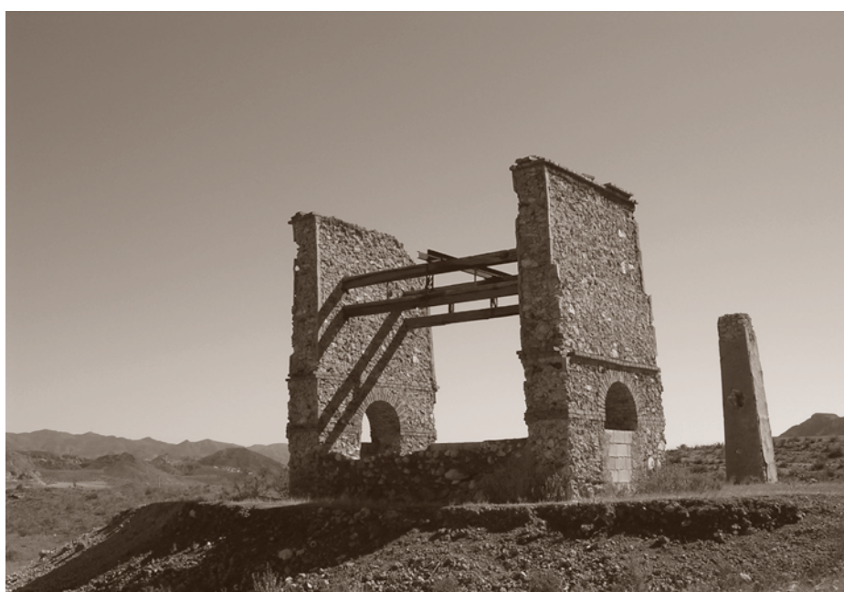
CASTILLETE DE MAMPOSTERÍA DEL POZO MAQUINA
