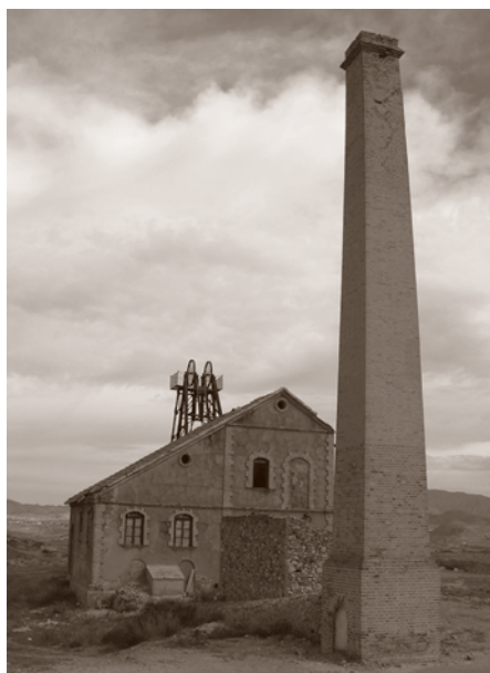
CHIMENEA DE MAQUINA DE VAPOR DEL POZO SAN CARLOS.
