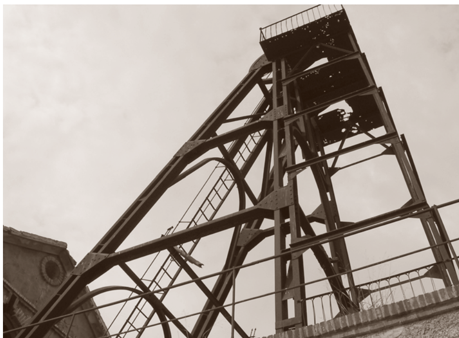
CASTILLETE METÁLICO DEL POZO SAN CARLOS.
