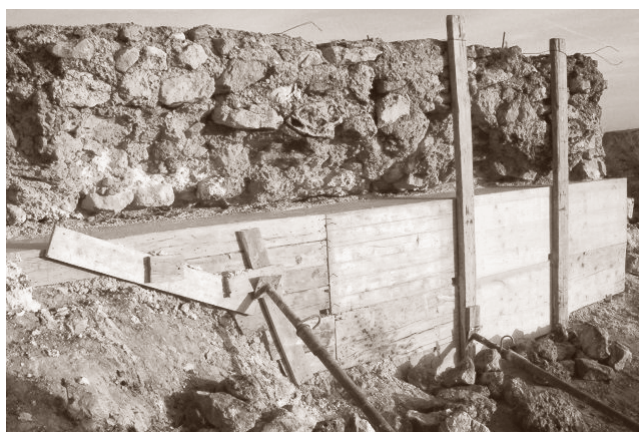
DURANTE LA INTERVENCIÓN. MURO NORTE.
