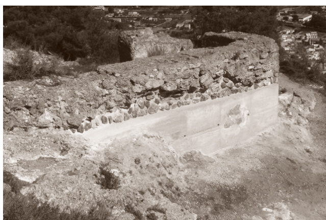
POSTERIOR A LA INTERVENCIÓN. MURO NORTE.
