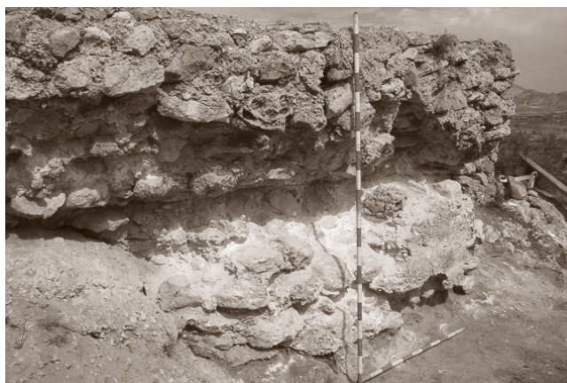
ANTERIOR A LA INTERVENCIÓN. MURO NORTE.
