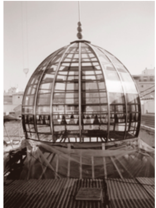
POSTERIOR A LA INTERVENCIÓN
