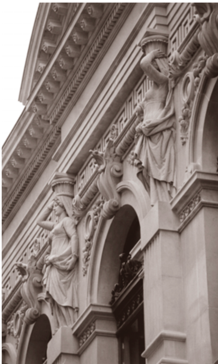
POSTERIOR A LA INTERVENCIÓN
