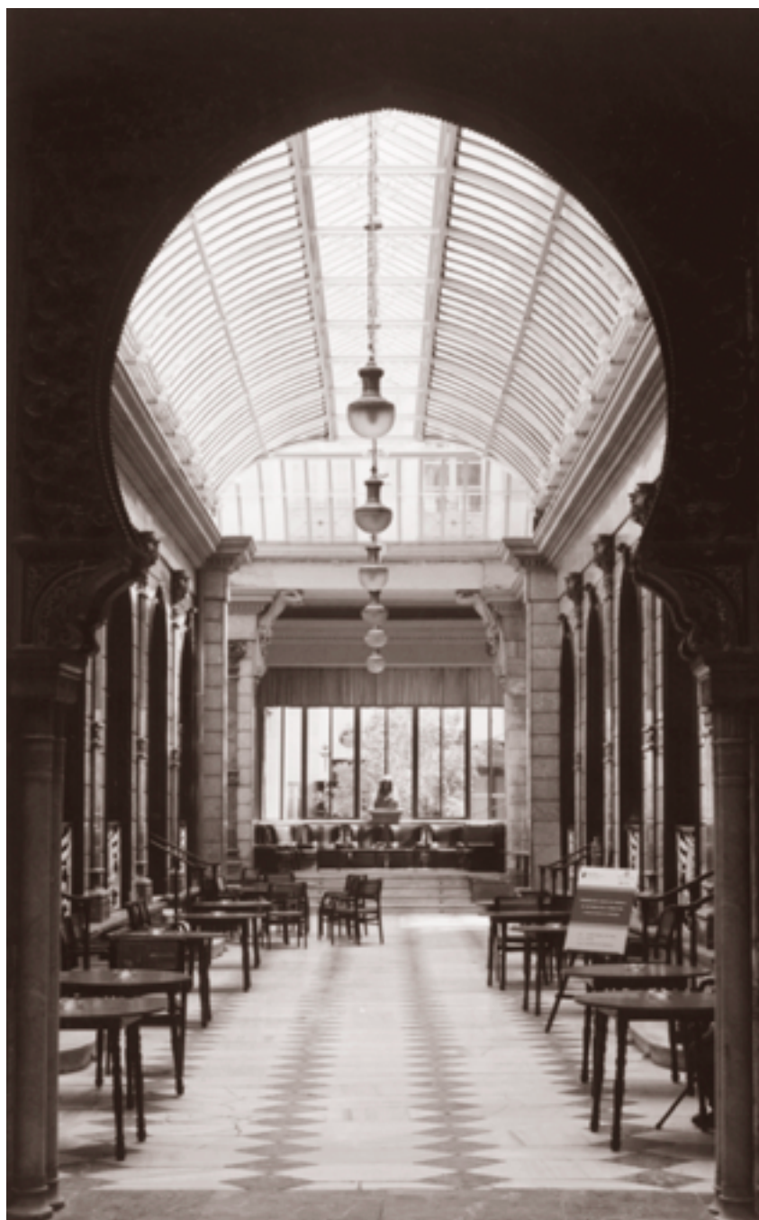
POSTERIOR A LA INTERVENCIÓN
