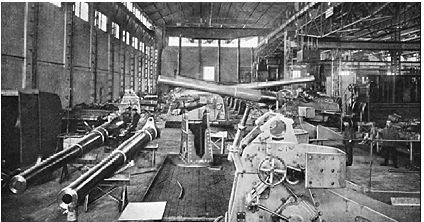
Nave de ajuste y montura de cañones de costa de 15 cm.
