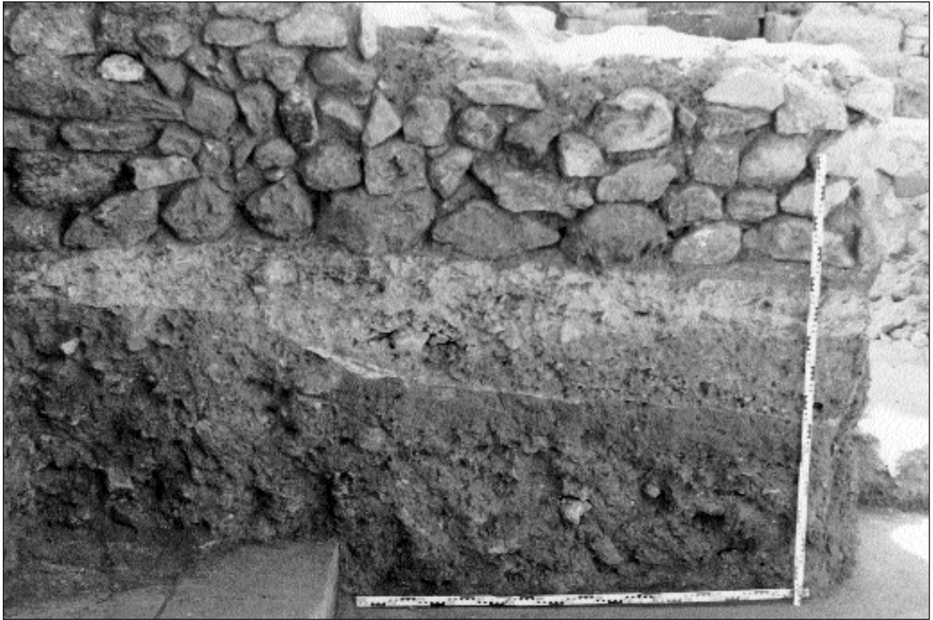
Lám. 12.- Detalle del estrato de nivelación que aplana los desniveles provocados por las construcciones del teatro.
