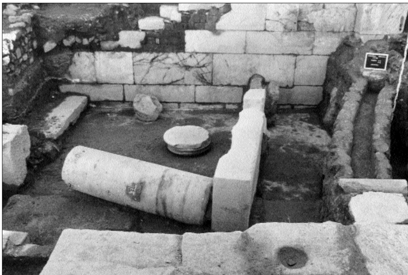
Lám. 10.- Elementos arquitectónicos y dintel epigráfico desplomados sobre el pavimento junto al aditus occidental.
