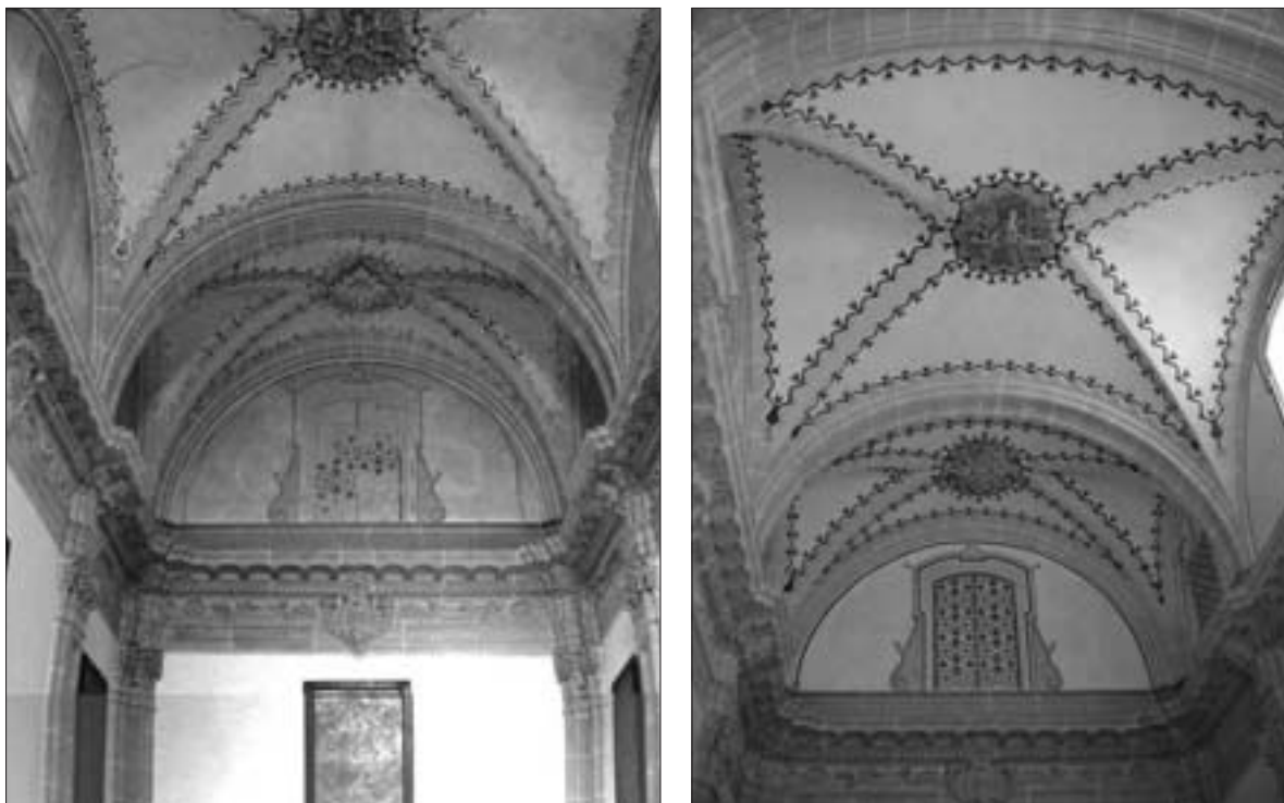
Vista general del estado de la sacristía antes y después de la intervención.
