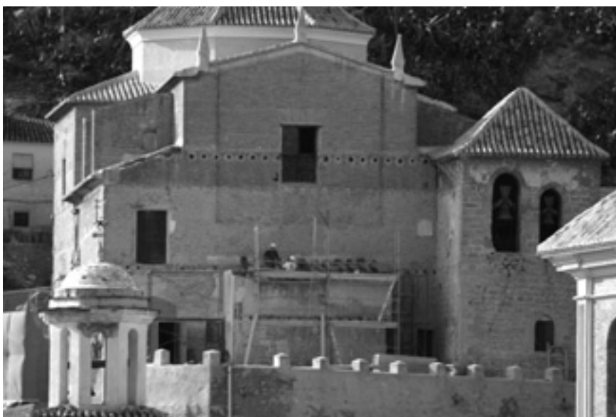
Ermita del Carmen, durante las labores de restauración.
