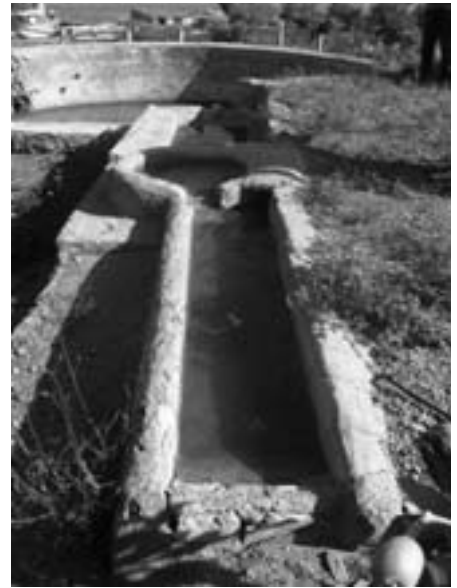
Sistema hidráulico en el Garrobillo.
