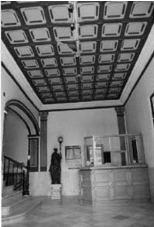
Vestíbulo de entrada del edificio. Se aprecia el arranque de la escalera, bajo un arco rebajado, así como el falso techo de escayola imitando un artesonado.
