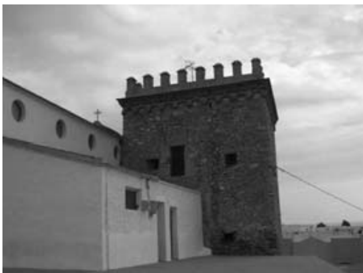
Lámina 5. Torre de los Caballos de Bolnuevo (Mazarrón) del siglo XVI a la que, entre 1946 y 1949, se le adosó una ermita dedicada a la Purísima Concepción y que fue construida en memoria del conocido “Milagro de la Virgen”.
