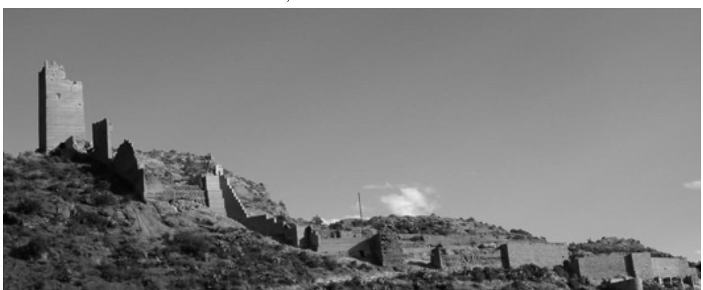
Castillo de Alhama. Restauración de muralla y torre.
