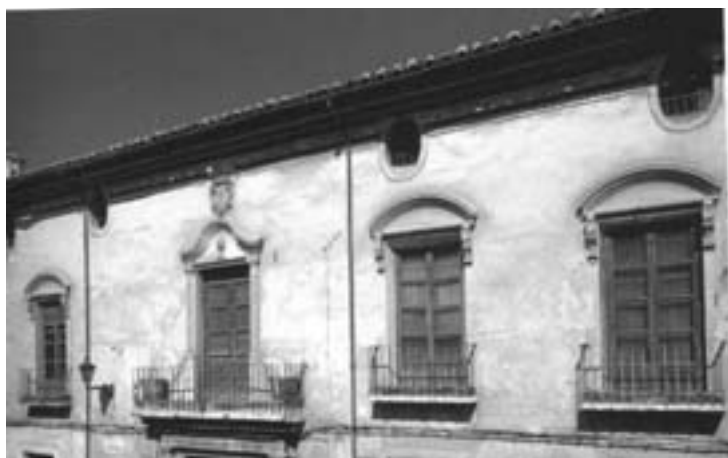
Casa-Tercia de la Encomienda de la Orden de Santiago en Caravaca.
