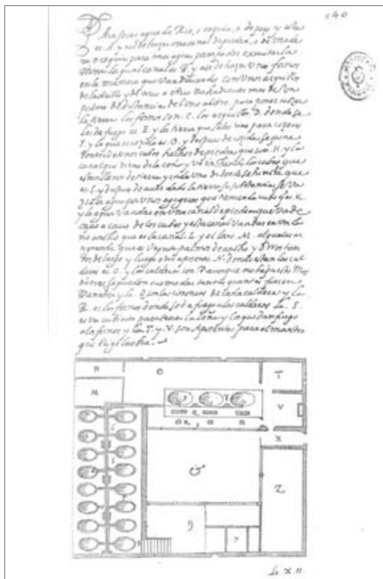
Figura 1. Planta de una fábrica de alumbres del siglo XVI, correspondiente al Volumen II, Tomo III, Libro trece de “Los Veintiún libros de los ingenios y máquinas”, de Juanelo Turriano.
