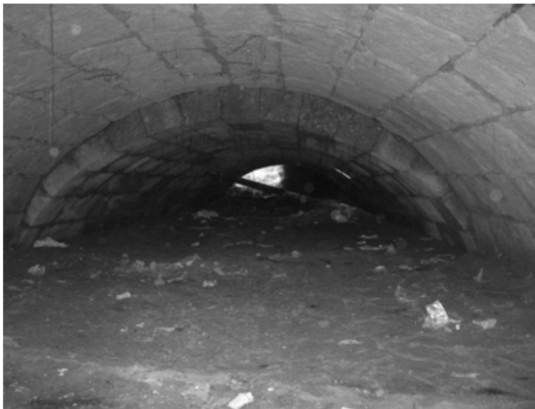
Plaza de España, fotografía interior de la bóveda del puente del siglo XVIII, realizada con sillares de caliza, observándose en primer plano la ampliación lateral en sillería de arenisca.
