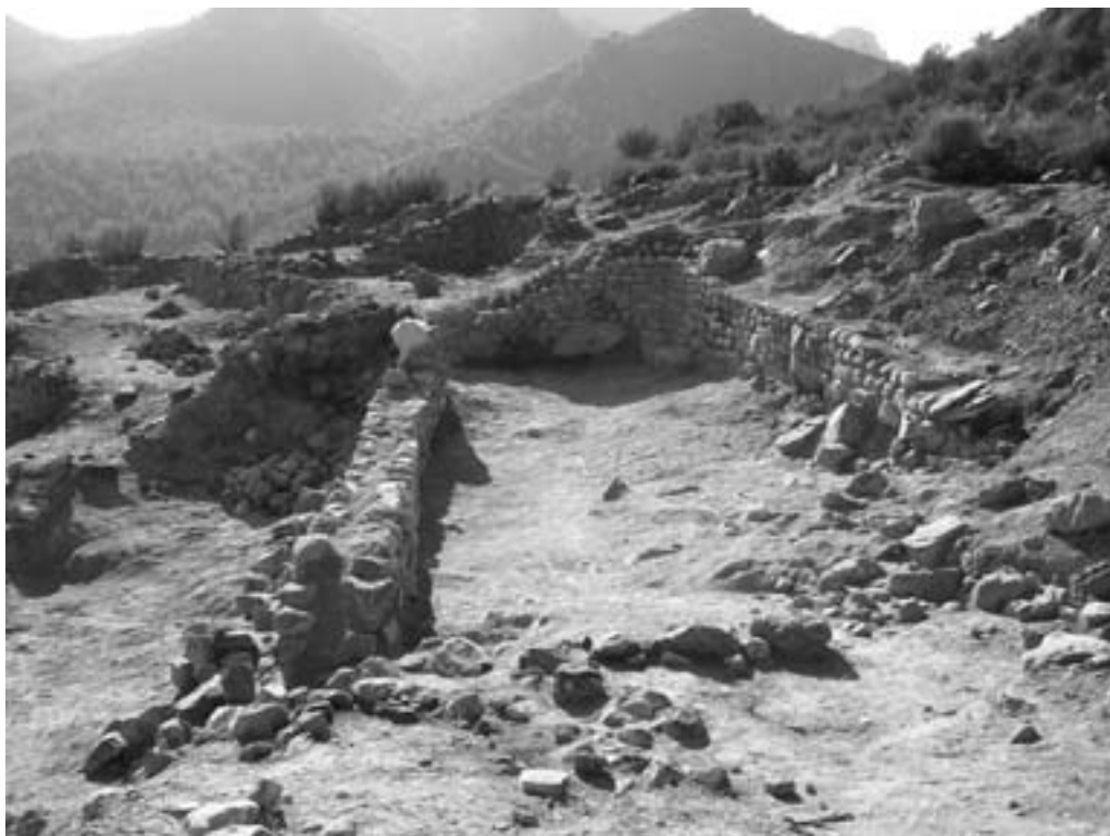
Lámina 2. Después de la intervención de consolidación y de protección de las estructuras del departamento XI en febrero del 2005.
