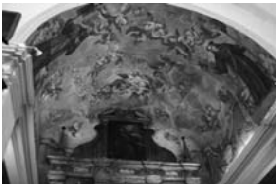
Vista de la bóveda del presbitero de la iglesia.
