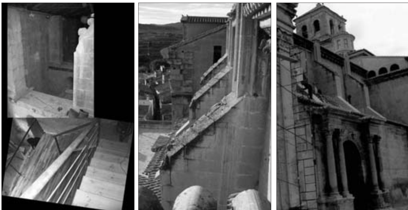
Izquierda: Vista parcial del espacio bajo cubierta. En primer término, la escalera y nueva plataforma de acceso. Detrás los contrafuertes góticos idénticos a los existentes en la fachada Sur (fotografías centro y derecha).
