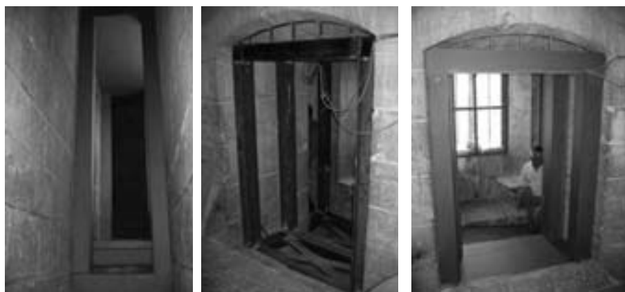
Imágenes de dos de los elementos colocados en el interior de la torre (el de la fotografía de la derecha aún no tenía colocado el forro de DM).
