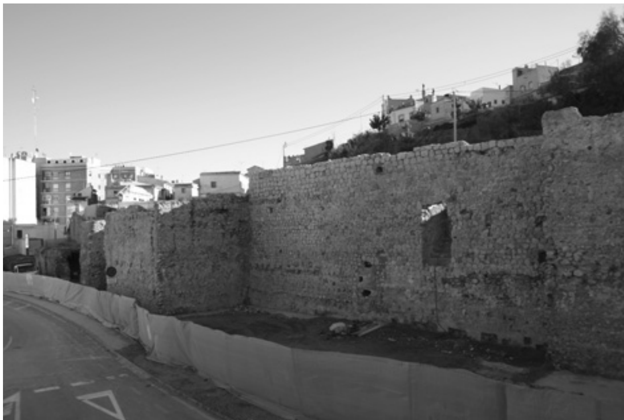
Vista del lienzo de muralla de la calle Rambla.
