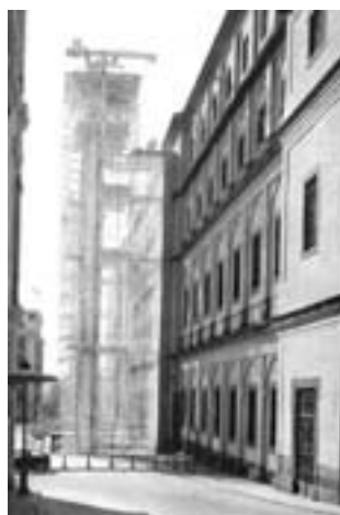
Torre de circulación vertical en el Museo Reina Sofía de Madrid.
