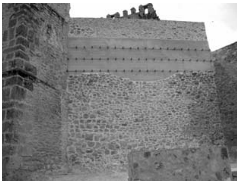
Figura 3. Paño exterior del Lienzo B-C restaurado.
