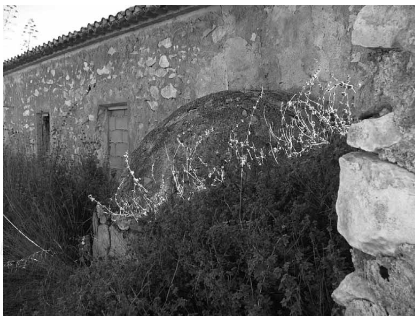
Lámina 2. Vista exterior del horno.
