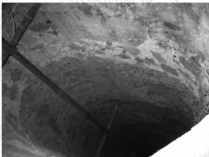
Lámina 2. Pozo de captación de agua contemporáneo.
