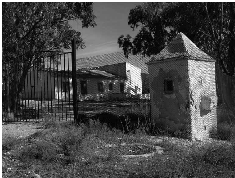
Lámina 1. Vista de la casa desde el exterior.
