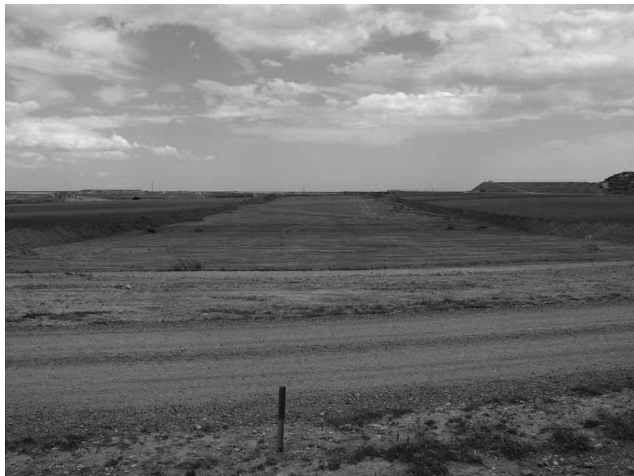
Lámina 1. Vista de la autovía de acceso a Mazarrón, en fase de construcción.
