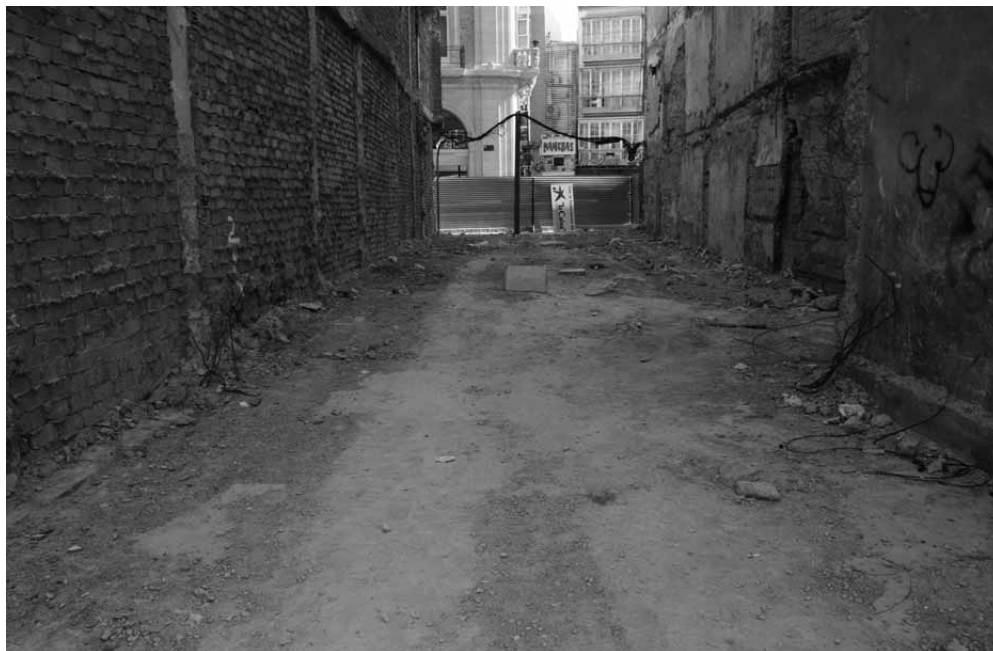
Lámina 1. Vista general del solar antes de comenzar los trabajos de cimentación.
