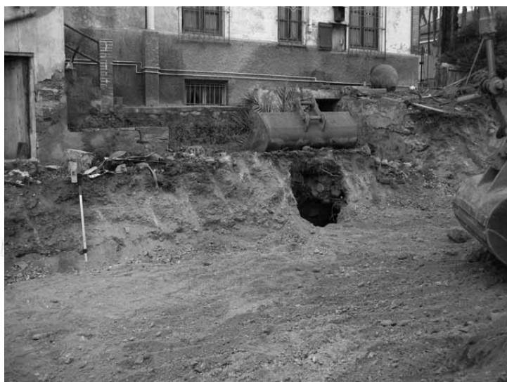
Lámina 1. Galería de captación de agua.
