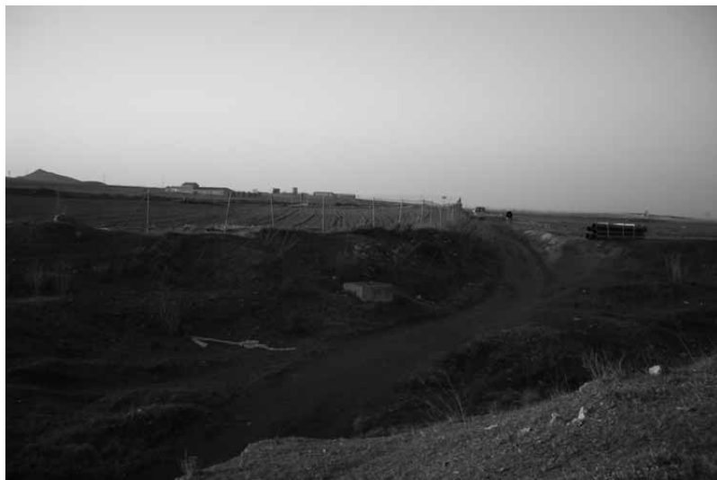
Lámina 1. Vista frontal del yacimiento de Los Ruices, situado junto al margen oeste de la Rambla del Miedo, donde se ha realizado la apertura de la zanja para inserción de tuberías de regadío.
