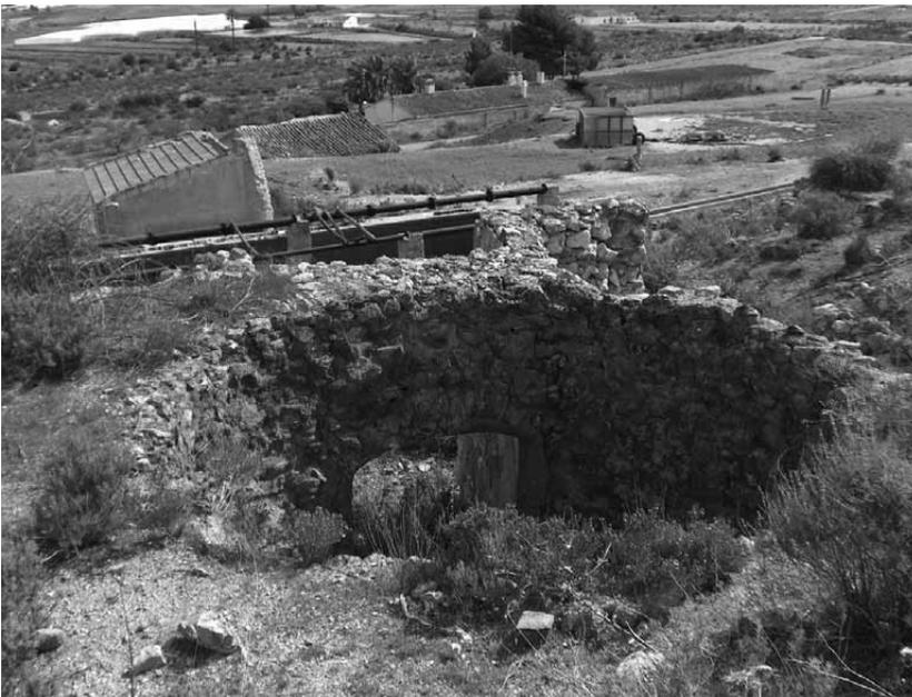
Lámina 4. Horno de calcinación de alunita ubicado en el Cabezo del Zorro.
