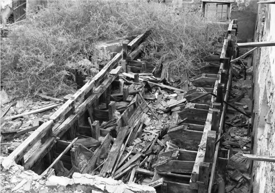
Lámina 12. Celdas de flotación del lavadero San Lázaro (Rambla de la Boltada).
