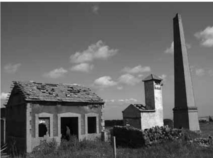
Lámina 3. Casa de máquinas, transformador de electricidad y chimenea de máquina de vapor de la mina San Juan Bautista (El Beal).
