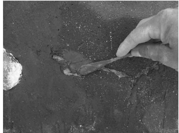
Antes de aplicar el mortero nuevo para la reconstrucción de los esgrafiados desaparecidos, y una vez comprobado que todos los elementos estaban bien consolidados, se humedecía toda la zona con agua destilada y se rayaba con cuidado la parte a reconstruir.
