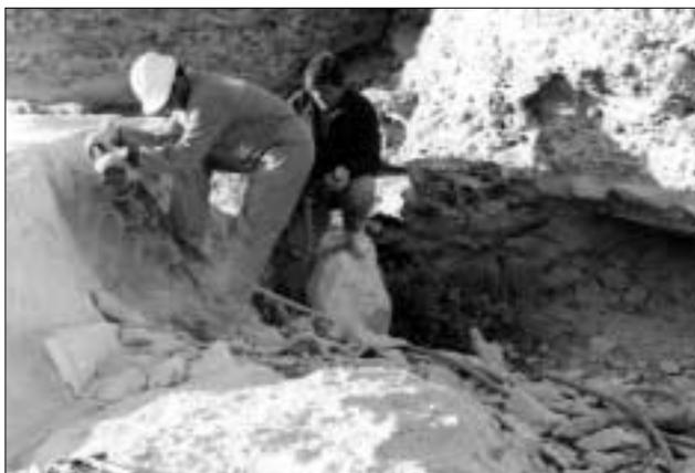
*Lámina 3. Extracción del estrato superior mediante martillo neumático.*
