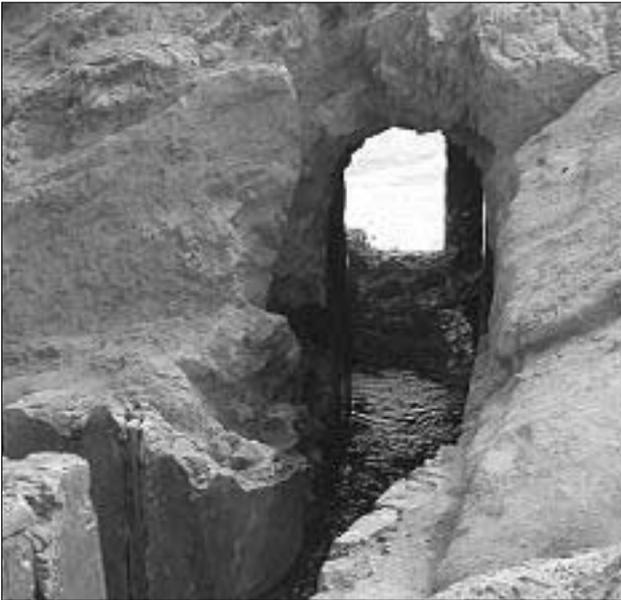
Figura 9. El extremo más oriental del peñón se encuentra atravesado por un canal construido para la recogida de agua para las salinas.
