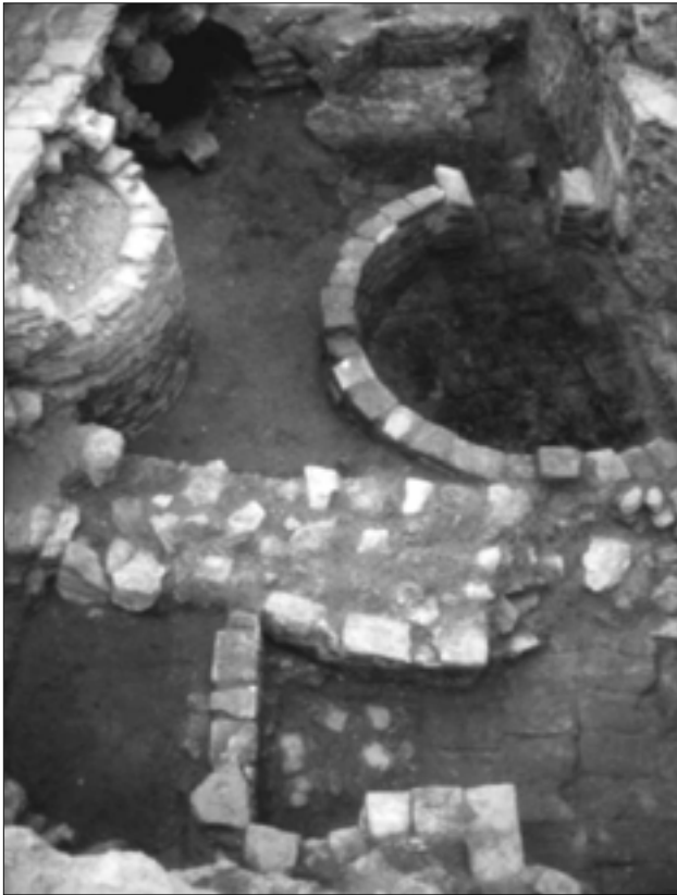
Lámina 1. Instalación artesanal en la barbacana.
